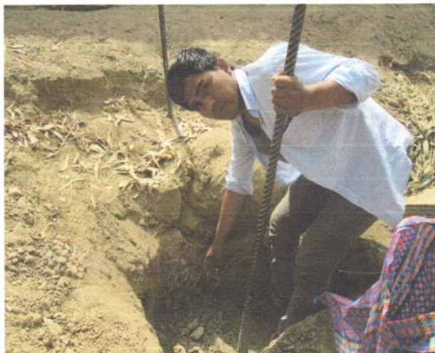
Foto N 03: Se aprecia la excavación de la calicata C-02, en la zona de Reservorio.
