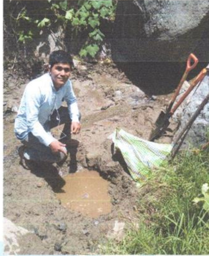
Foto N 01: Se aprecia la excavación de la calicata C-01, en la zona de captación.
