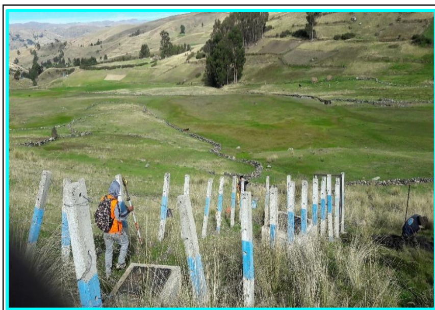
4. Levantamiento topográfico del Sistema de agua potable
