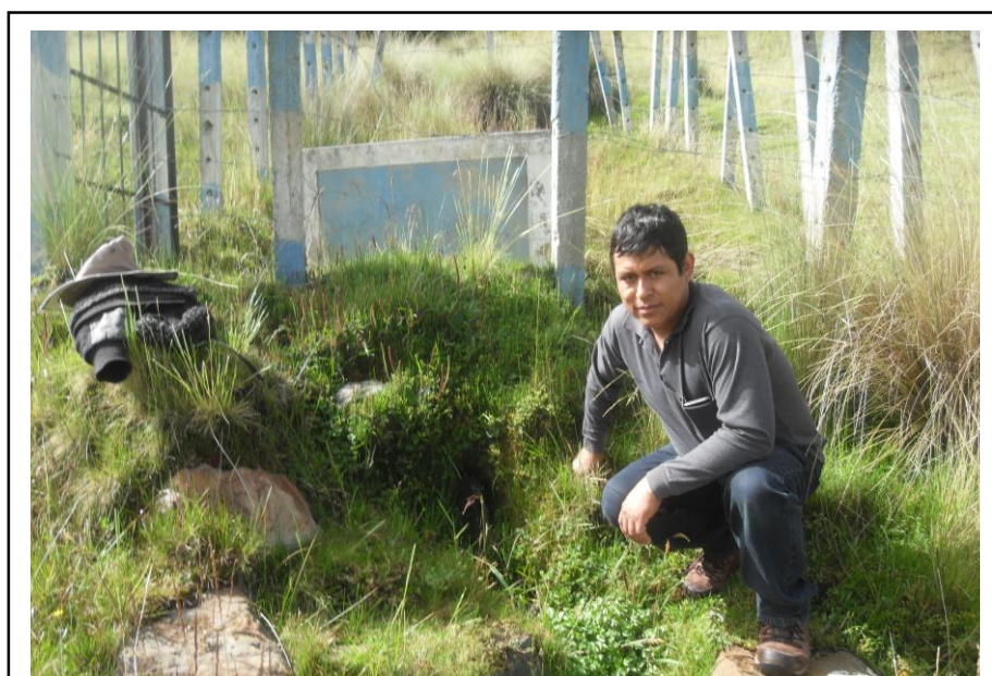
2. Desvío de agua en la 3 da captación
