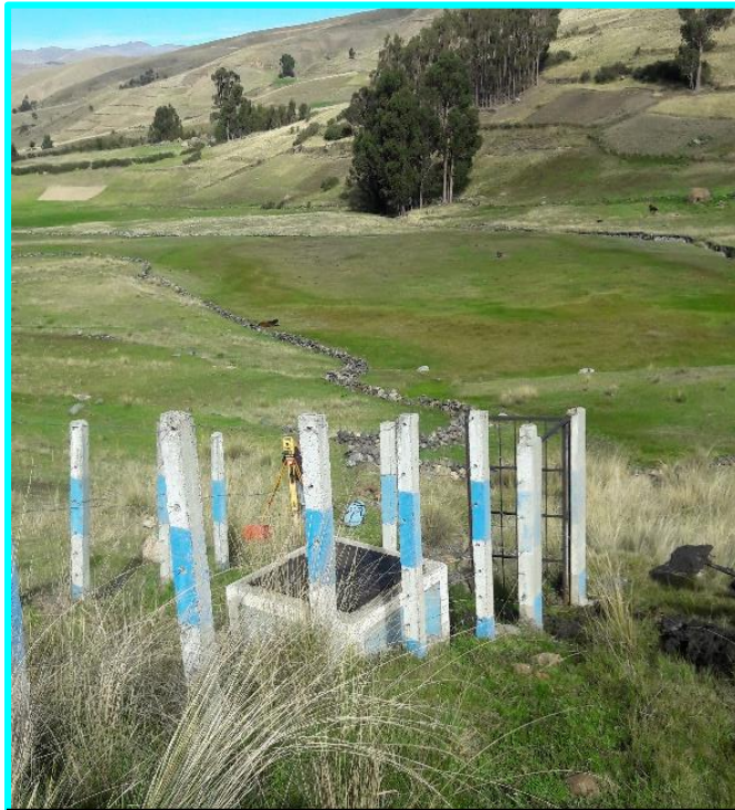
5. Equipos topográficos del sistema de agua potable
