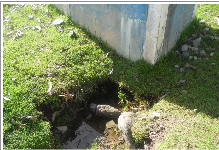
6. reservorio de agua fallido
