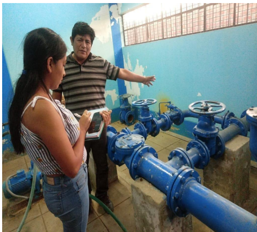
Imagen N°05 pozo de captación
