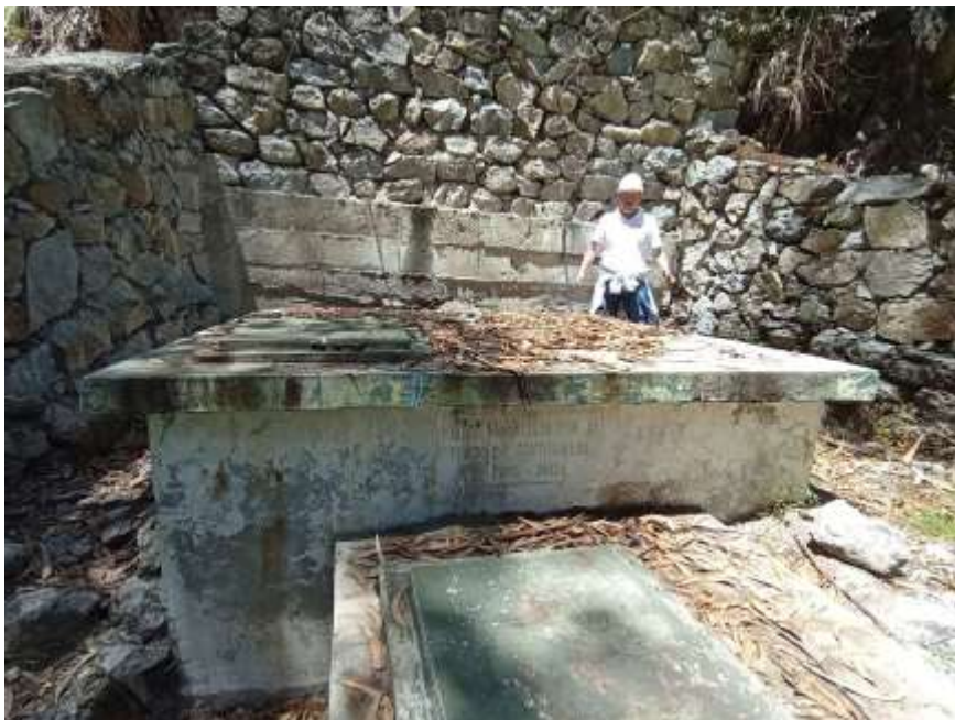
Fotografía 2. Vista Frontal del Reservorio.
