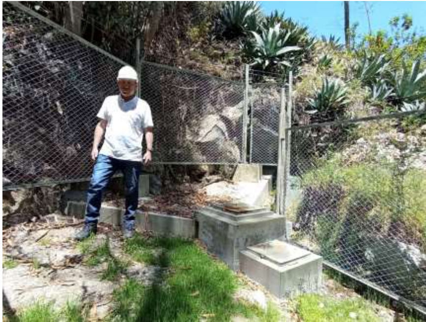
Fotografía 1. Vista Frontal de la Captación.
