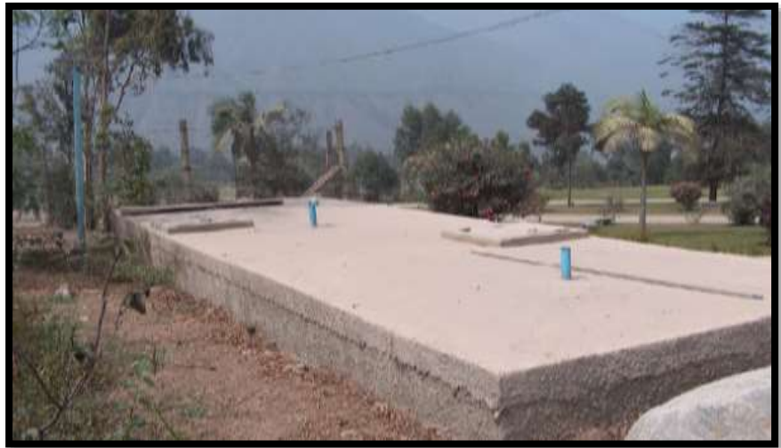
Figura 18: Reservorio enterrado.
