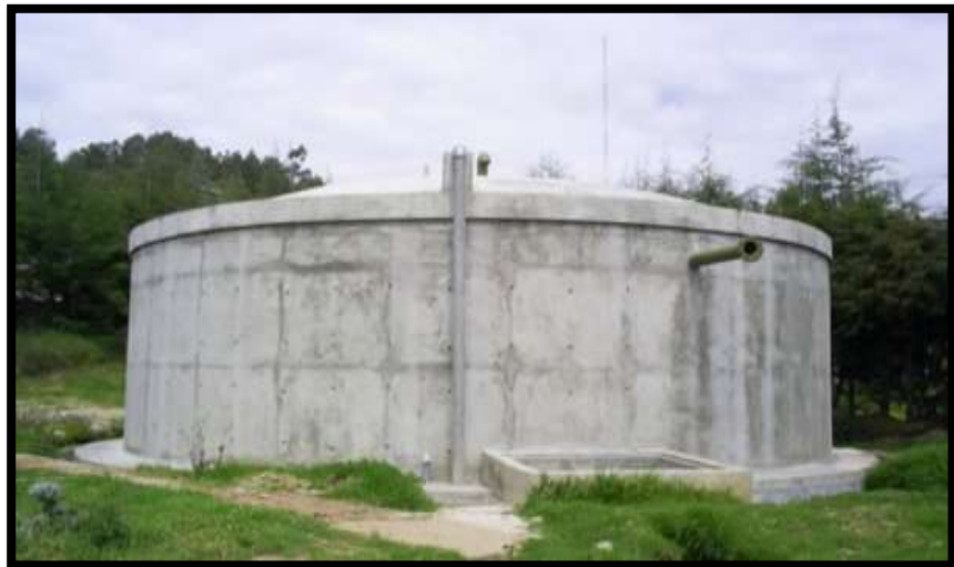
Figura 17: Reservorio apoyado. Fuente: Isem Perú.
