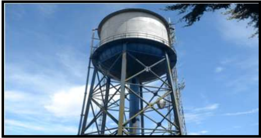
Figura 16: Reservorio elevado. Fuente: Hidropacifico.
