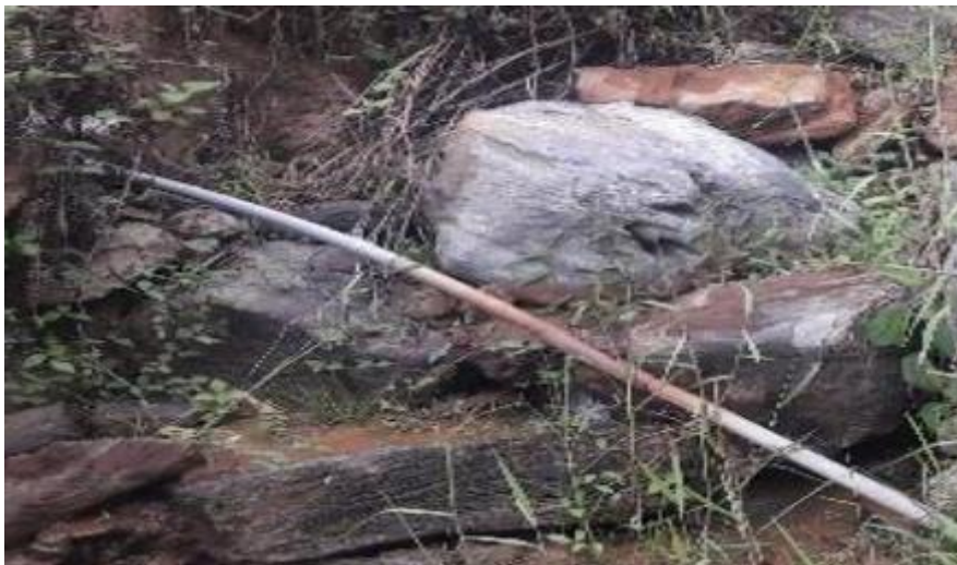
Imagen 5 Línea de aducción expuesta
