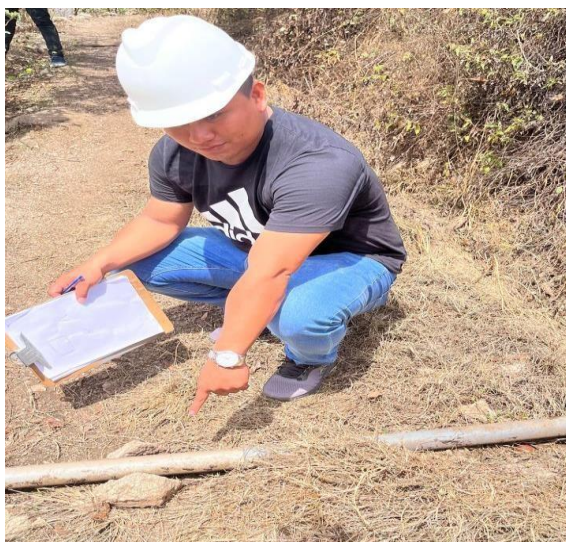
Imagen 3 línea de conducción expuesta
