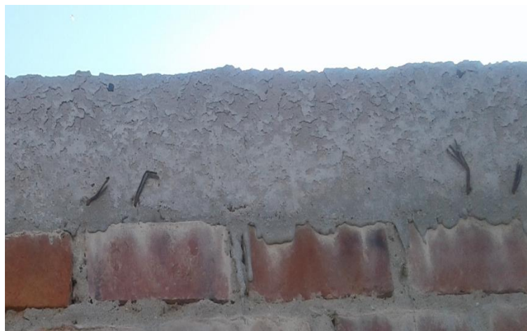
Figura 7 Fisuramiento
