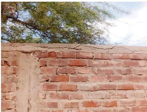
Figura 6 Agrietamiento en vigas
