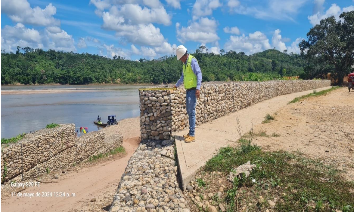
Fotografía N°05: Ancho del gavión
