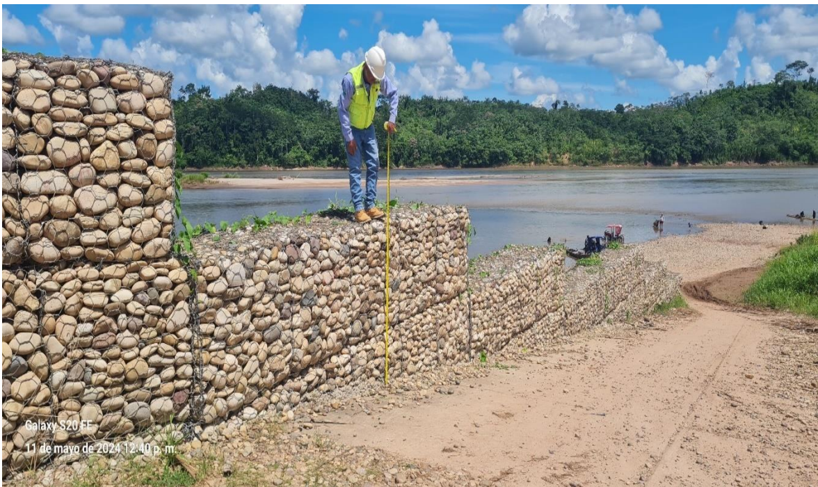
Fotografía N°06: Altura del muro de gaviones
