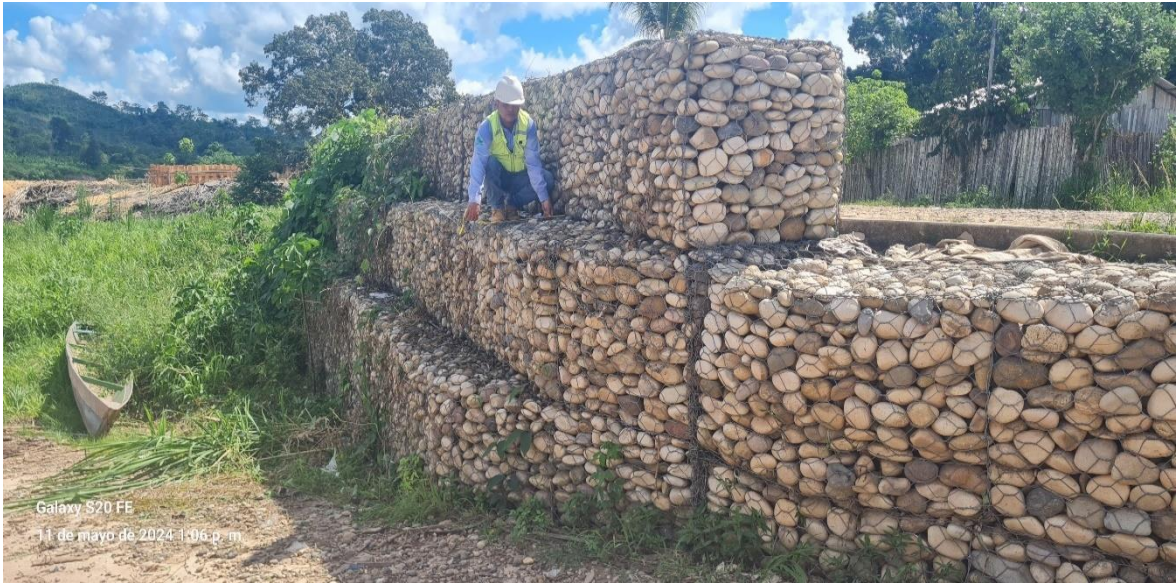
Fotografía N°13: Anchura entre cada escalonado
