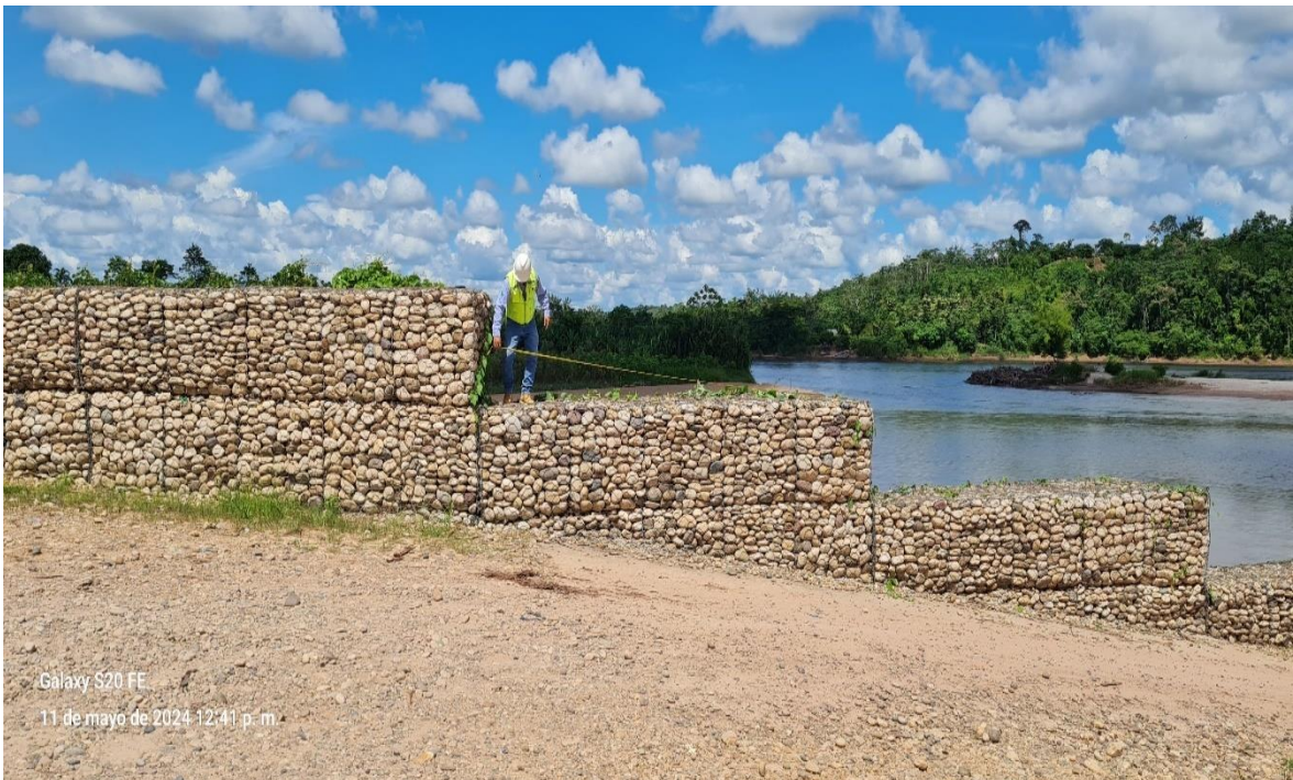
Fotografía N°08: Largo del muro de gaviones
