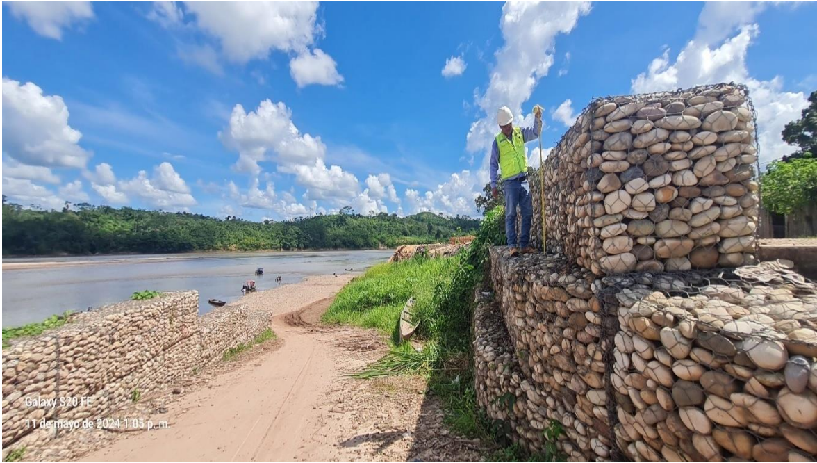
Fotografía N°11: Altura del 3 nivel del muro de gaviones
