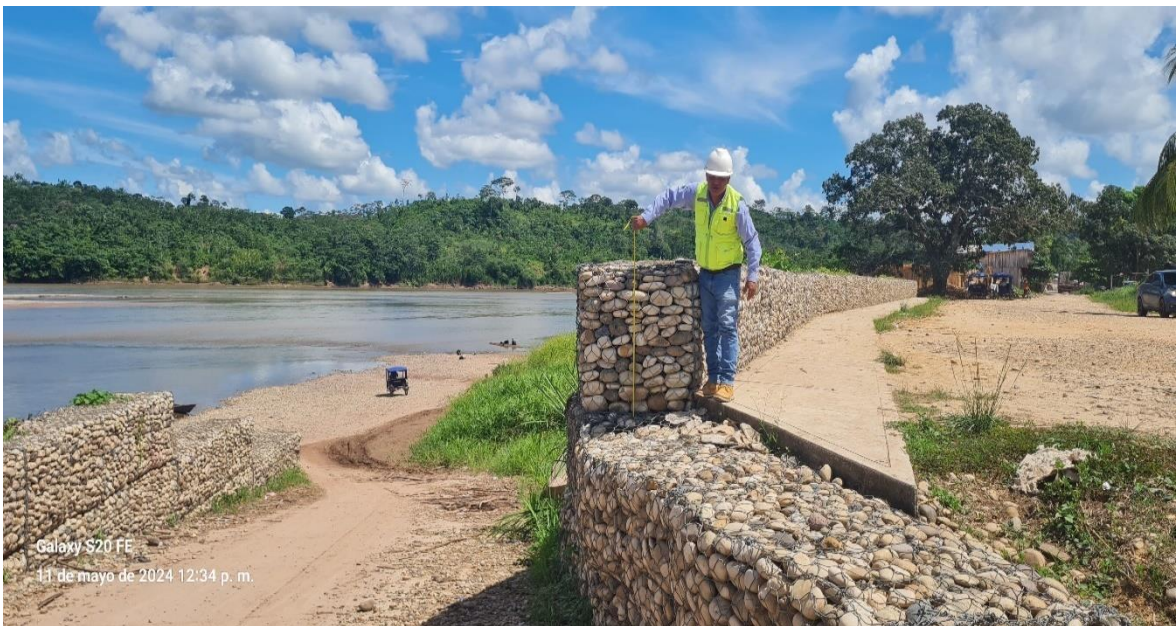
Fotografía N°04: Altura del gavión
