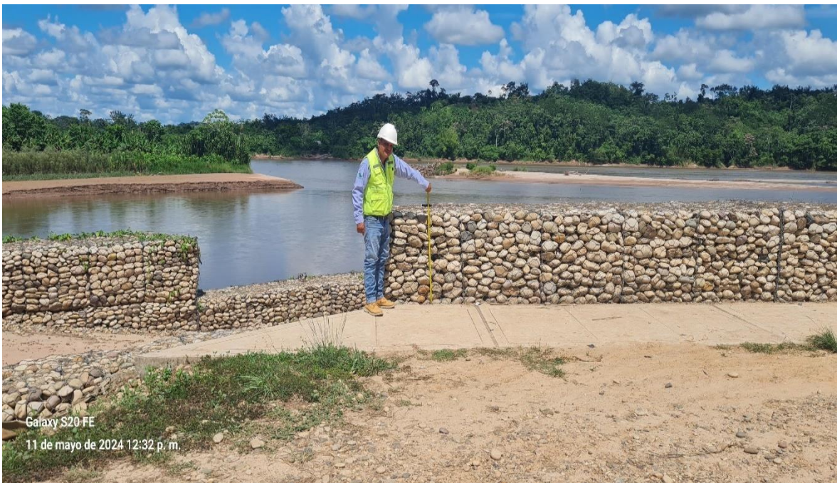
Fotografía N°02: Altura del cuarto nivel del muro de gavión
