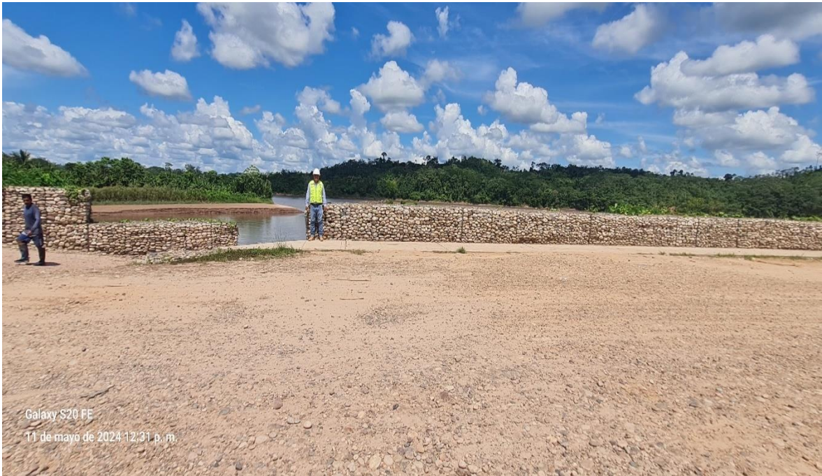
Fotografía N°01: Muro de gaviones del rio Huallaga
