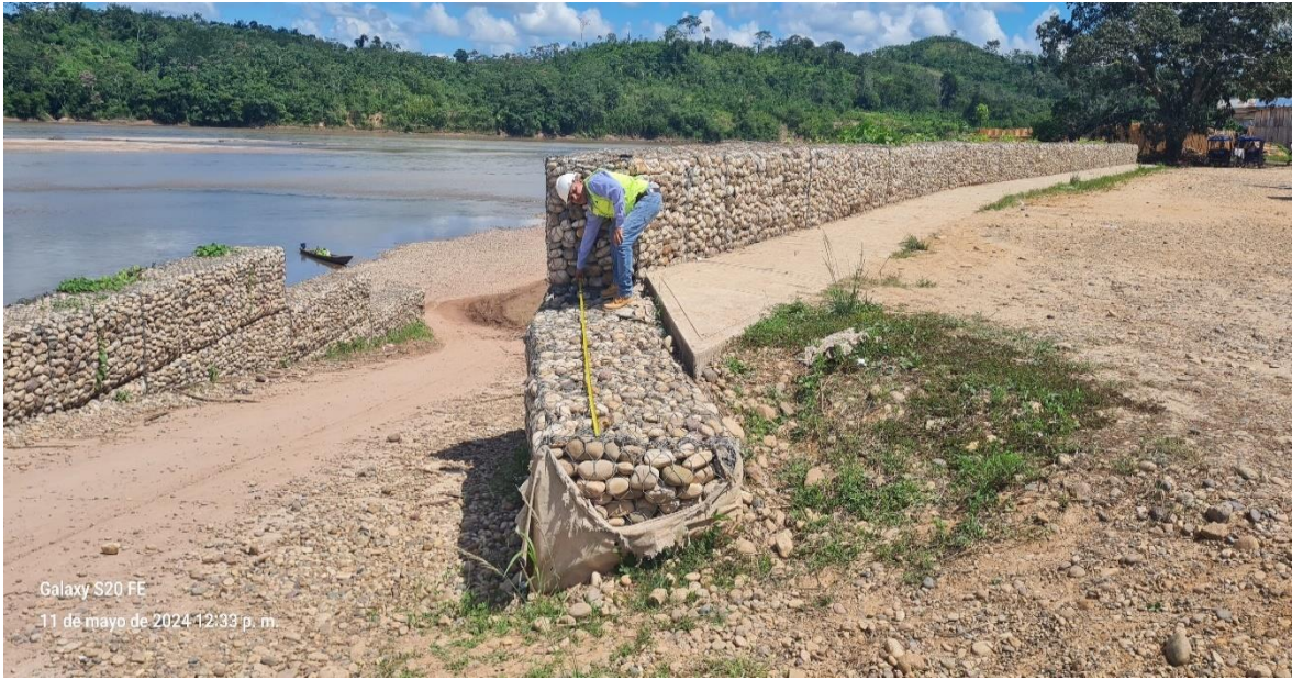
Fotografía N°03: Medición del largo del Gavión
