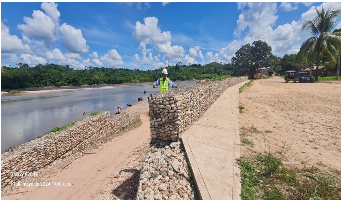
Fotografía N°10: Ancho del muro de gaviones
