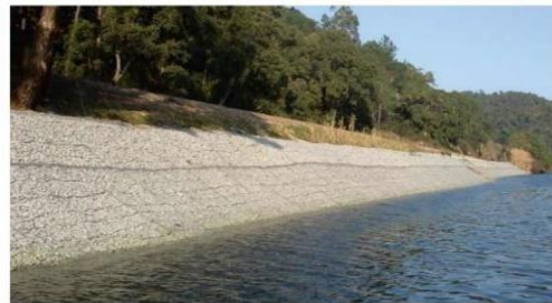
Figura 2. Gaviones para contención fluvial. Fuente:(A Bianchini, 2017).
