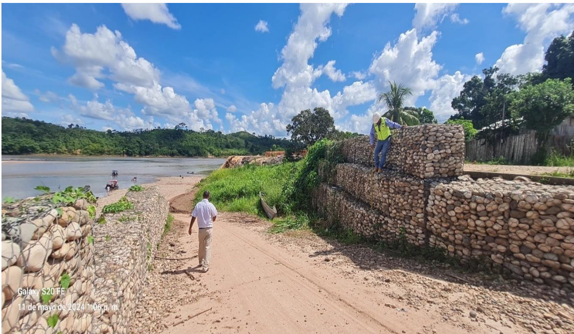
Fotografía N°12: Altura del segundo nivel del muro de gaviones
