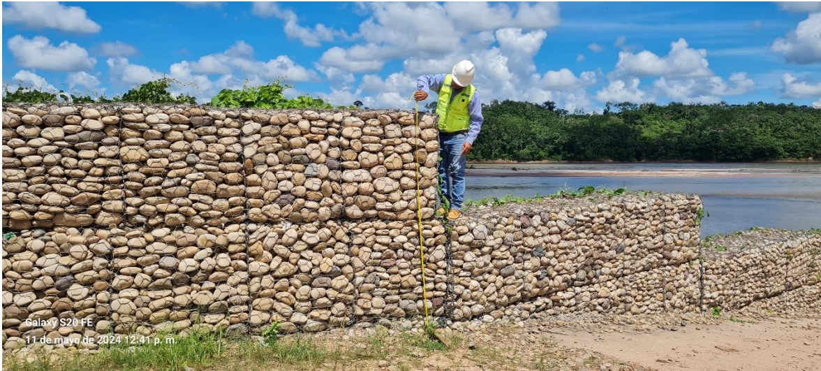
Fotografía N°07: Altura del muro de gaviones
