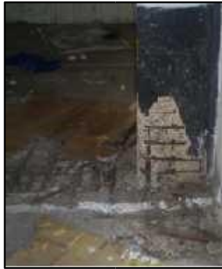
Imagen 05: Daños en columnas planta baja.
