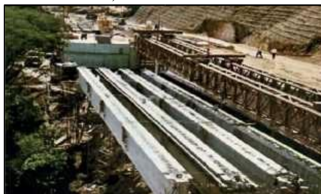
Imagen 19: Clases de presforzado: elementos pre y postensados.
