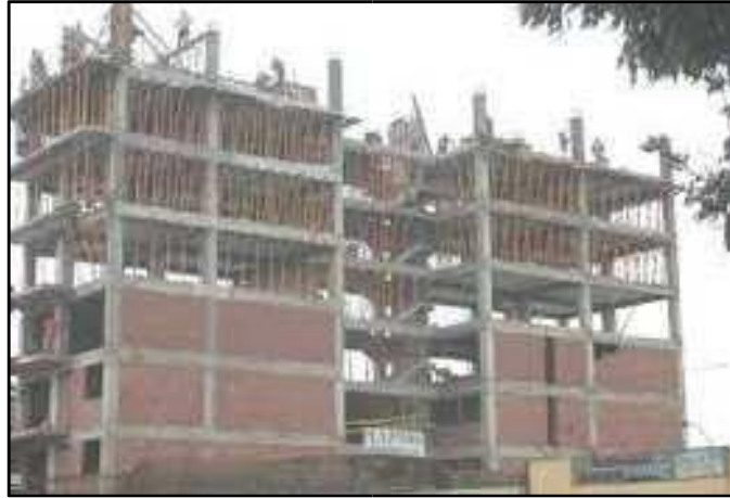
Imagen 17: Construcción de Muros de Albañilería y Elementos de Arriostre.
