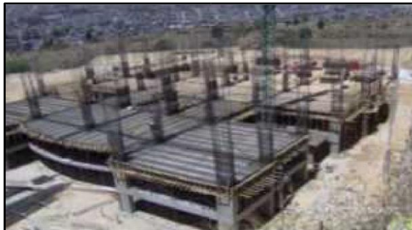
Imagen 21: Prefabricados con postensados
