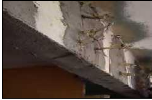
Imagen 30: Ataque por Ácidos Inorgánicos a estructuras de C°A°. ✓ Ataque
