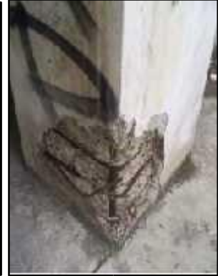
Imagen 05: Daños en columnas planta baja.
