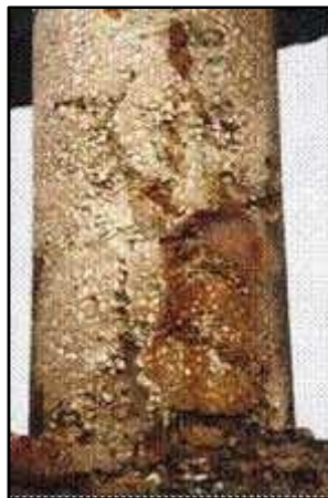
Imagen 31: Ataque por bases a estructuras de C°A°.
