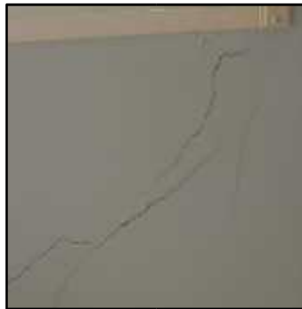
Imagen 42: Fisuras diagonales.
