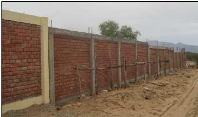
Imagen 16: Vigas de Concreto armado en cerco perimétrico.
