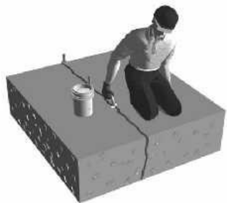
Fig. 2—Instalación de puertos de entrada.
