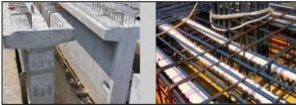
Imagen 20: Prefabricados con presfuerzo
