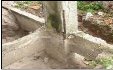
Imagen 29: Ataque por Ácidos Orgánicos a estructuras de C°A°.
