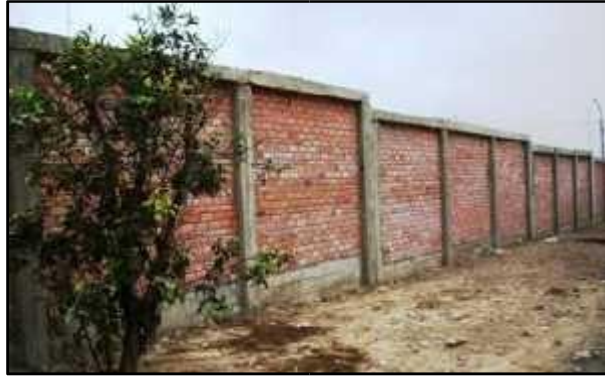
Imagen 14: Cercos Perimétricos de Albañilería confinada.
