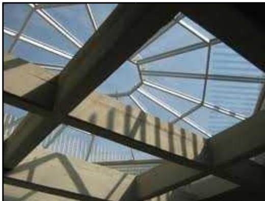
Imagen 15: Vigas de Concreto armado
