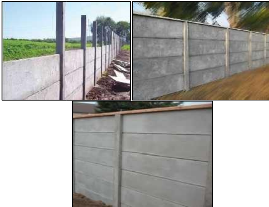
Imagen 25: Muros de cerramiento Prefabricadas.
