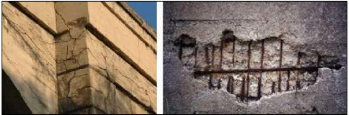
Imagen 27: Ataque químico de sulfatos y cloruros.
