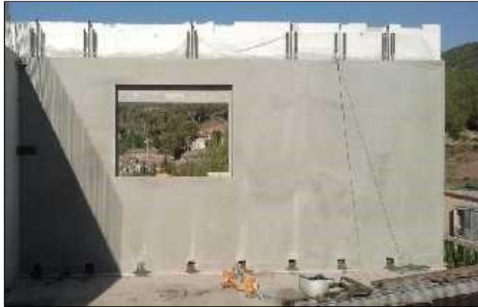
Imagen 24: Muros no portantes Prefabricadas.
