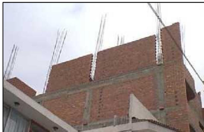
Imagen 18: Confinamiento de Muros de Albañilería.
