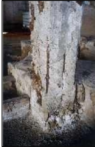
Imagen 28: Ataque químico de ácidos a estructuras de concreto armado.
