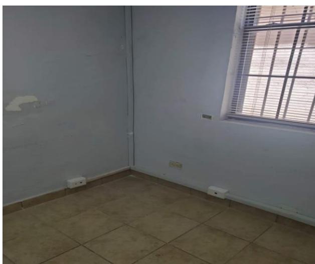
Dos tomas de red instaladas
