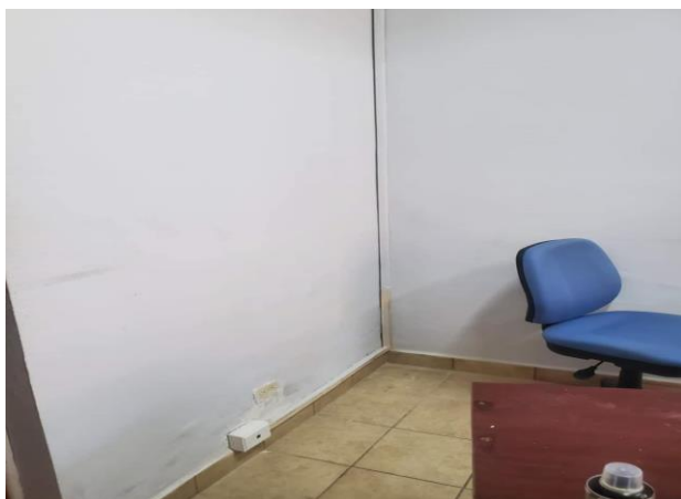
Instalación de toma de red
