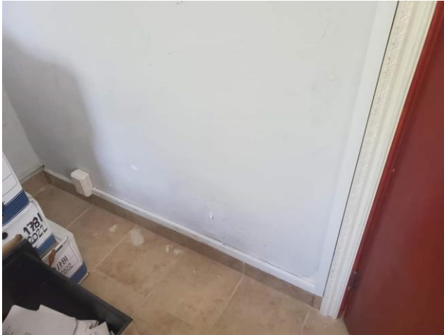
Toma de red instalada
