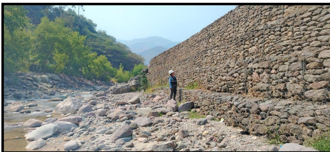
Figura 20: Vista general del muro de gaviones existente
