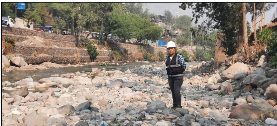
Figura 33: Vista panorámica del muro de gaviones Fuente: Evidencia de campo
