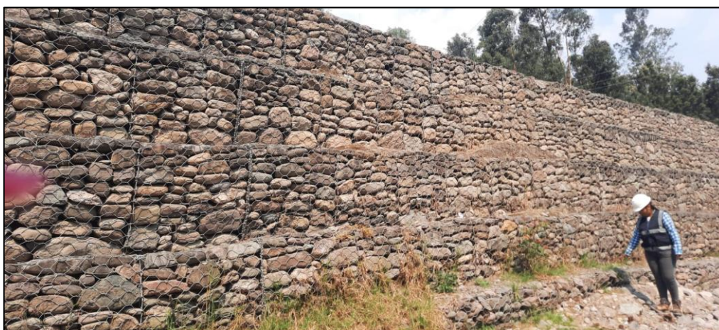
Figura 38: Vista general del muro de gaviones Fuente: Evidencia de campo
