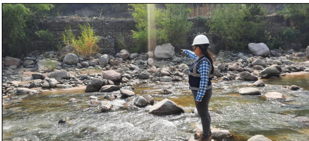
Figura 37: Muro de gaviones existente Fuente: Evidencia de campo
