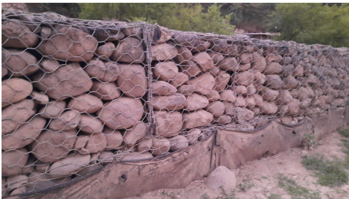
Figura 26: huecos entre rocas, rocas mayores a 12” Fuente: Evidencia de campo
