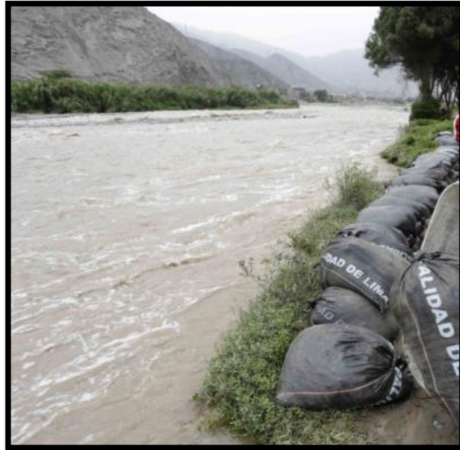
Figura 10: Sacos de arena
