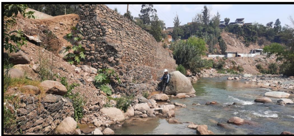
Figura 18: Se aprecia la evaluación del muro de gaviones
