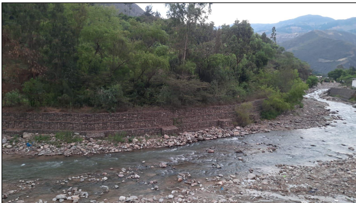
Figura 21: Vista panorámica muros de gaviones
