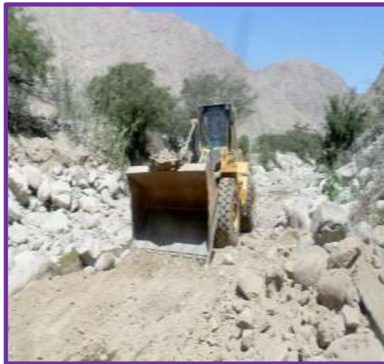
Figura 1: Evaluación del enrocado
