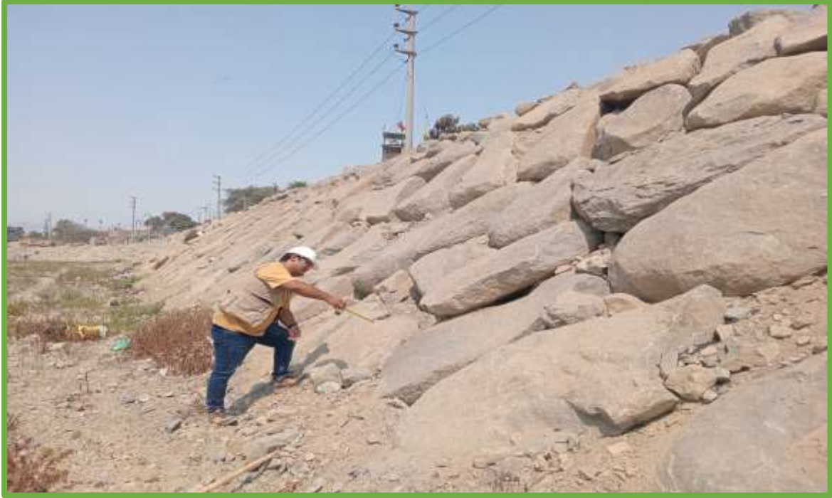
Figura 15. En la imagen se observa la toma de medidas de las rocas que conforman el enrocado en la progresiva 0+070.
