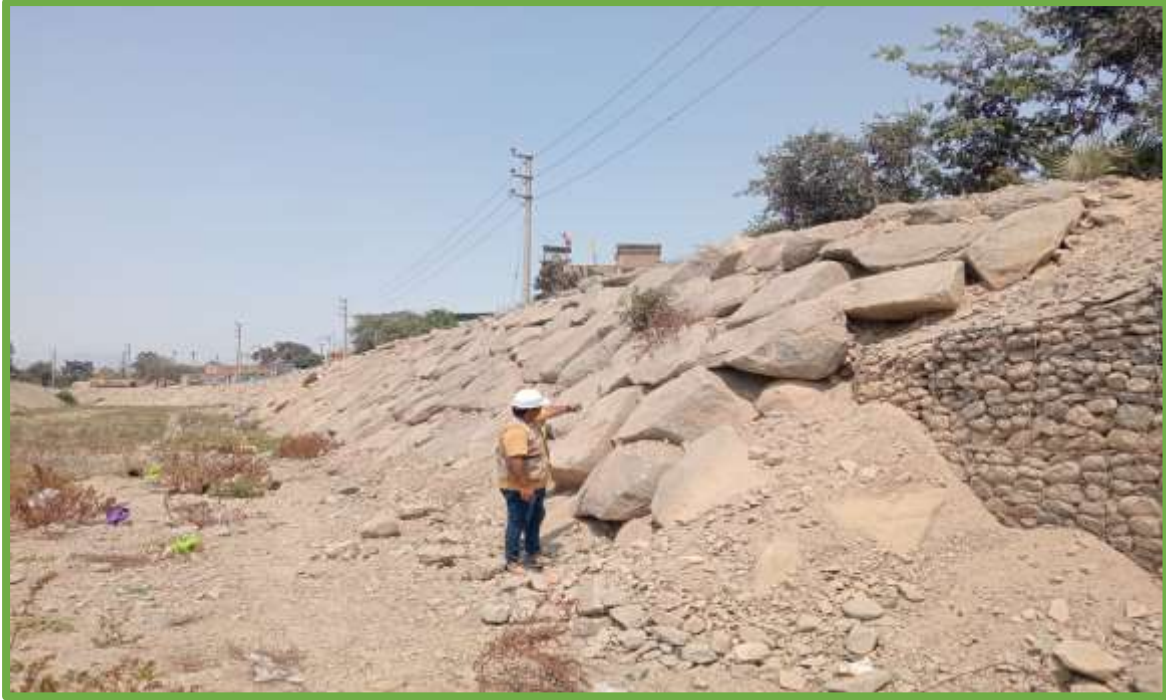
Figura 1. En la imagen se observa el inicio del enrocado en la progresiva 0+000.
