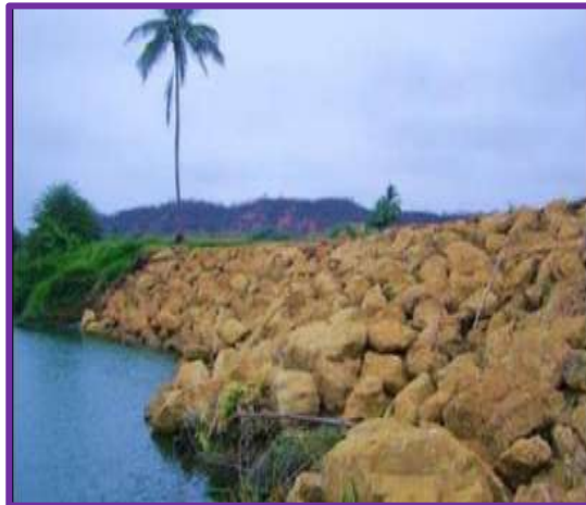
Figura 3: Enrocado con roca al volteo
