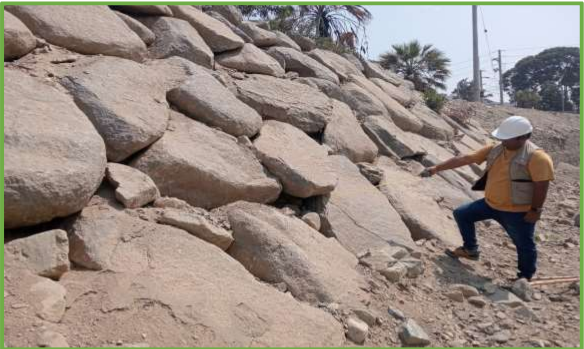
Figura 16. En la imagen se observa la toma de medidas de las rocas que conforman la estructura la progresiva 0+080.
