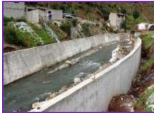
Figura 13: Muro de concreto armado
