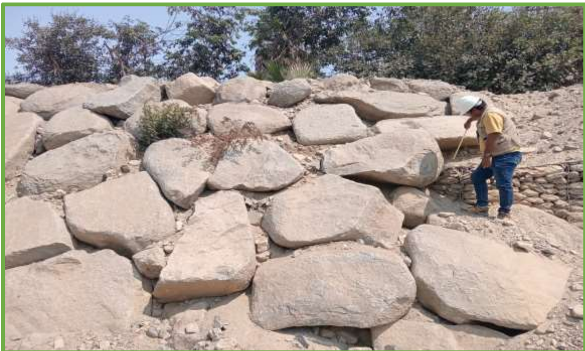
Figura 14. En la imagen se observa la medición de las justas del enrocado en la progresiva 0+000.
