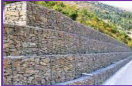
Figura 17: Gaviones tipo caja
