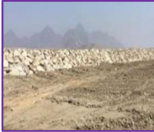
Figura 4: Enrocado con roca colocada
