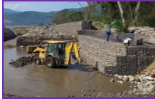
Figura 15: Muro de gaviones
