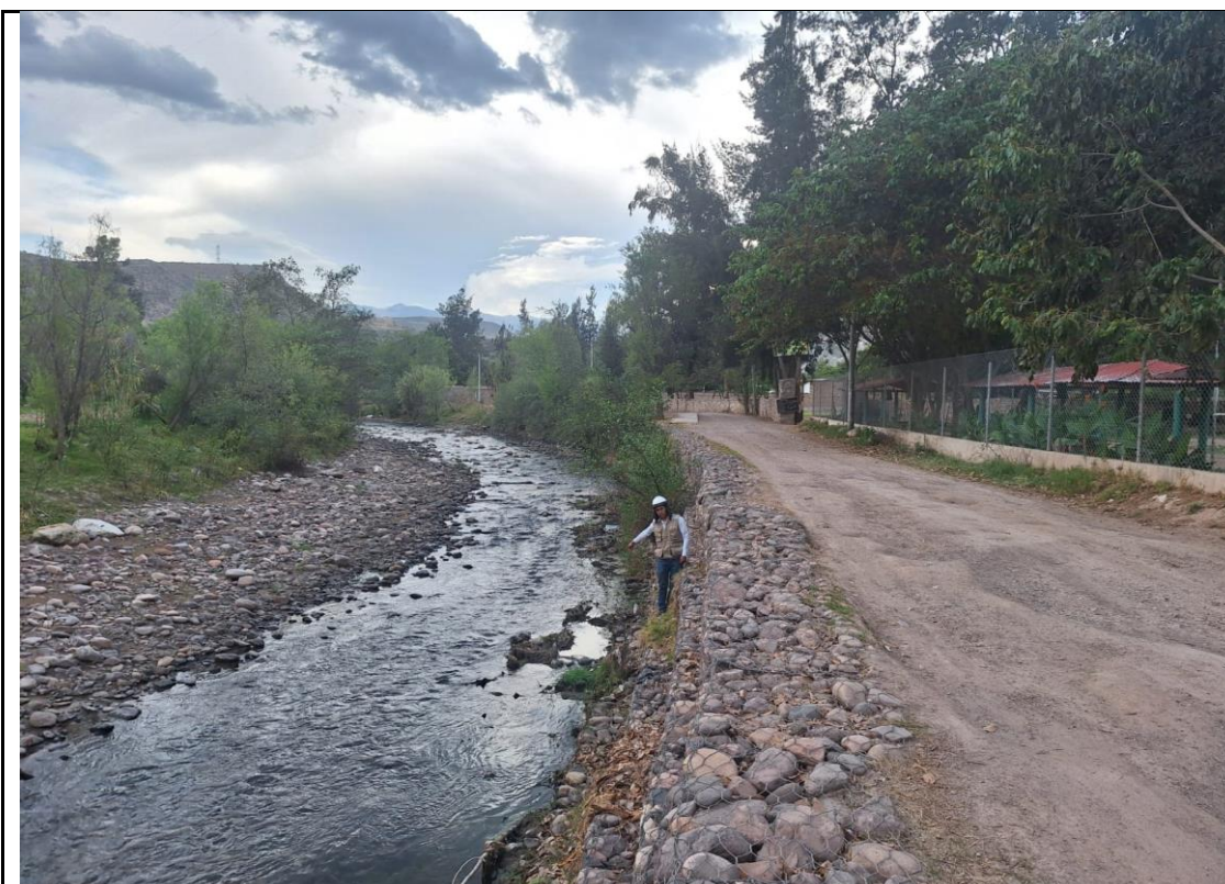
Foto N°2: se observa la medición del colchón
