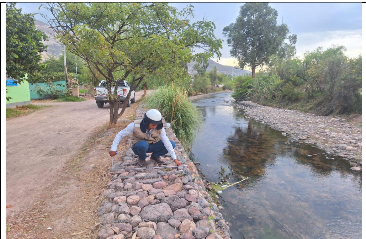
Foto N°4: se observa diferentes diámetros de los materiales empleados en el muro de gavión
