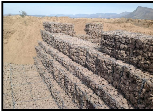
Figura 1: Evaluación de muro de gaviones
