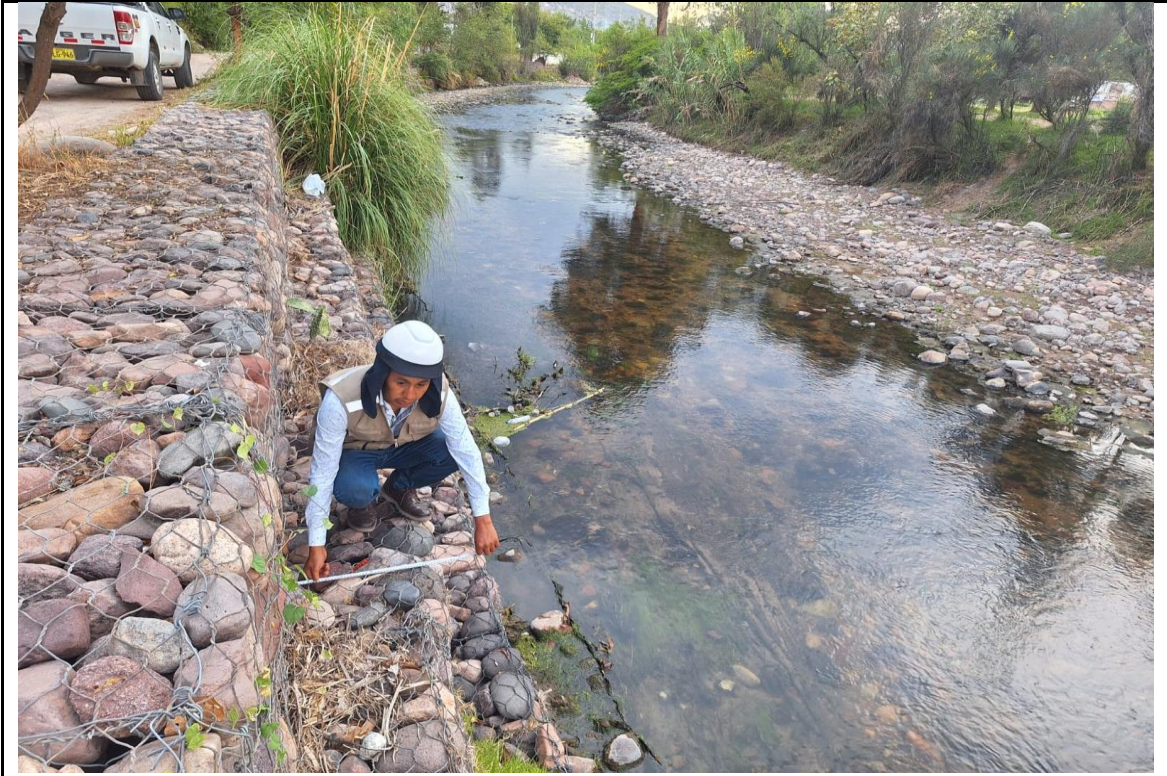
Foto N°5: se observa la medición de la estructura del muro de gavión
