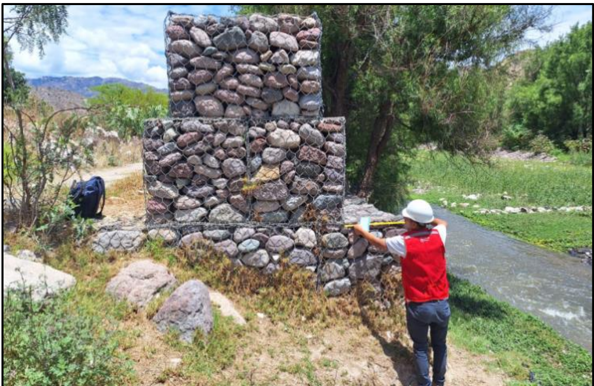
Figura 34: Medidas de los muros de gaviones tramo 0+000
