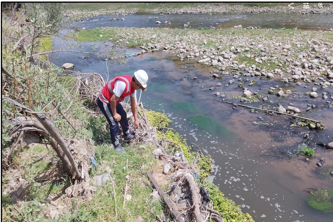
Figura 26: Vista de trocos de sauce colocados en la base del muro Fuente: Elaboración propia – 2024
