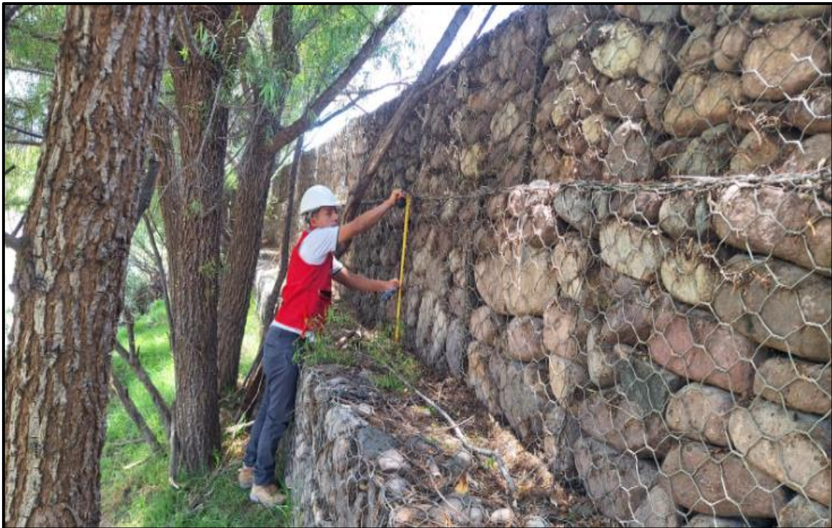
Figura 36: Altura de muro gaviones tipo caja progresiva 0+350
