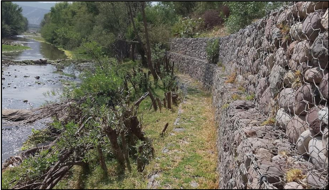
Figura 29: Vista de talado de árboles para apoyar en la defensa ribereña
