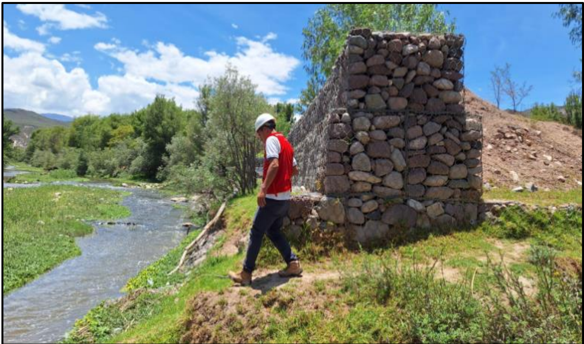
Figura 38: Tramo final de la evaluación del muro de gaviones
