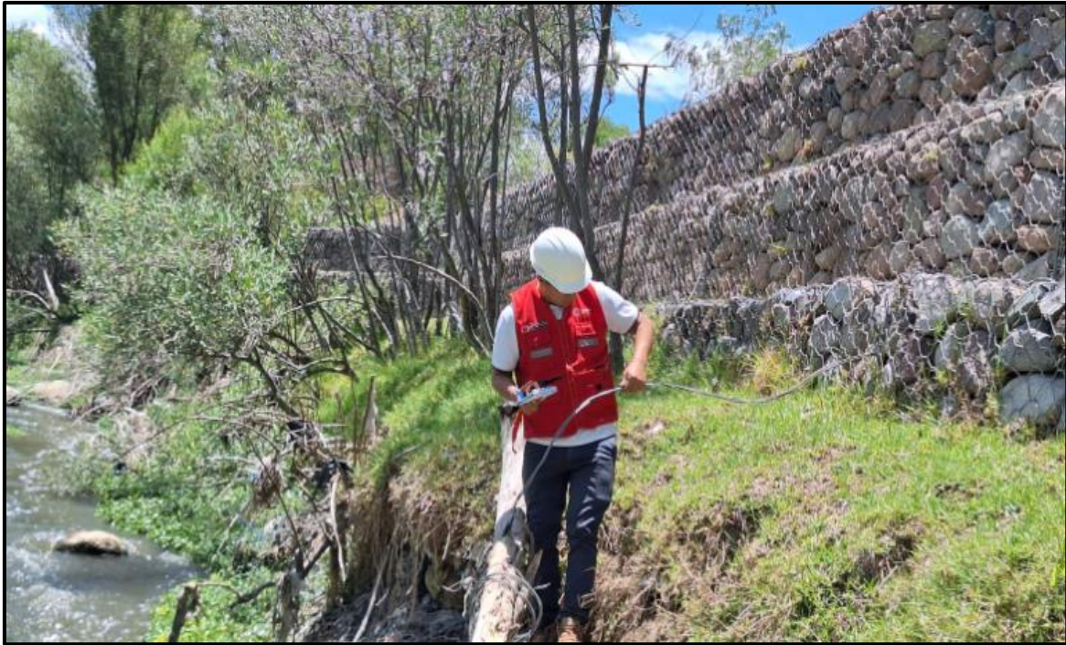
Figura 31: Vista de cable tipo boa de ½” para amarrar troncos de sauce
