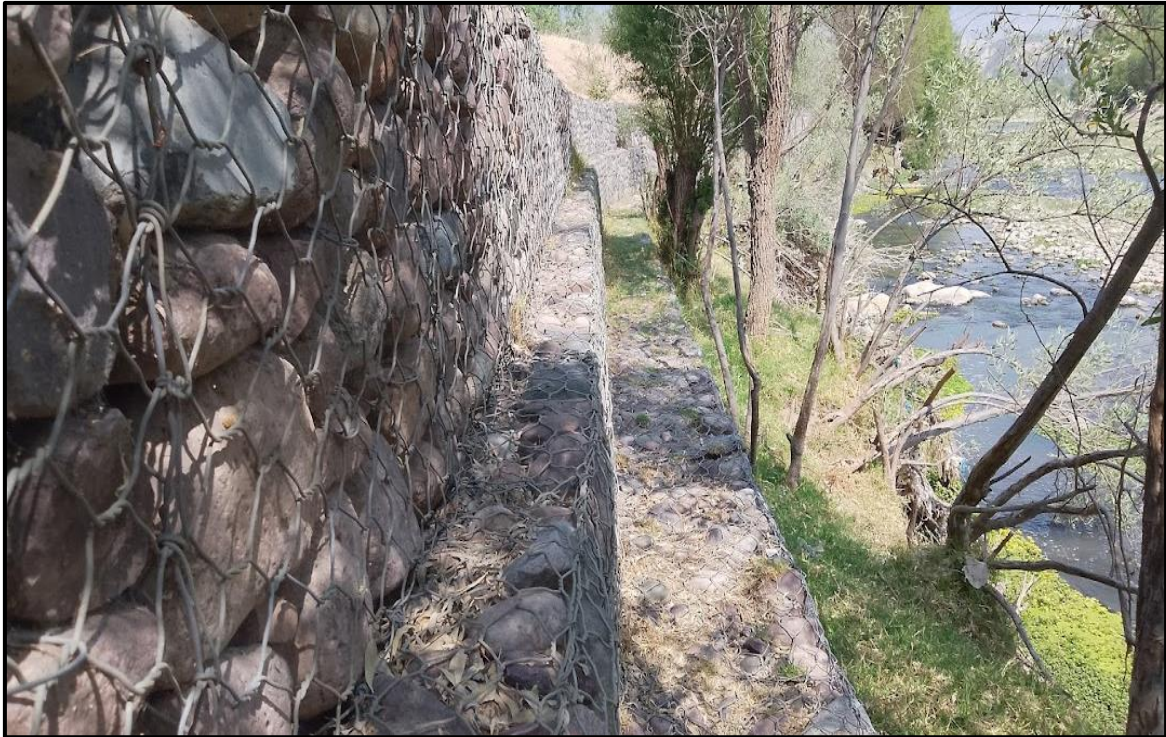
Figura 27: Vista de muro de gaviones tramo 0+050 a 0+100
