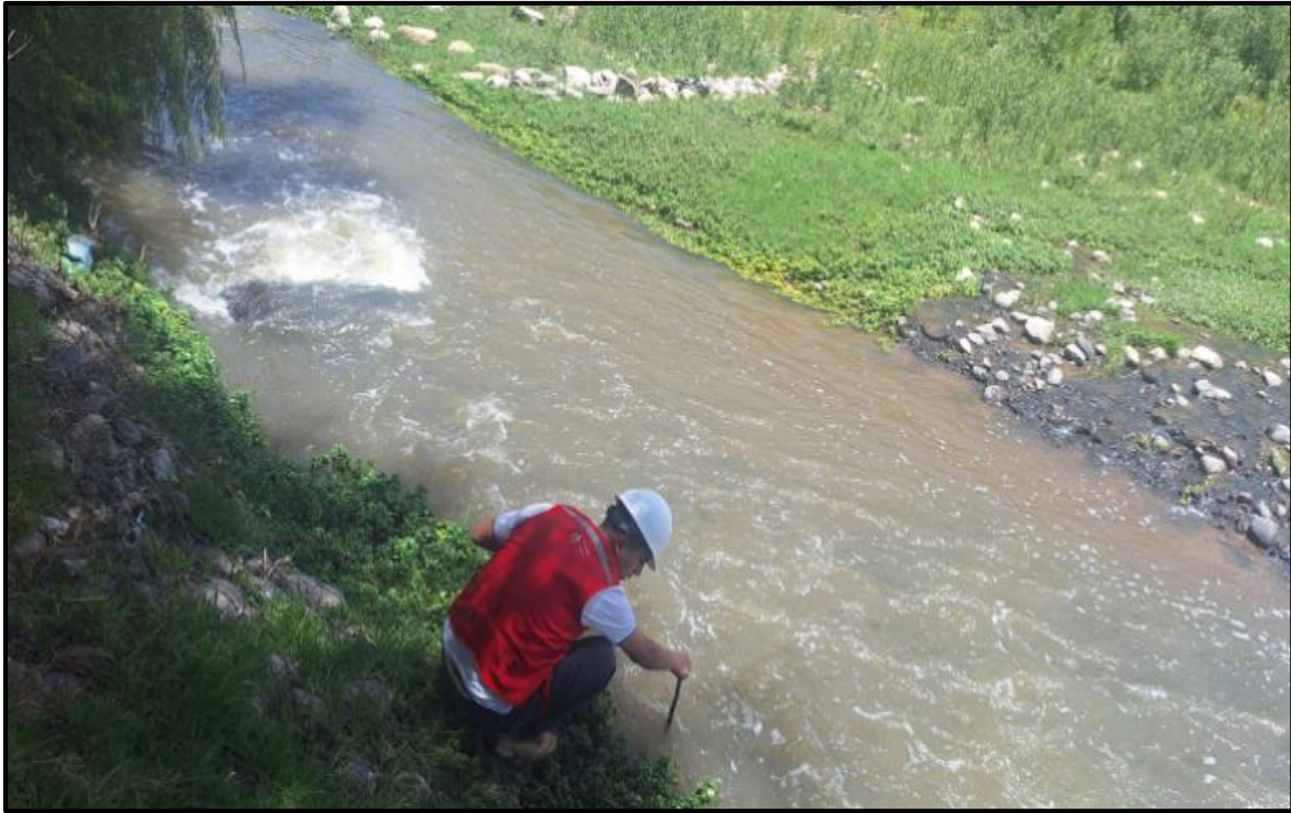
Figura 35: Altura de caudal en base del muro en el tramo 0+250
