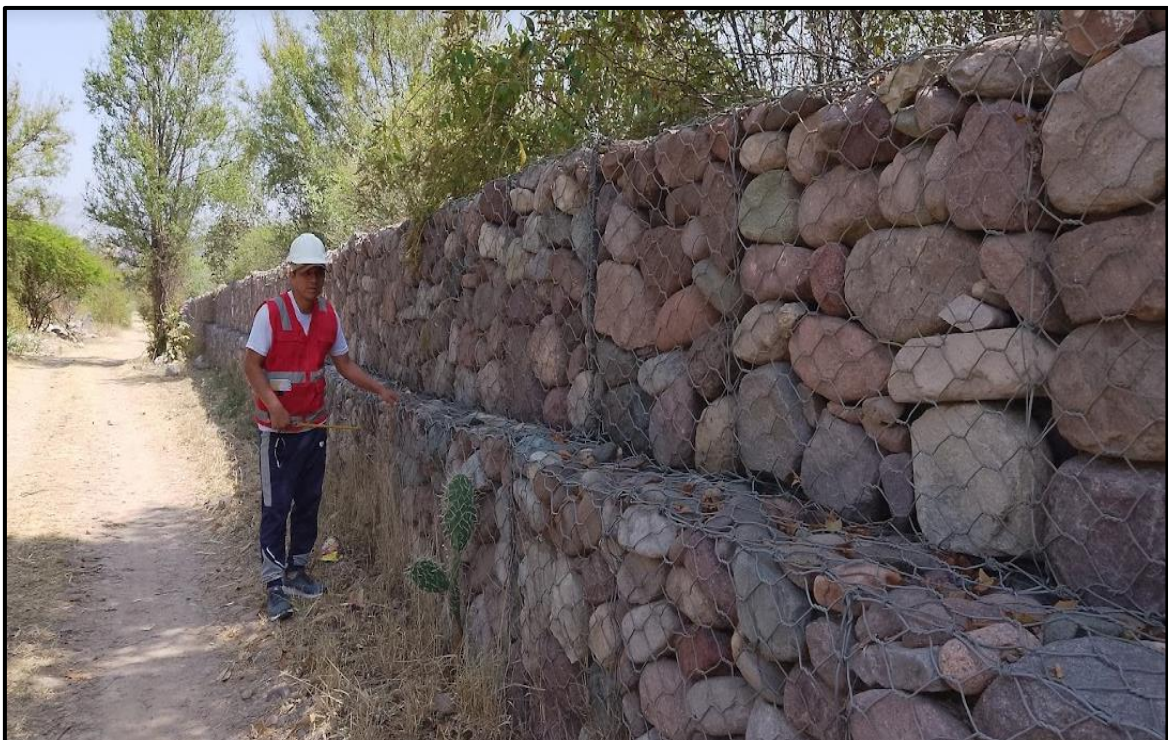
Figura 24: Vista de la parte posterior del muro gaviones en evaluación
