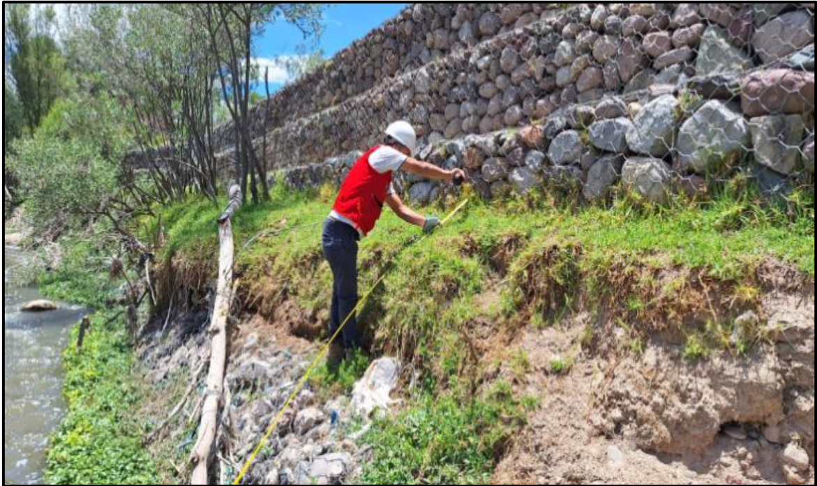
Figura 33: Distancia del muro de gavion tipo colchón
