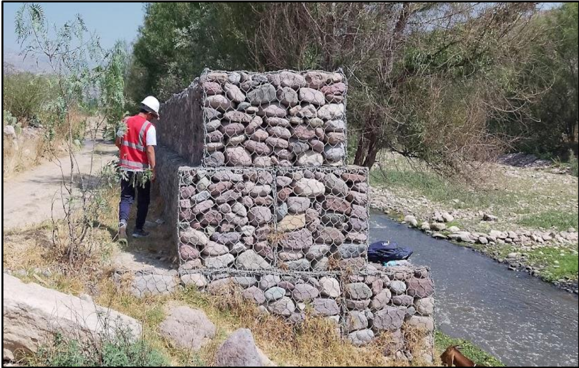
Figura 25: Vista de inicio del muro de gaviones en estudio Fuente: Elaboración propia – 2024
