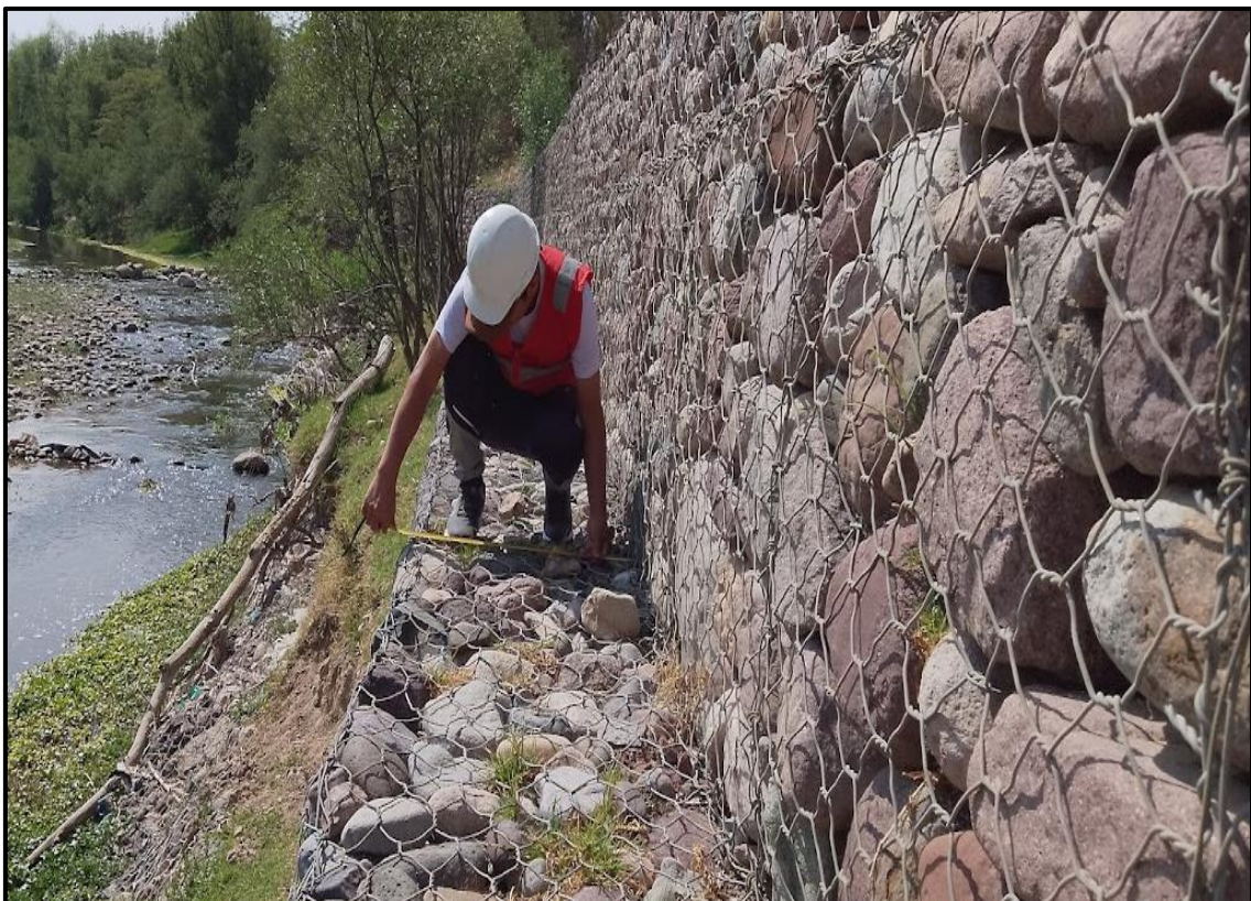
Figura 30: Inicio de la evaluación del muro de gaviones
