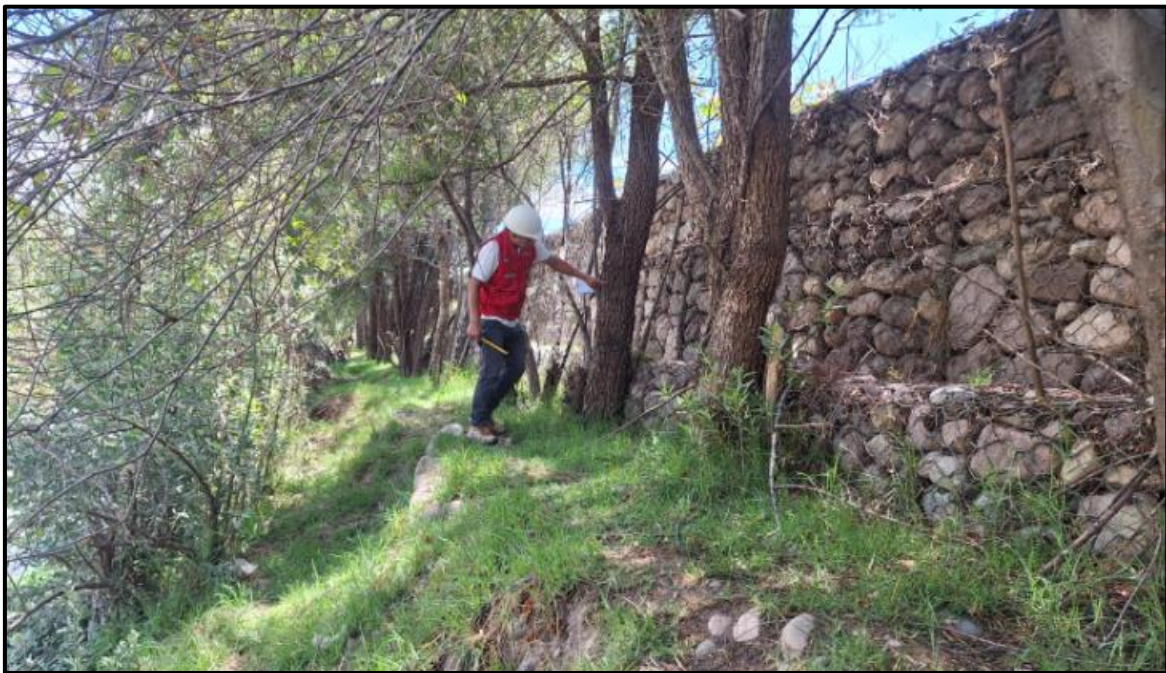
Figura 32: Arborización en el muro de gaviones
