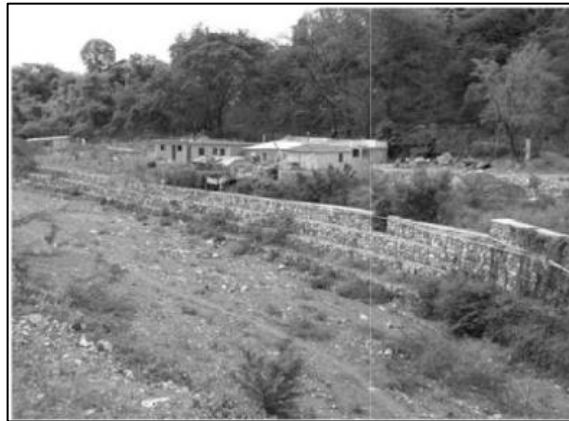
Figura 1: Muro longitudinal en gaviones caja.
