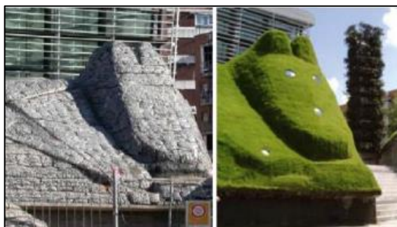
Figura 14: Estructura construida con gaviones.
