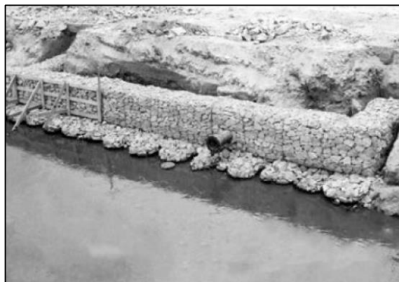
Figura 5: Gaviones caja, fundado en una base de gaviones saco.
