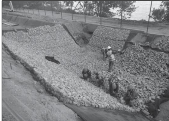
Figura 7: Revestimiento con colchón. Fuente: Extraído de Fracassi (19).
