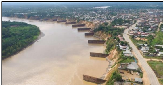
Figura 15: Defensa Ribereña. Fuente: Extraído de la Torre (22).
