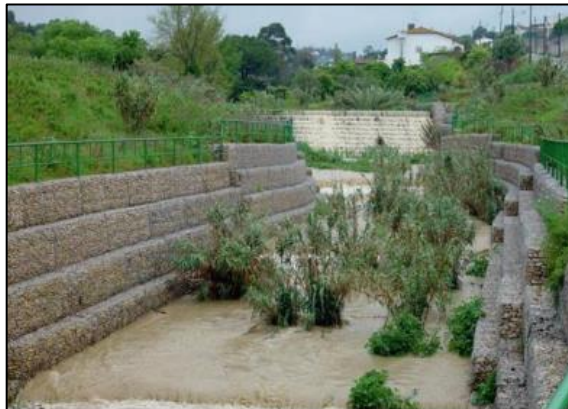
Figura 12: encausamiento de ríos. Fuente: extraído de Bolívar (21).
