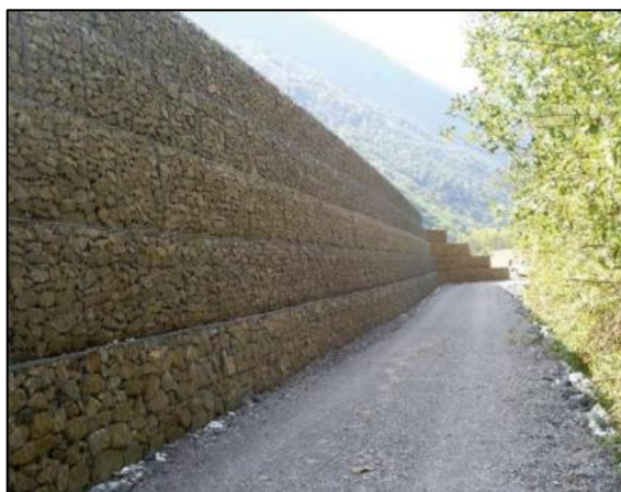
Figura 13: muro de contención en carretera.
