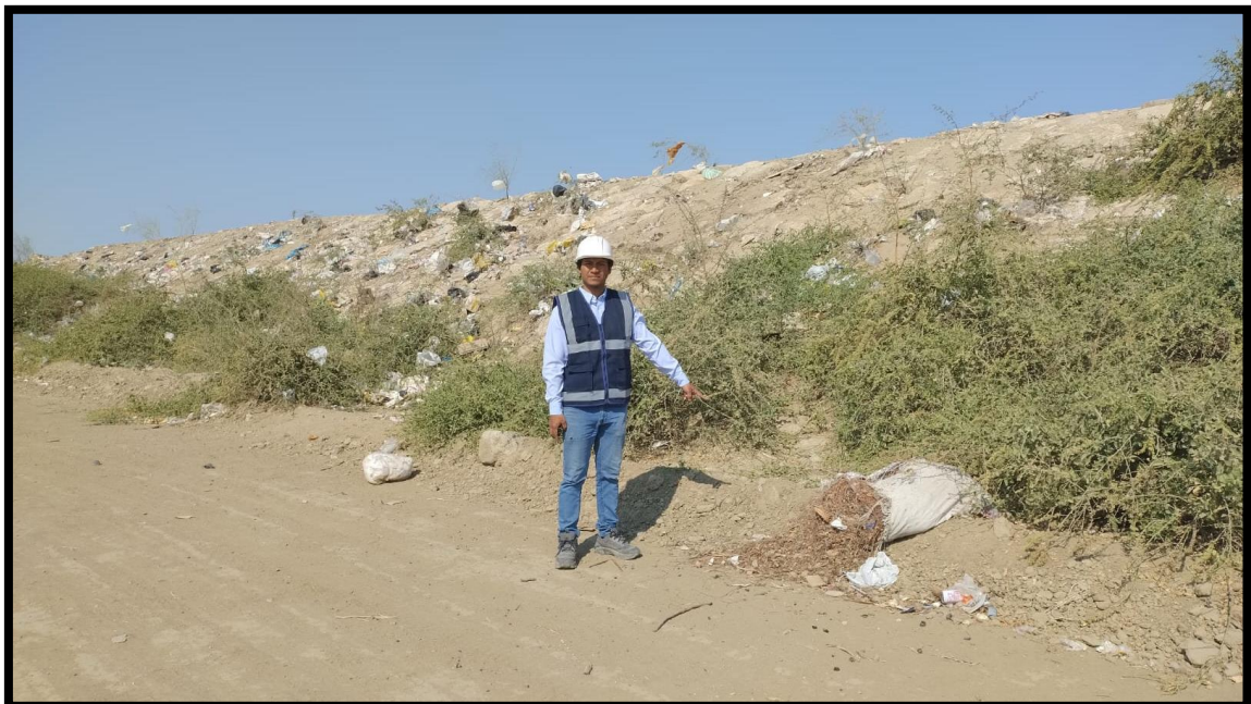
Figura 10: Falta de mantenimiento y limpieza de la defensa ribereña
