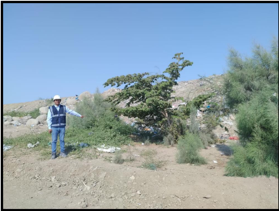
Figura 11: Existencia de un árbol (vegetación) al costado del dique
