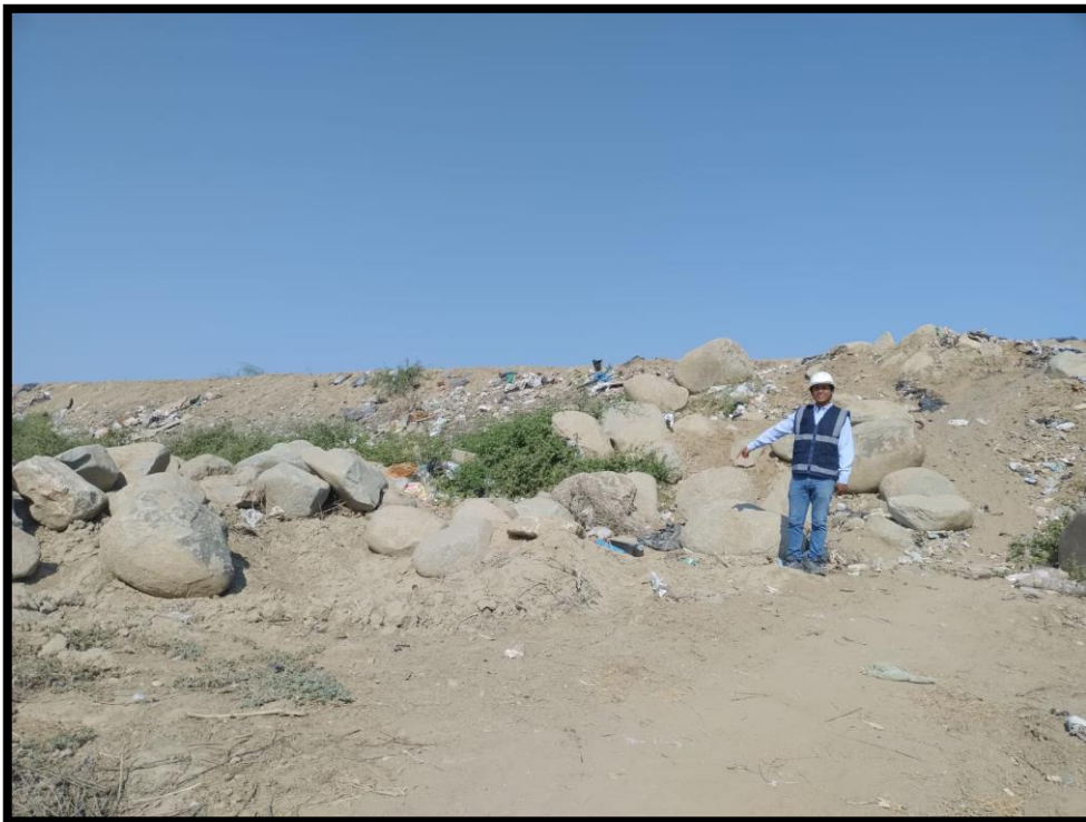
Figura 12: Enrocado cerca de la defensa ribereña
