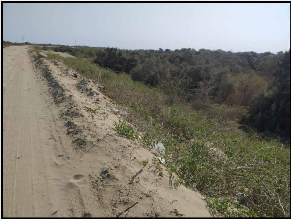
Figura 16: Vista del dique
