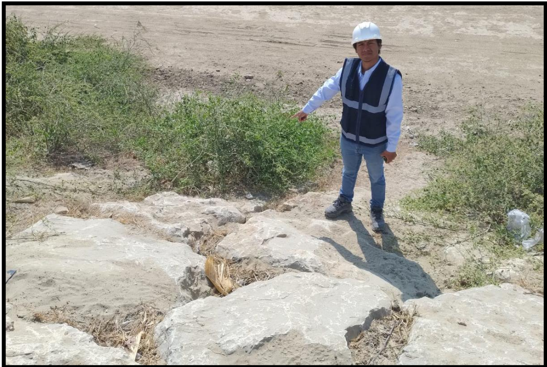
Figura 7: Vista de enrocado de dique
