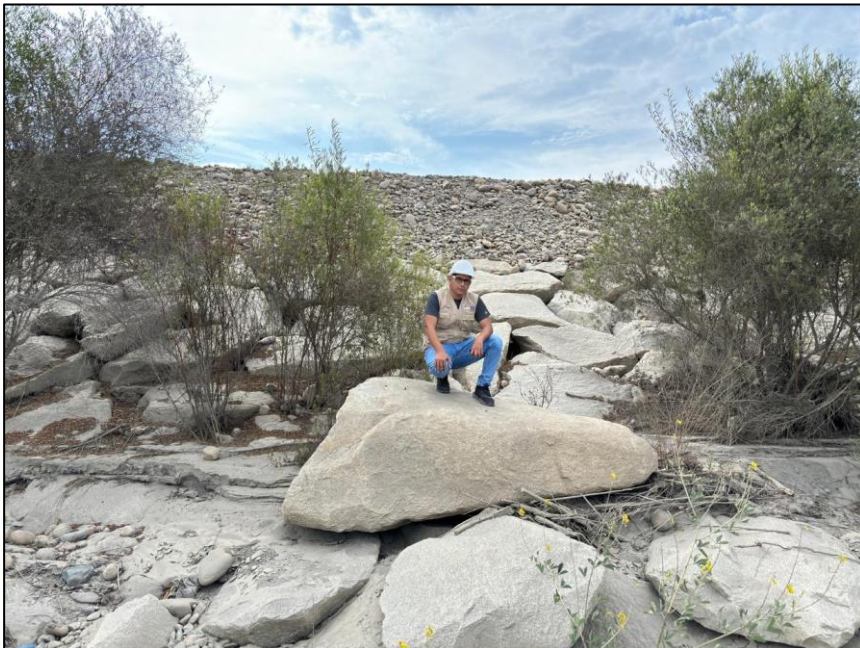
Figura 12: Deslizamiento del enrocado
