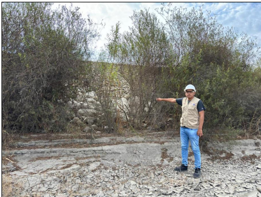
Figura 9: Presencia de malezas en el enrocado
