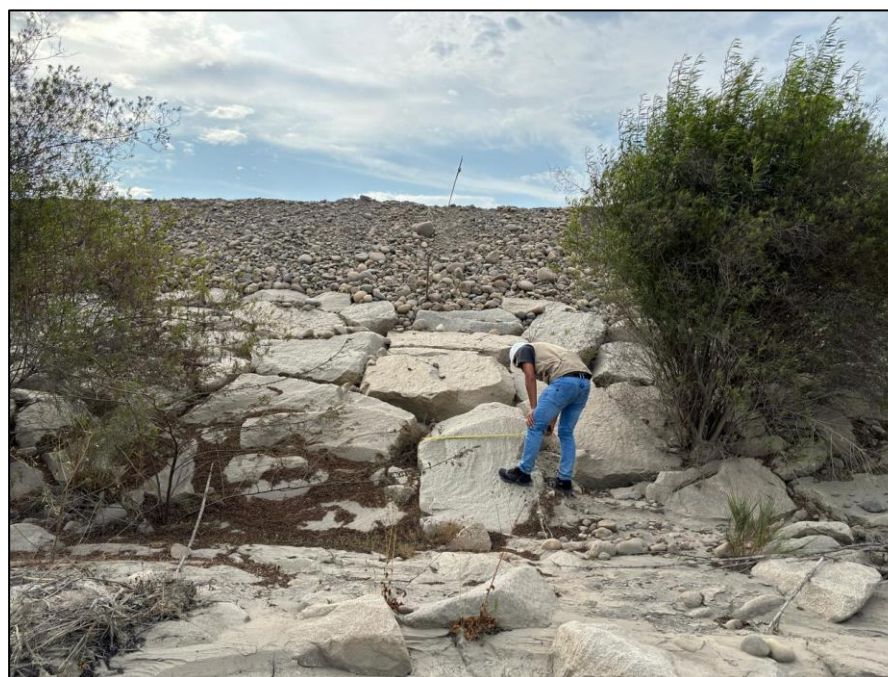
Figura 10: Medición del enrocado
