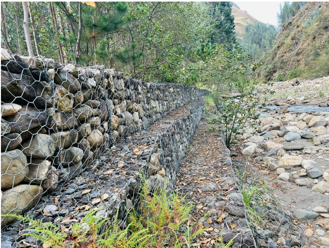
Fotografía 3. Plantaciones de arboledas detrás del Muro de Gavión de la defensa ribereña del río Grande del caserío de Manta Baja, distrito Ragash, provincia de Sihuas
