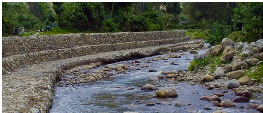
Imagen 9. Desarrollo de la flora y fauna tras la construcción de la defensa ribereña.
