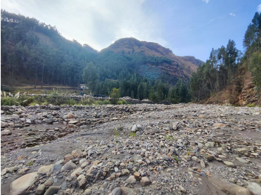
Fotografía 2. Vista general del Muro de Gavión de la defensa ribereña del río Grande del caserío de Manta Baja, distrito Ragash, provincia de Sihuas
