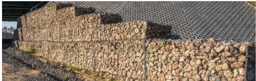
Imagen 6. Muro de gaviones formados por gaviones tipo Colchón.
