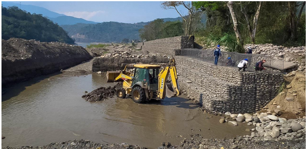
Imagen 4. Proceso constructivo de Muro de Gaviones
