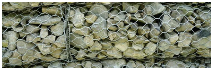
Imagen 7. Muro de gaviones formados por gaviones tipo Saco.
