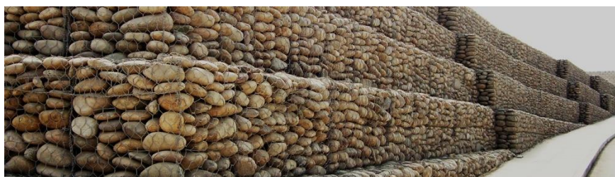
Imagen 10. Material de relleno con piedra de caonto rodado.
