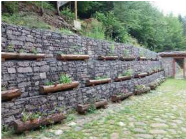
Figuras 1: Estructura de gaviones
