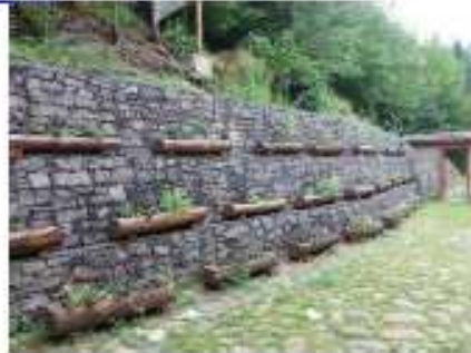
Figura 1. Estructura con gaviones. Fuente: http://www.solucionesespeciales.net/MedioAmbiente/Gaviones/Gaviones.aspx
