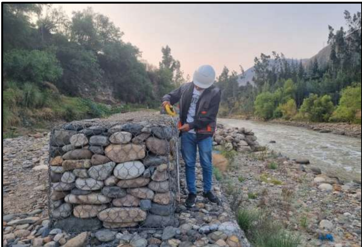
Figuras 13: Altura del gavión Fuente: Elaboración propia
