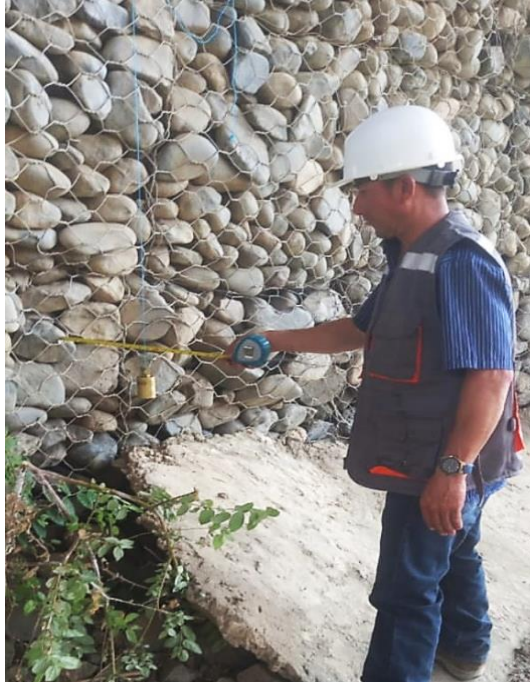
Figura 19. Prog. 0 + 450 Se realizo la medida con la plomada para verificar la alineación del gavión.
