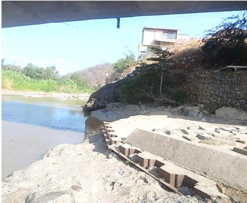
Figura 13. Vista panorámica de la ubicación del muro
