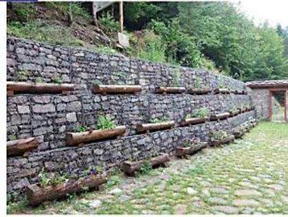
Figura 1. Estructura con gaviones. Fuente: http://www.solucionesespeciales.net/MedioAmbiente/Gaviones/Gaviones.aspx
