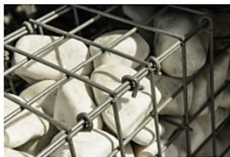
Detalle de la unión mediante grapas
