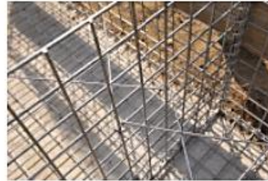
Disposición de los refuerzos de 50 cm en los gaviones de 200x50x100 cm
