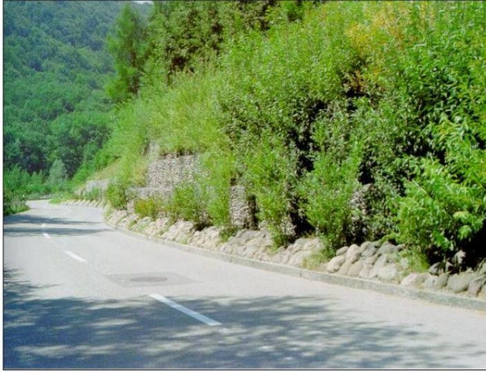
Ilustración 1: Muro de contención de gaviones
