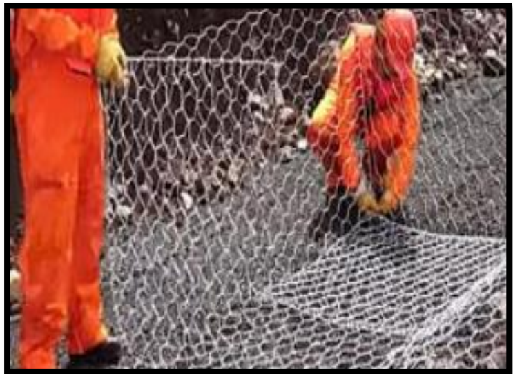
Figura 7. Colocación malla en gavión
