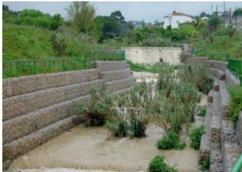
Figura 22. Encauzamiento de ríos. Fuente: (A Bianchini, 2017)
