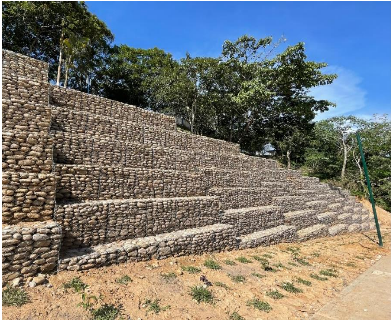
Figura 4. Muro de gaviones tipo caja
