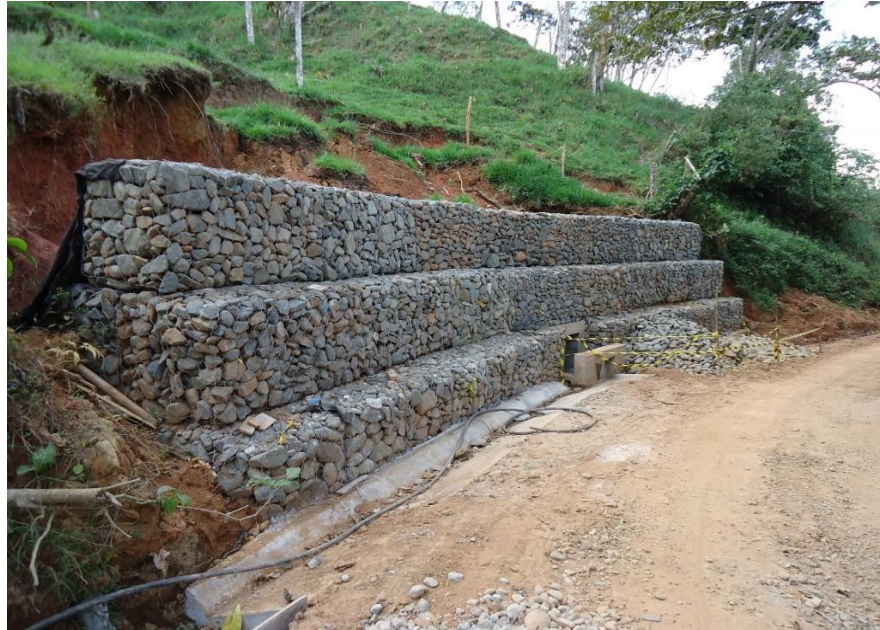
Figura 2. Muro de gaviones
