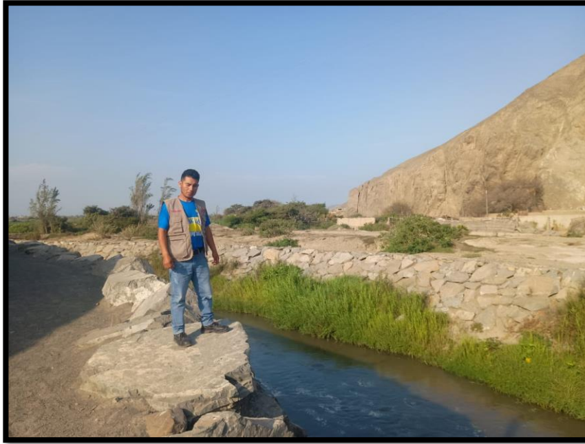
Figura 18: Enrocado tramo 0+250 - 0+300
