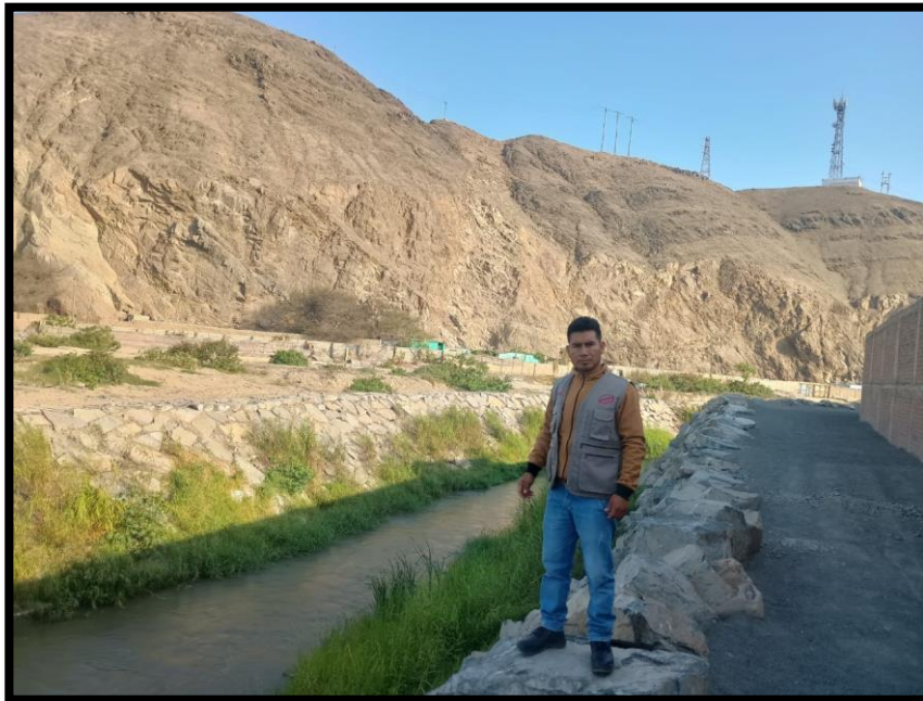
Figura 17: Enrocado tramo 0+300 - 0+350
