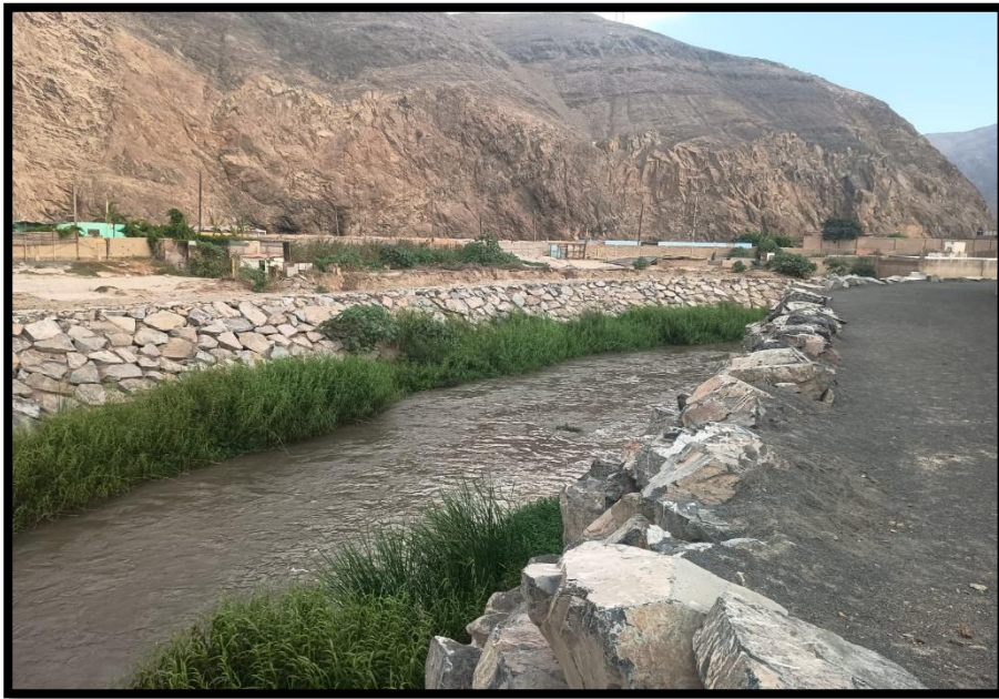
Figura 11: Cauce del río - progresiva 0+120 - 0+240
