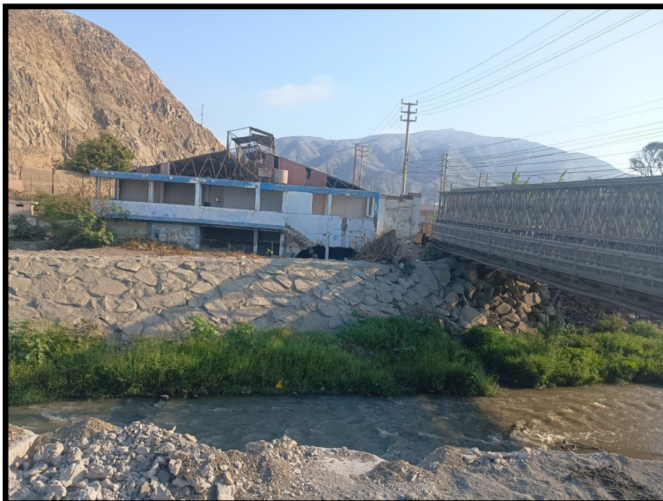
Figura 21: Puente panamericana norte
