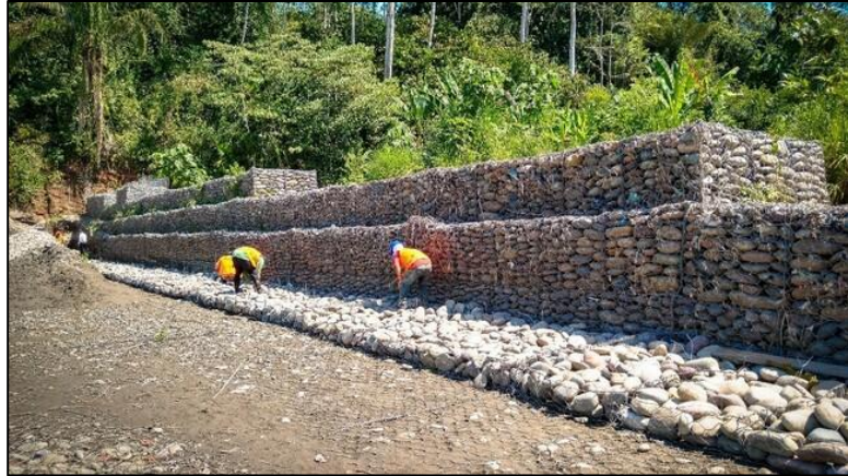
Figura 10: Construcción del muro de gaviones
