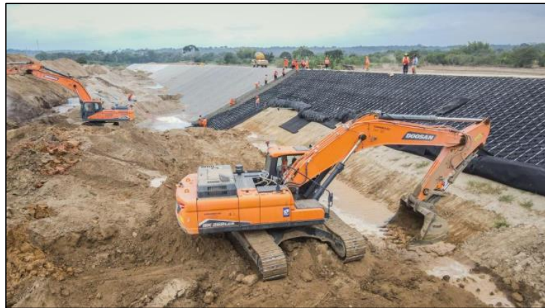
Figura 9: Instalación de geo celdas
