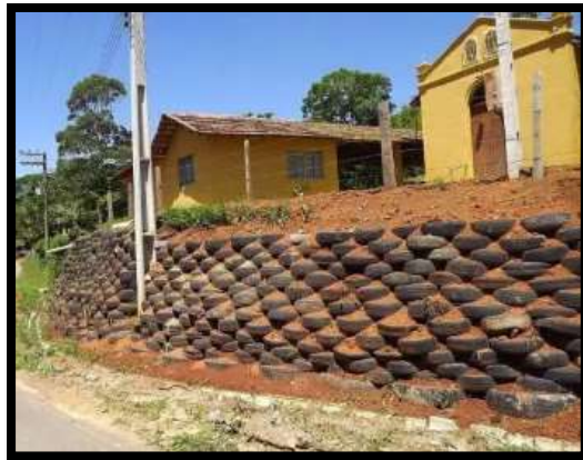
Figura 16: Muro contención de pared neumático. Fuente: extraído canal de construcción.
