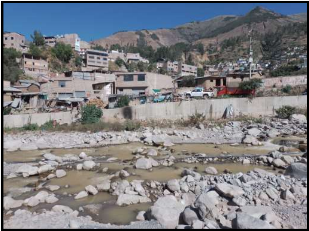
Figura 26: Muro de contención en tiempo de estiaje. Fuente: Evidencia de campo
