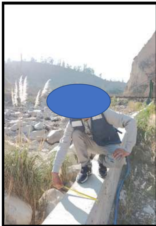
Figura 37: Mediciones del muro de contención progresiva 0+100 – 0+300. Fuente: Evidencia de campo
