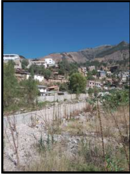
Figura 20: Muro de contención margen derecho progresiva 0+000 - 0+100.
