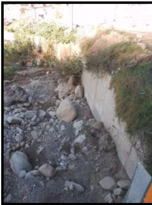
Figura 29: Muro de contención con desmonte en Loma. Fuente: Evidencia de campo
