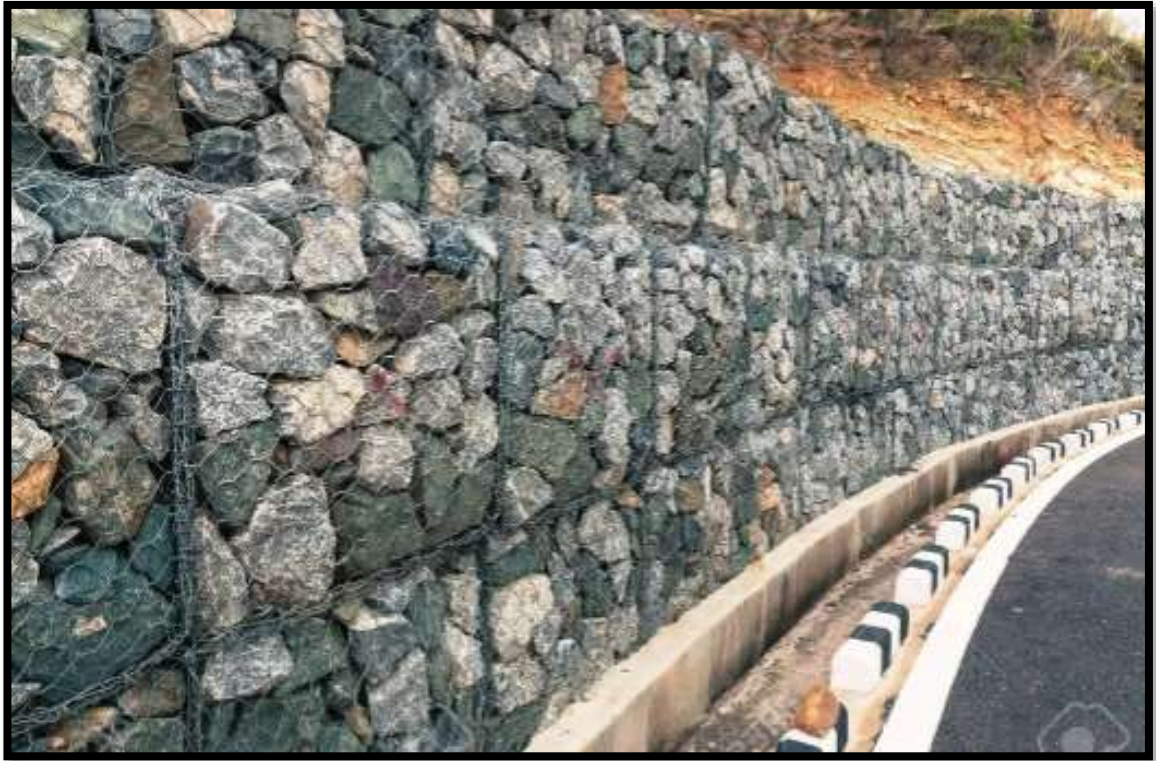
Figura 6: Muro de Retención de gaviones Fuente: Extraído de canal de construcción.
