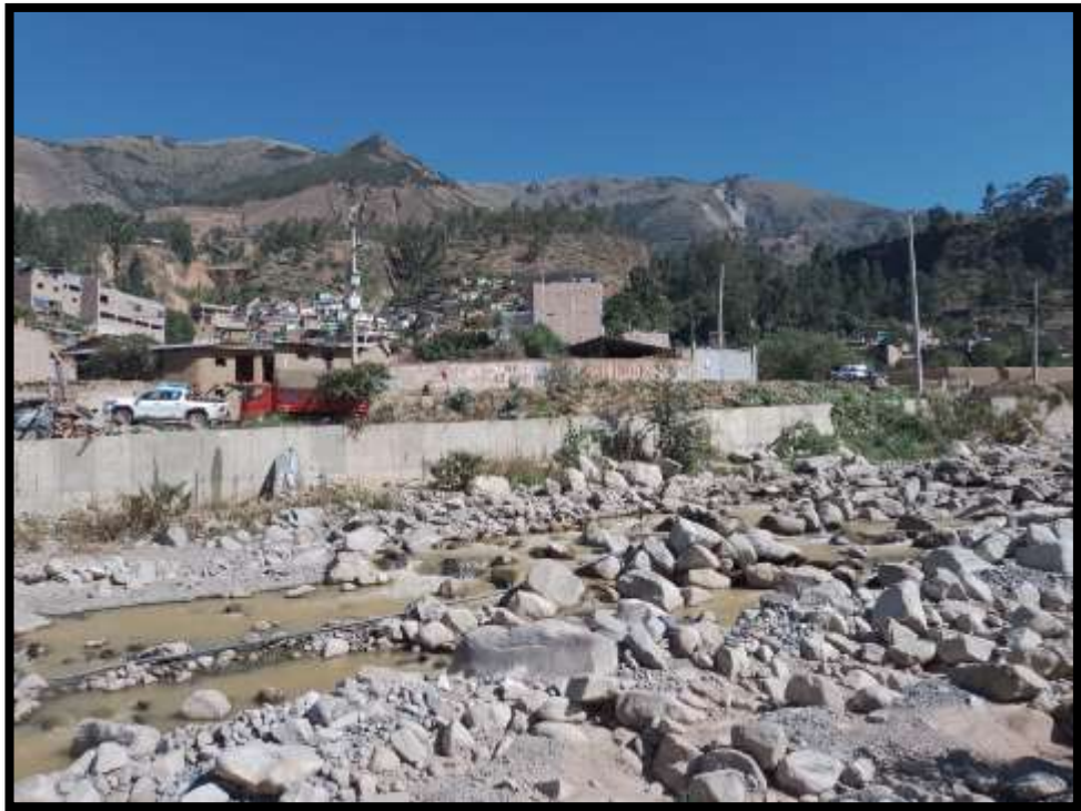
Figura 22: Muro de contención margen derecho progresiva 0+300 - 0+400. Fuente: Evidencia de campo
