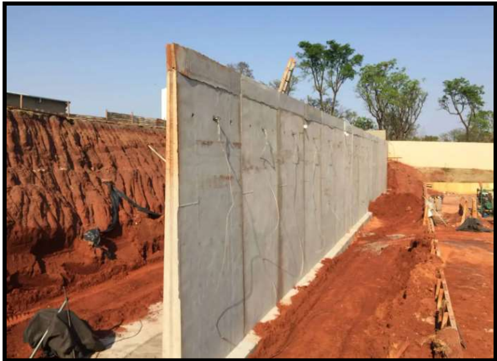
Figura 17: Muro de contención de tierra estabilizado mecánicamente. Fuente: extraído de canal de construcción.
