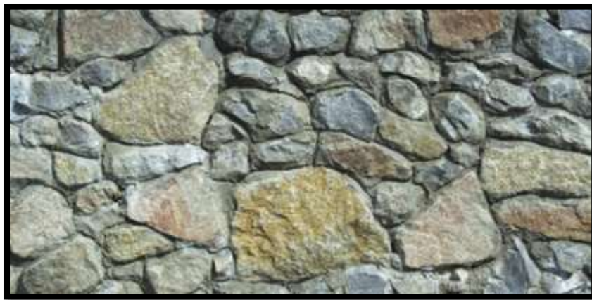
Figura 4: Muro de Retención de concreto ciclópeo. Fuente: Extraído de canal de construcción.
