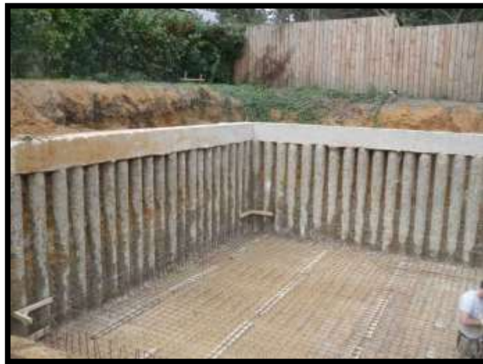
Figura 13: Muro de contención apilado. Fuente: Extraído de canal de construcción.
