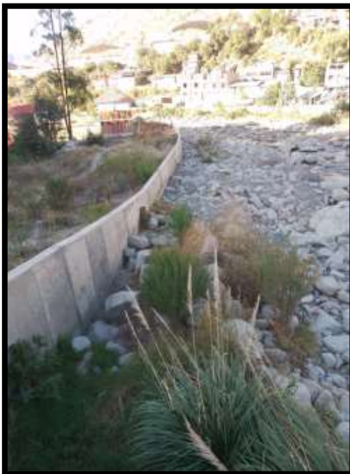
Figura 33: Muro de contención progresiva 0+000. Fuente: Evidencia de campo
