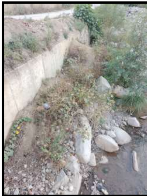
Figura 31: Desmonte en el cauce del río Torobamba y muro de contención. Fuente: Evidencia de campo
