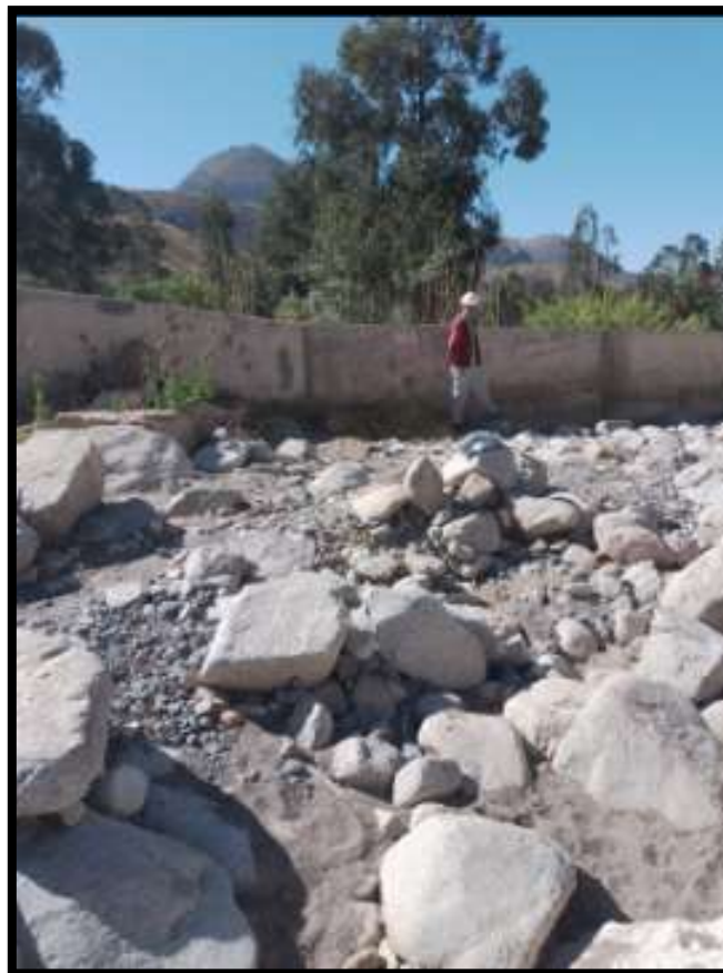
Figura 25: Muro de contención margen izquierdo progresiva 0+050. Fuente: Evidencia de campo
