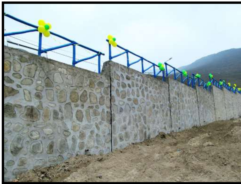
Figura 3: Contención a gravedad. Fuente: Extraído de Arcus.
