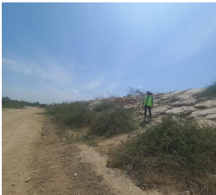
Figura Nª 02: Maleza de Vegetación en los laterales e intermedio del enrocado
