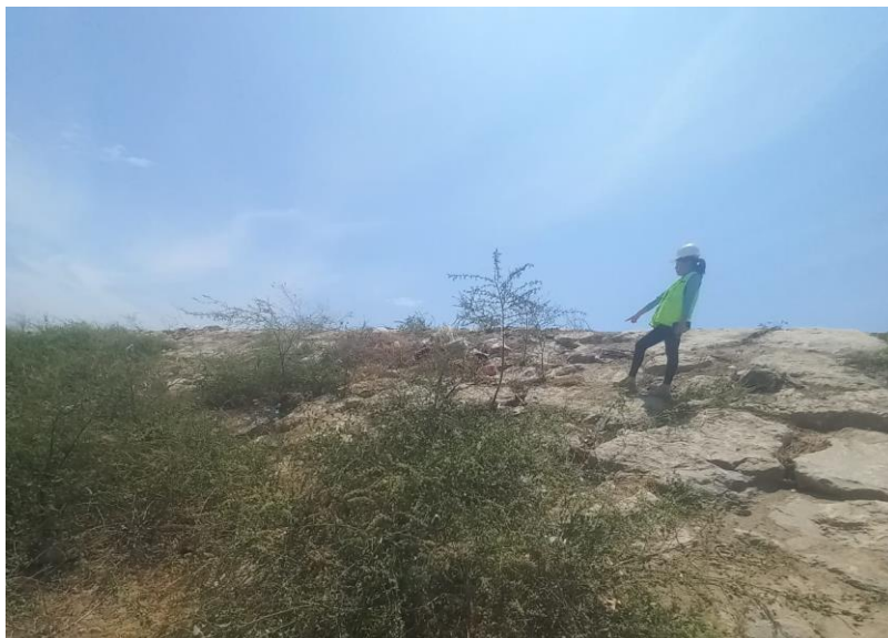
Figura N° 06: Verificación de la Condición del enrocado
