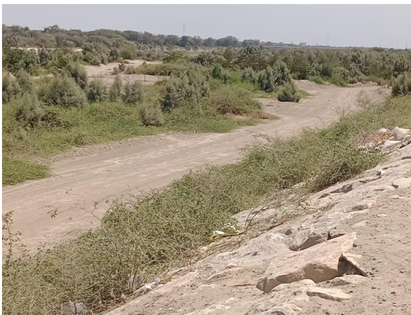
Figura Nª 1: Vista panorámica Margen izquierdo del río Piura en el Caserío Viduque Distrito de Catacaos
