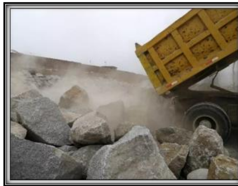
Figura 02: Enrocado roca al volteo
