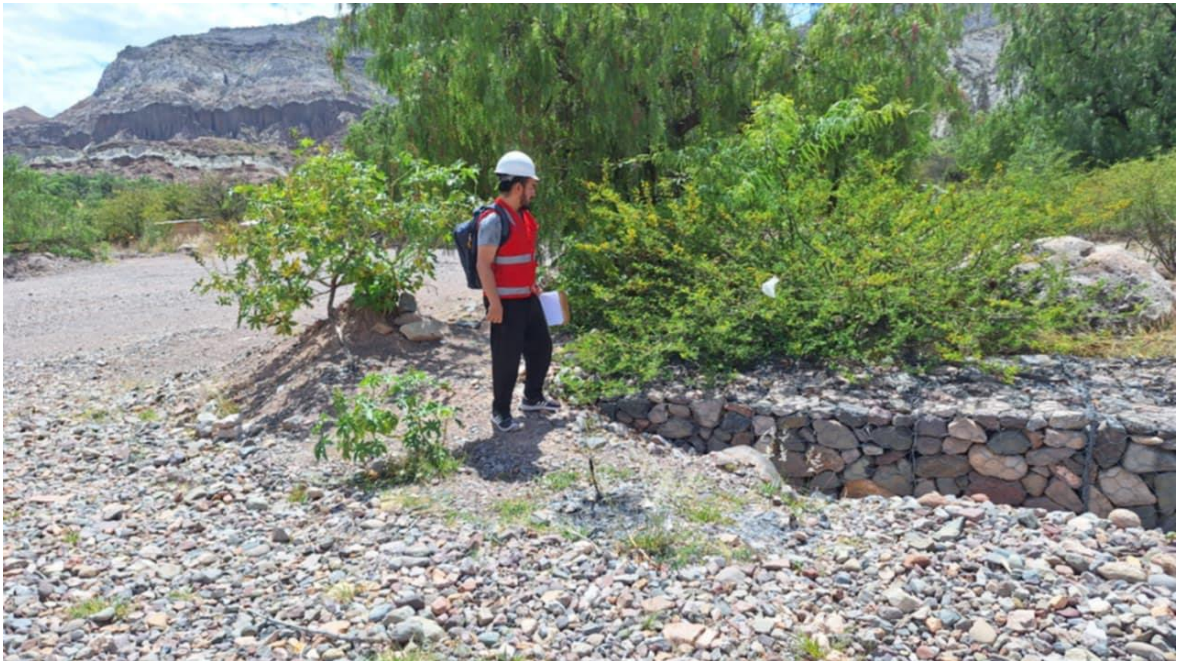
Figura 38. Término del sistema de gaviones del tramo evaluado que origina un punto crítico con respecto al río y las tierras de cultivo. Fuente: Elaboración propia 2024
