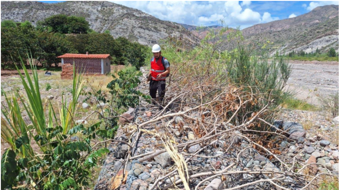
Figura 42. Determinando si la vegetación en el sistema de gaviones afecta o no a su estructura. Fuente: Elaboración propia 2024
