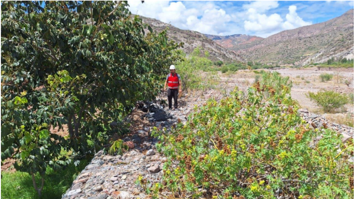
Figura 36. Evaluación del sistema de gaviones. Fuente: Elaboración propia 2024
