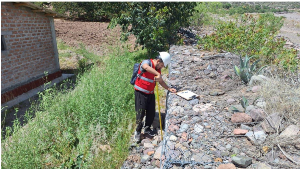
Figura 46. Tomando las dimensiones de los muros de gaviones en tramos diferentes. Fuente: Elaboración propia 2024
