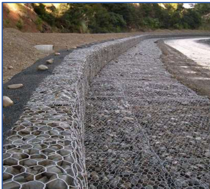
Figura 8: Gaviones tipo colchón.
