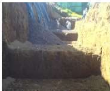
Figura 41. Distintos niveles de fundación del muro.
