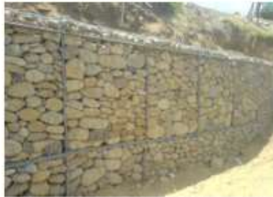
Figura 51. Apariencia final deseada de los gaviones.
