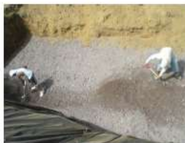
Figura 42. Mejoramiento de la base con lastre.
