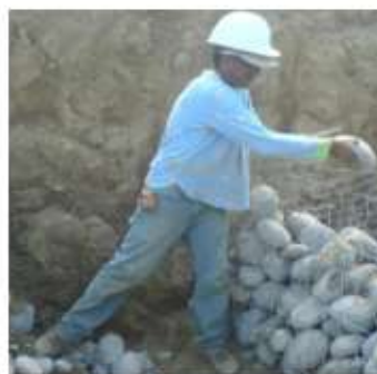
Figura 49. Llenado de gaviones.
