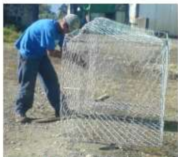
Figura 44. Armado de gaviones.
