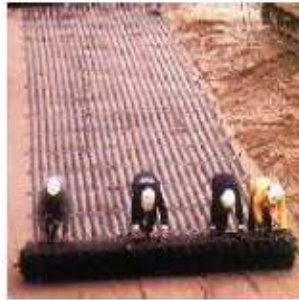
Figura 30. Uso de geogrieta en refuerzo de suelos 9 .
