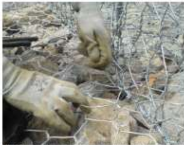
Figura 50. Amarre de las camadas superiores del gavión.
