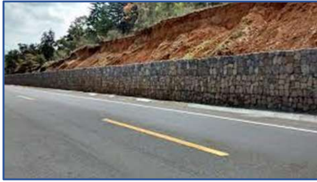
Figura 15: Gaviones para protección vial.
