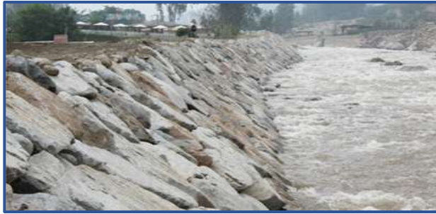
Figura 19: Revestimiento en enrocado.
