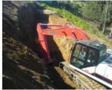
Figura 40. Proceso de excavación.
