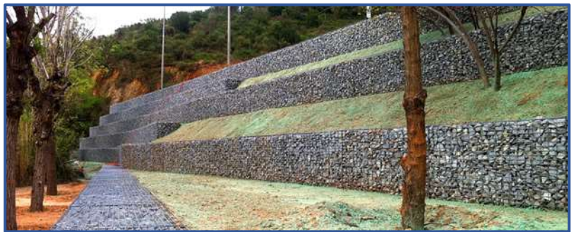
Figura 16: Gaviones de uso arquitectónico.
