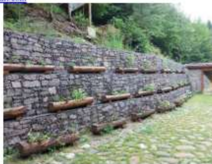
Figura 1. Estructura con gaviones. Fuente: http://www.solucionesespeciales.net/MedioAmbiente/Gaviones/Gaviones.aspx
