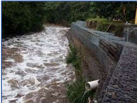
Figura 14: Gaviones para ríos y canales.
