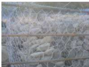
Figura 47. Formateo con varilla en la cara externa del muro.
