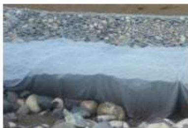
Figura 48. Geotextil en la espalda del muro.
