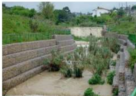
Figura 22. Encauzamiento de rios. Fuente: (A Bianchini, 2017)
