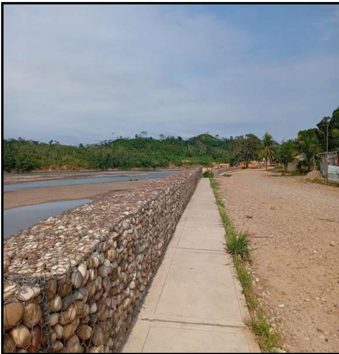
Figura 28: Longitud del muro de gaviones
