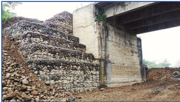
Figura 12: Gaviones para protección de puentes.
