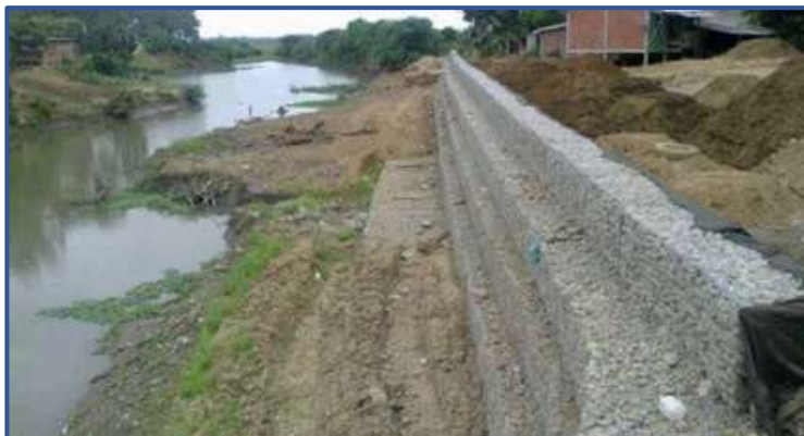
Figura 6: Muro de gaviones.
