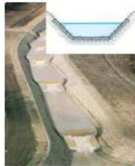
Figura 34. Canalización a base de colchones 3 .
