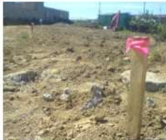
Figura 39. Estacas indicando la línea de excavación.
