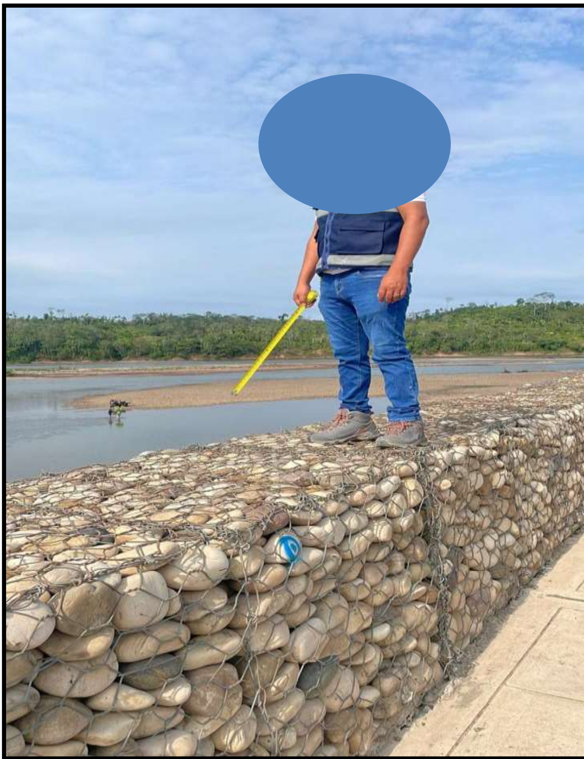
Figura 29: Observación en qué estado está el muro de gaviones.
