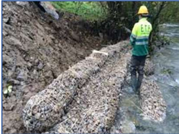
Figura 9: Gaviones tipo saco.
