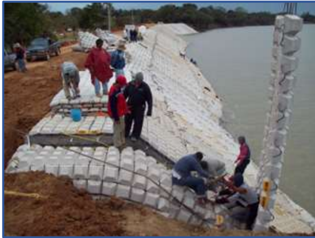
Figura 22: Concreto articulado.
