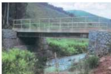
Figura 37. Apoyo de puentes 9 .
