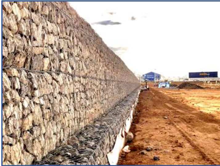
Figura 13: Muro de contención de gaviones.
