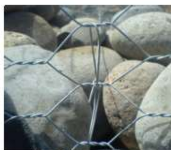
Figura 46. Colocación de tensores.
