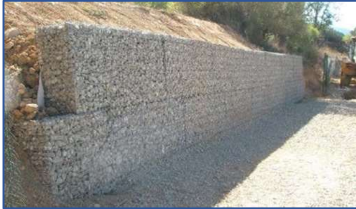
Figura 11: Gaviones para protección de taludes.
