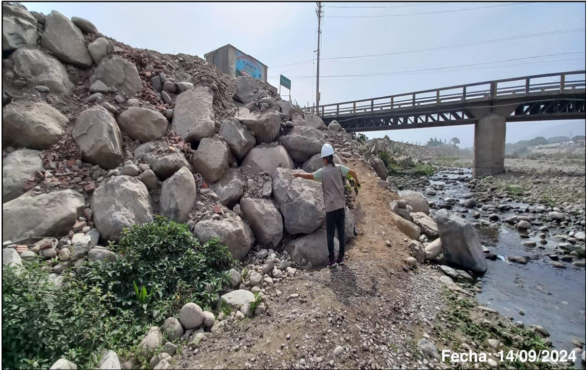
Foto 3: Medición del relleno del enrocado, margen derecha del río Chillón, aguas abajo del puente Trapiche
