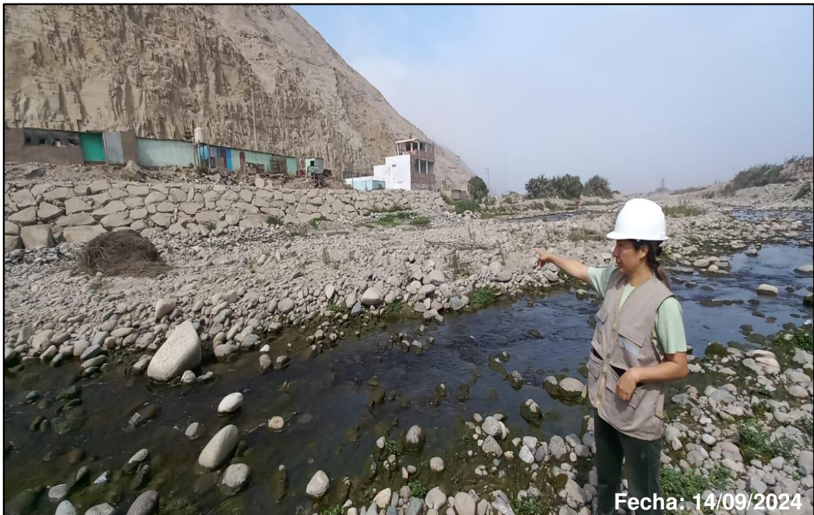
Foto 11: Se observa la margen izquierda del río Chillón, aguas abajo del puente Trapiche
