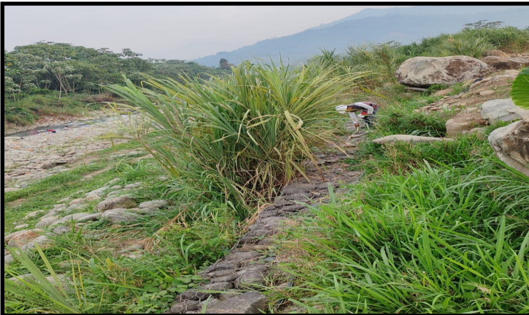
Figura 16: Defensa ribereña con rocas, tierra y desmontes.
