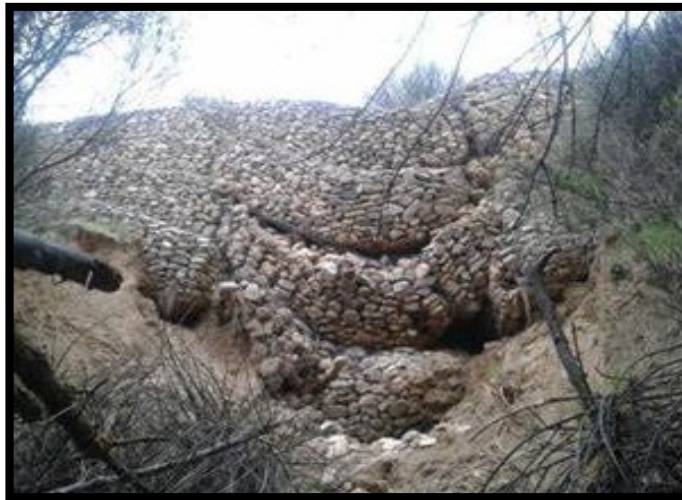
Figura 5: Erosión de un muro de gavión
