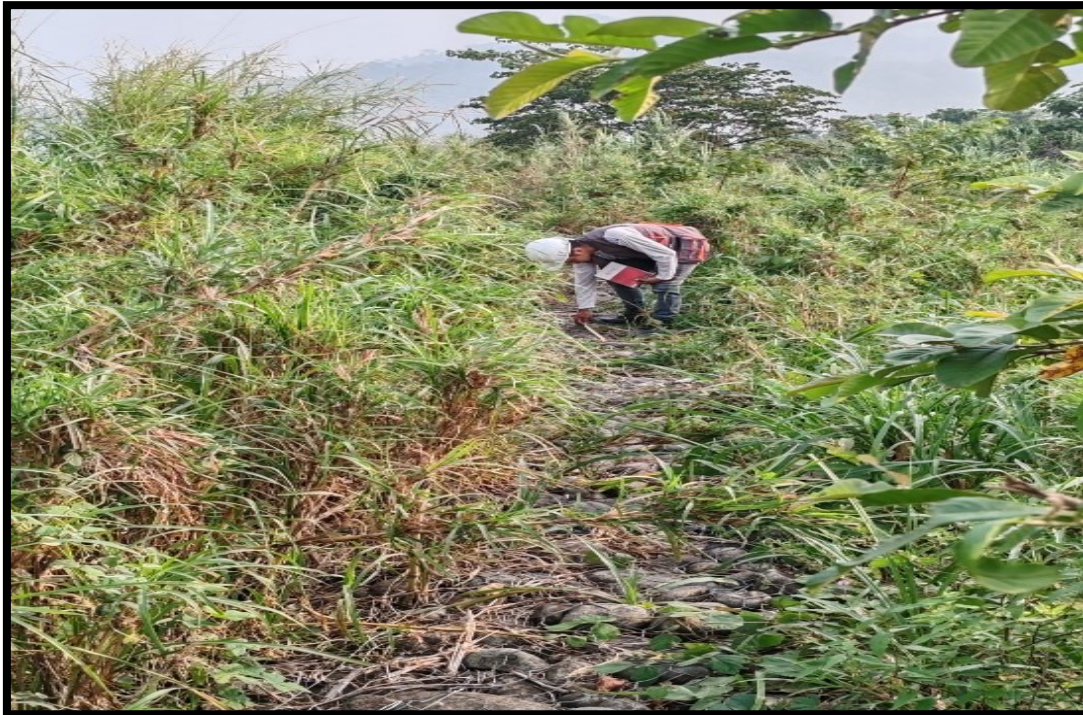
Figura 23: Muro de gavi3n tiene 1 mt de ancho
