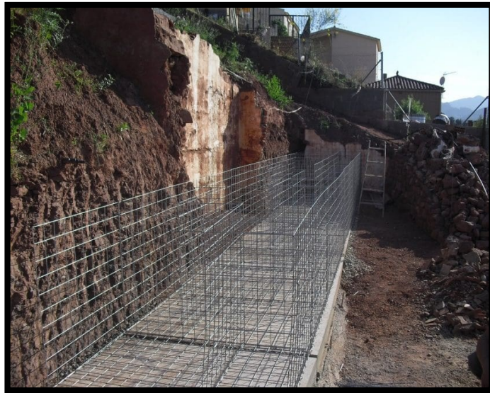
Figura 6: Estructura de un muro
