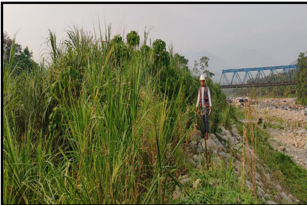
Figura 24: vista panoramica del puente Pichari entre Ccatun Rumi
