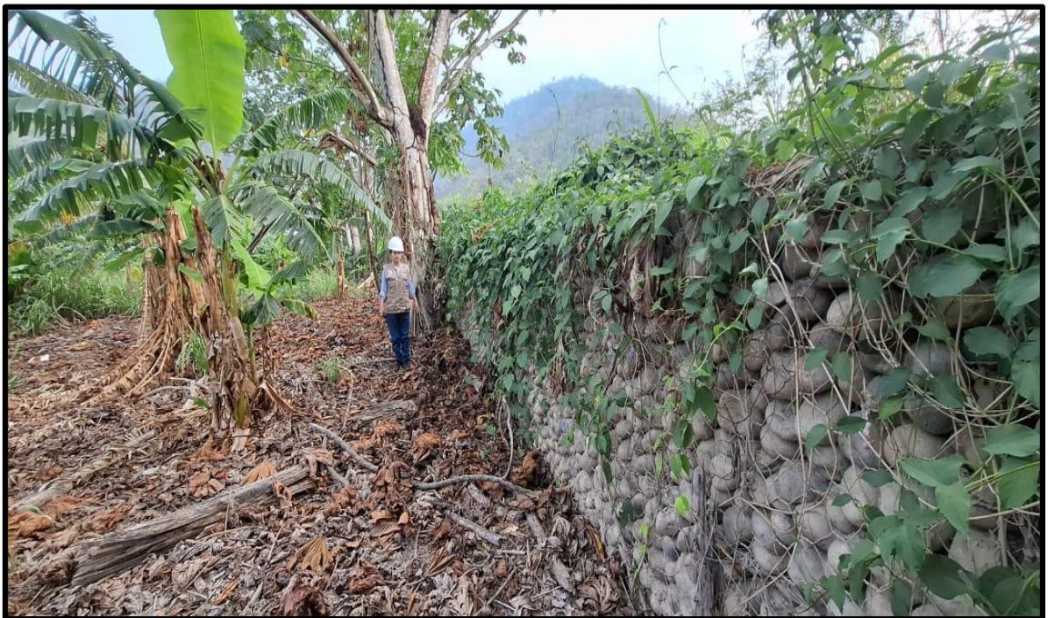
Figura 16: maleza en cajas de gaviones
