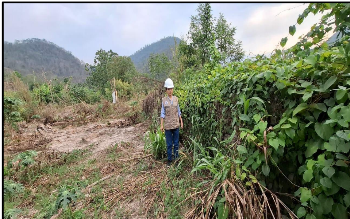
Figura 11: realizando evaluación de muros de gaviones
