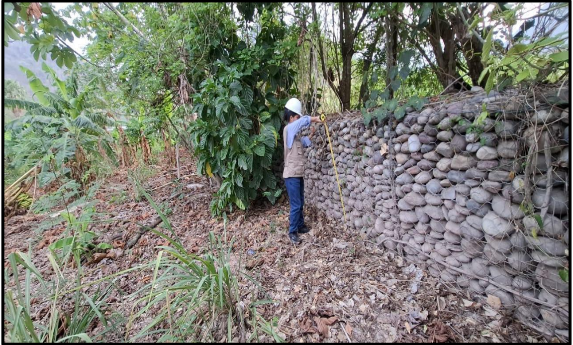
Figura 15: evaluación de muros de gaviones
