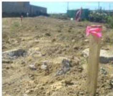
Figura 39. Estacas indicando la línea de excavación.
