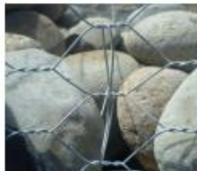
Figura 46. Colocación de tensores.
