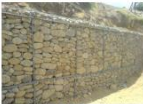
Figura 51. Apariencia final deseada de los gaviones.
