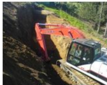
Figura 40. Proceso de excavación.
