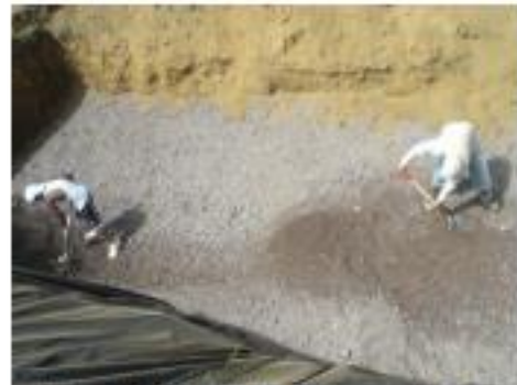
Figura 42. Mejoramiento de la base con lastre.
