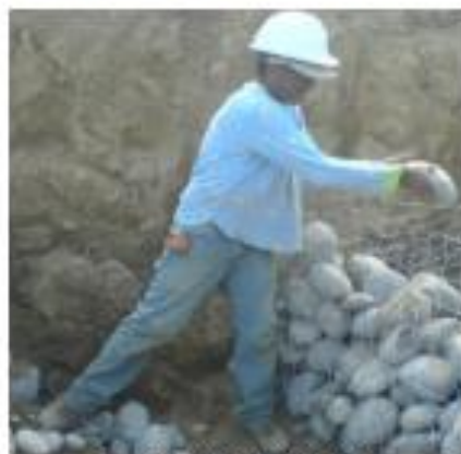
Figura 49. Llenado de gaviones.
