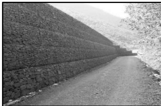
Figura N° 09: Muro de gavión en carreteras.
