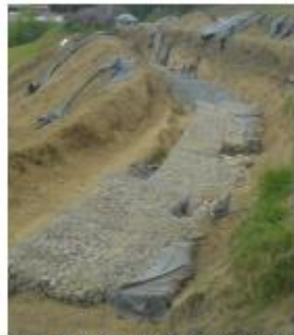
Figura 52. Muro de gaviones a la fecha de corte.
