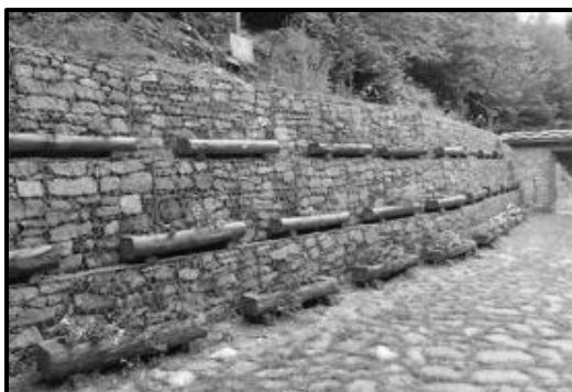
Figura N° 01: Muro de gaviones
