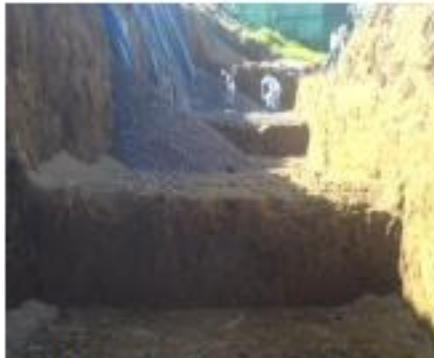
Figura 41. Distintos niveles de fundación del muro.
