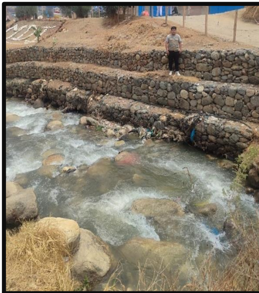
Figura 14: Vista panorámica del muro de gavión.
