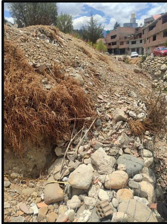
Figura 9: Vista de desmonte en el muro de gaviones.
