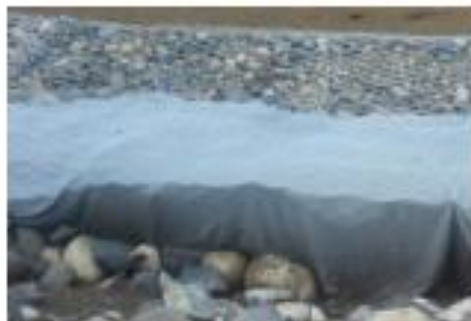
Figura 48. Geotextil en la espalda del muro.
