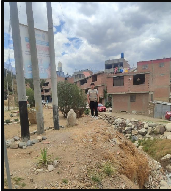
Figura 5: Vista del inicio del muro de gavión.
