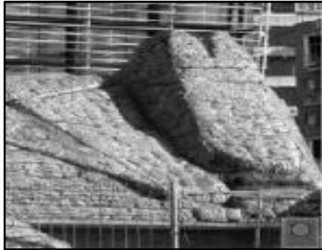
Figura N° 10: Estructura con gavión.
