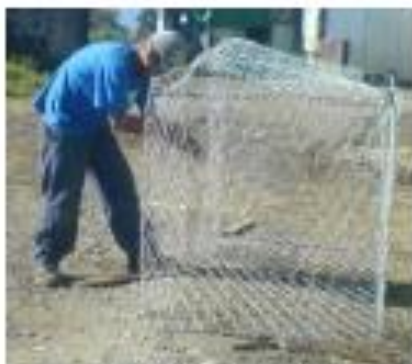
Figura 44. Armado de gaviones.
