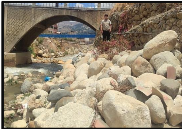
Figura 10: Vista de rocas en la parte baja del muro de gavión.
