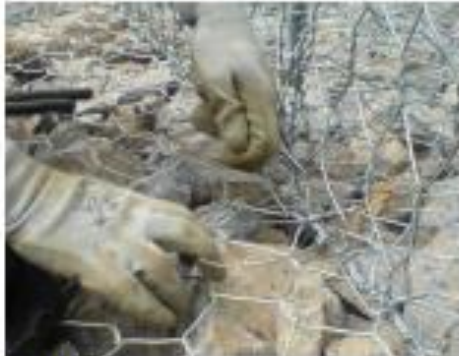
Figura 50. Amarre de las camadas superiores del gavión.
