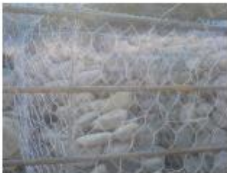
Figura 47. Formateo con varilla en la cara externa del muro.
