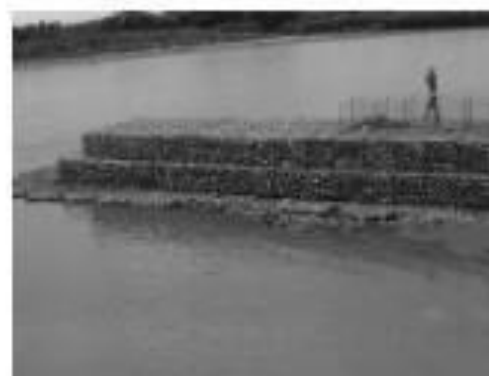
Fig. 9.20 Obra construida con gaviones CajaFuerte ®
