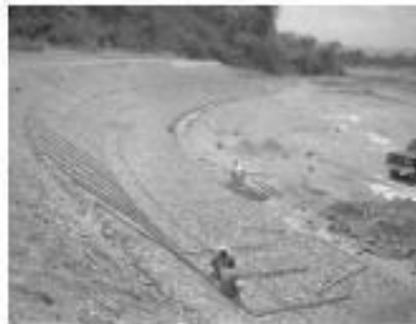
Fig. 9.16 Venezuela: protección de revestimiento de colchones Reno® con concreto variado en construcción
