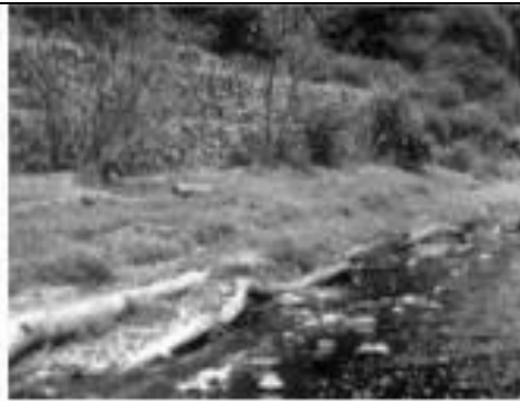
Fig. 9.13 Bolivia: protección con troncos de la plataforma antierosión en colchones Reno®
