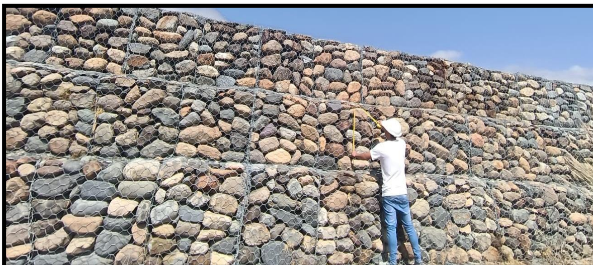
Figura 13: Medicion del diametro de las piedras. Fuente: Elaboración propia.
