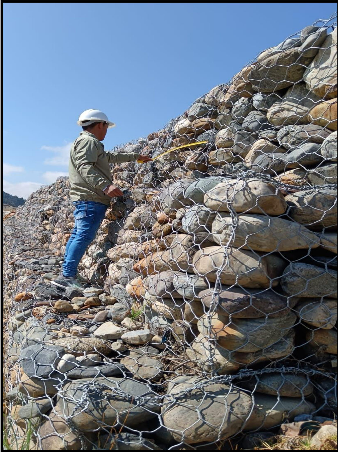
Figura 11: Medición del ancho de cada caja de gavión. Fuente: Elaboración propia.
