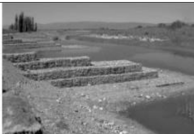
Fig. 9.5 Espigón en gaviones apoyado sobre una camada de piedras sueltas
