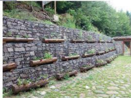
Figura 1. Estructura con gaviones. Fuente: http://www.solucionesespeciales.net/MedioAmbiente/Gaviones/Gaviones.aspx
