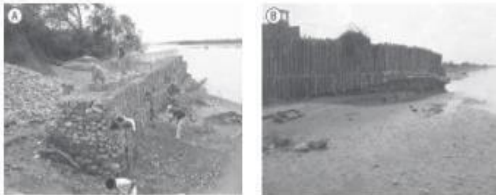
Fig. 9.12 Espigones en gaviones caja protegidos contra la abrasión con troncos
