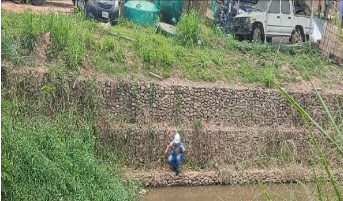
Figura 30: Se aprecia el tramo 0+800 a 0+900
