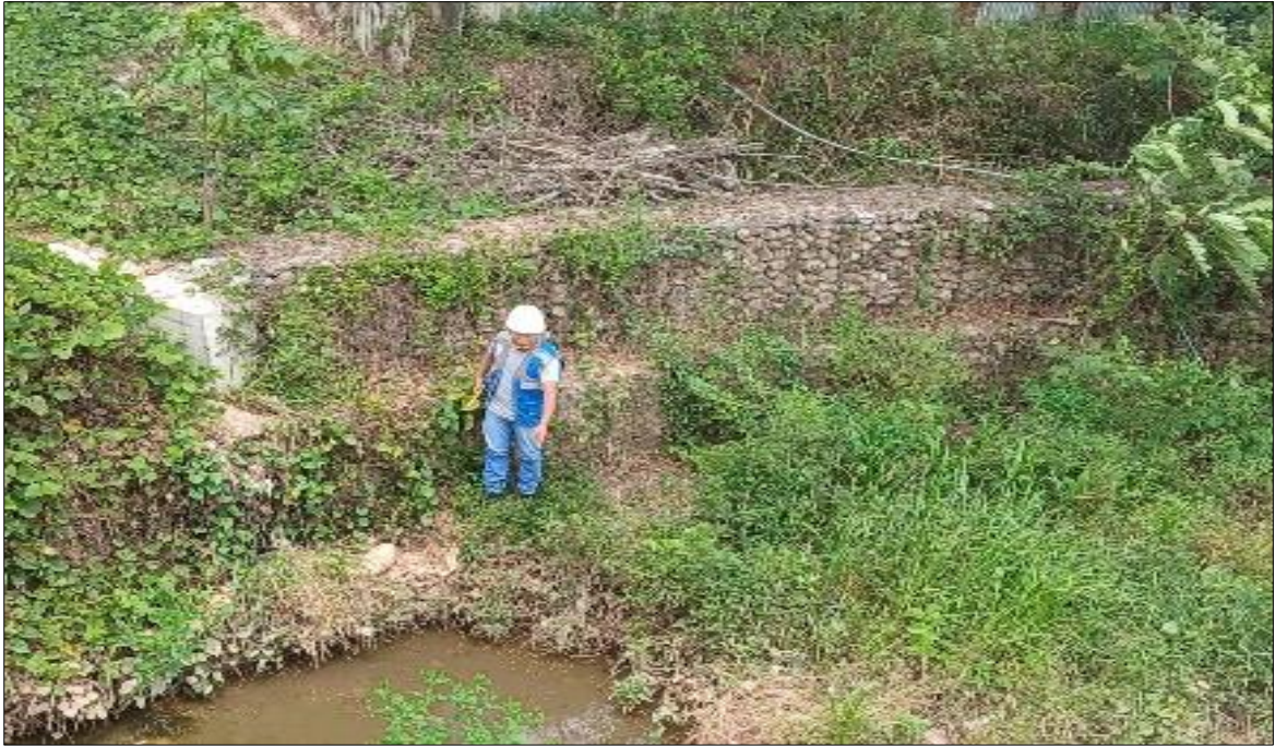
Figura 15: Zonas vulnerables en el tramo 0+100 a 0+200
