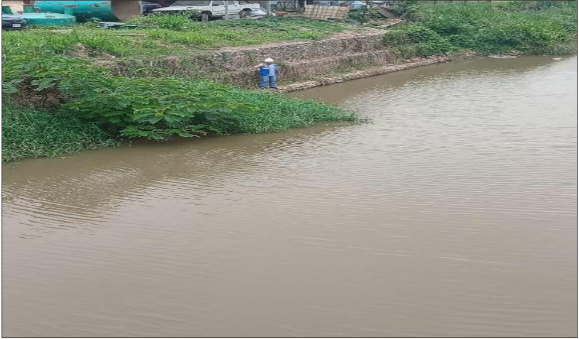
Figura 40: Se aprecia mucha vegetación en el tramo 0+800 a 0+900
