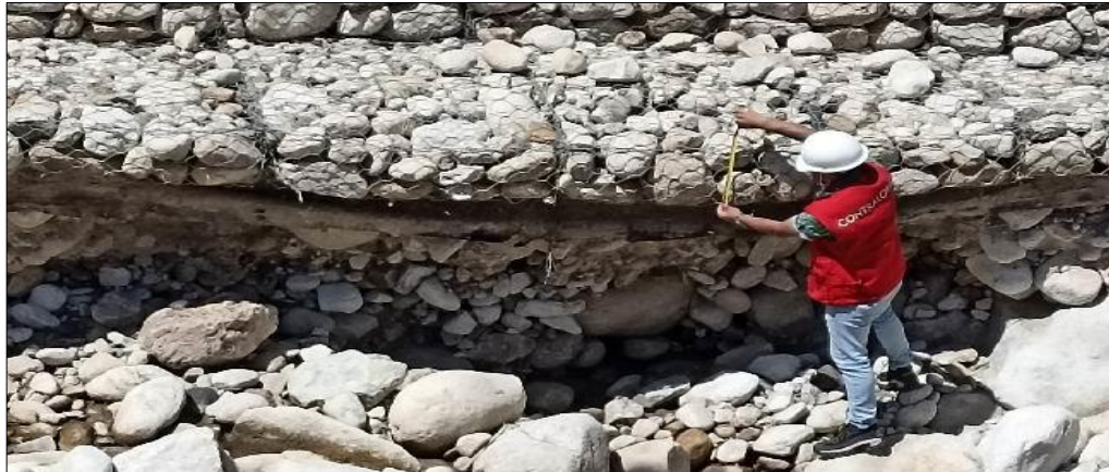
Figura 1: Evaluación y mejoramiento de muro de gaviones
