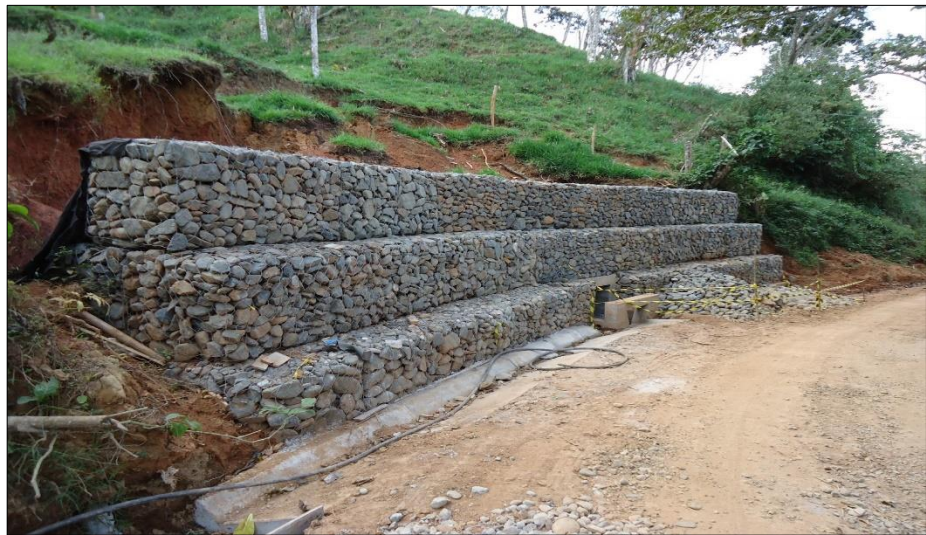
Figura 5: Muro de gavión
