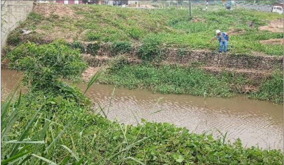
Figura 22: Se aprecia el tramo 0+000 a 0+100
