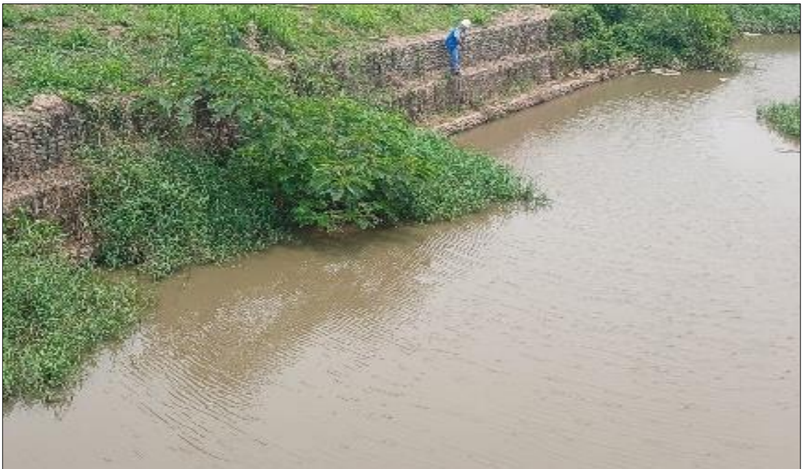
Figura 29: Se aprecia el tramo 0+700 a 0+800
