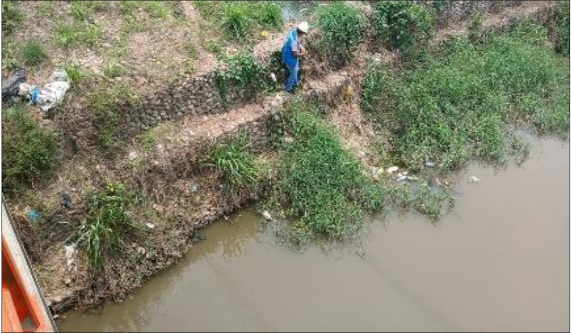
Figura 28: Se aprecia el tramo 0+600 a 0+700
