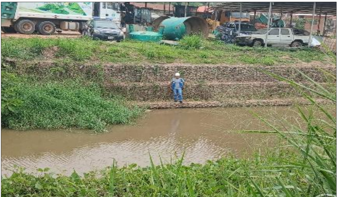
Figura 25: Se aprecia el tramo 0+300 a 0+400
