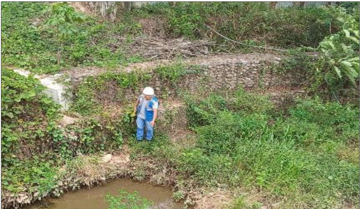
Figura 23: Se aprecia el tramo 0+100 a 0+200
