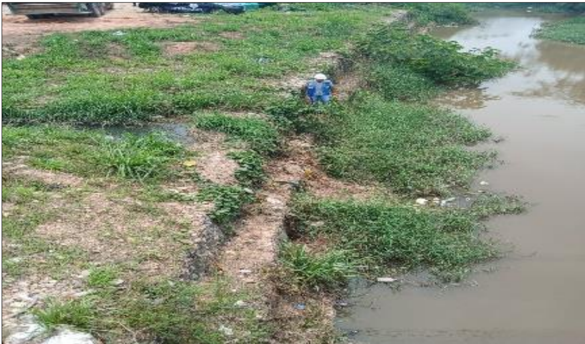
Figura 31: Se aprecia el tramo 0+900 a 1+000
