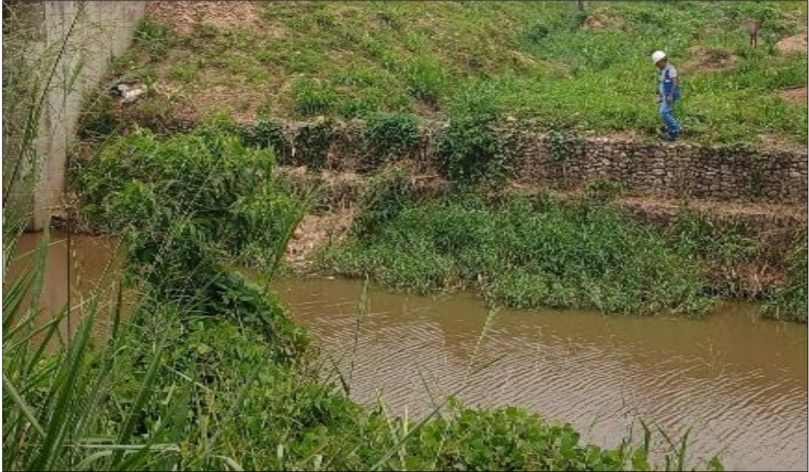
Figura 24: Se aprecia el tramo 0+200 a 0+300
