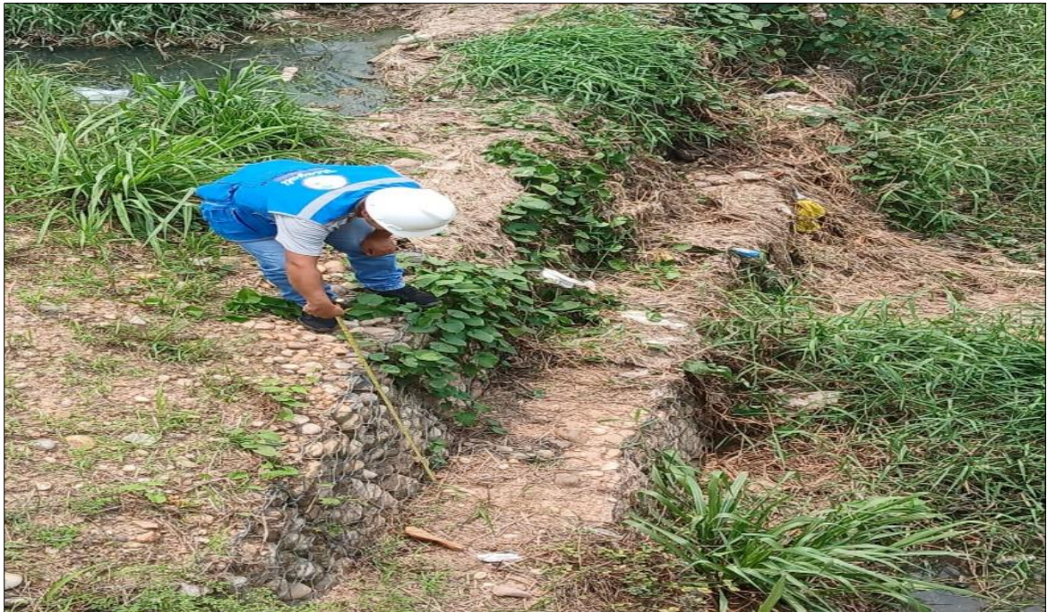
Figura 17: Midiendo el muro de gavión tipo caja
