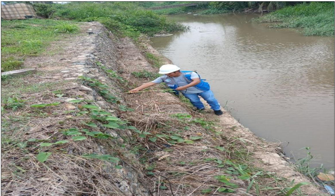
Figura 33: Se observa la mediciones del muro de gaviones
