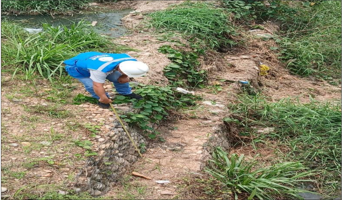
Figura 32: Se observa el muro de gavión tipo caja
