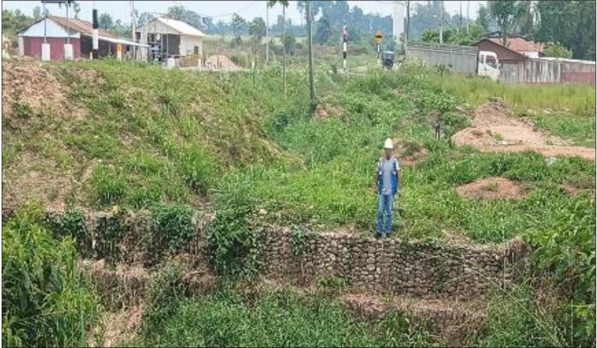
Figura 26: Se aprecia el tramo 0+400 a 0+500
