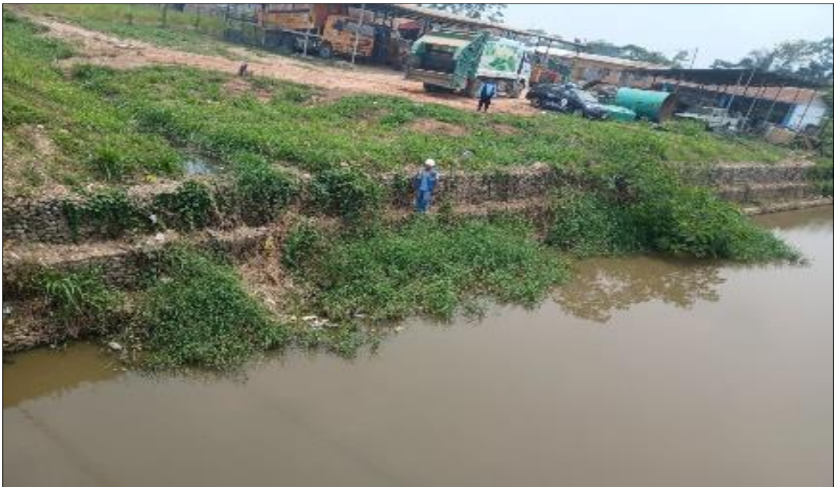
Figura 27: Se aprecia el tramo 0+500 a 0+600
