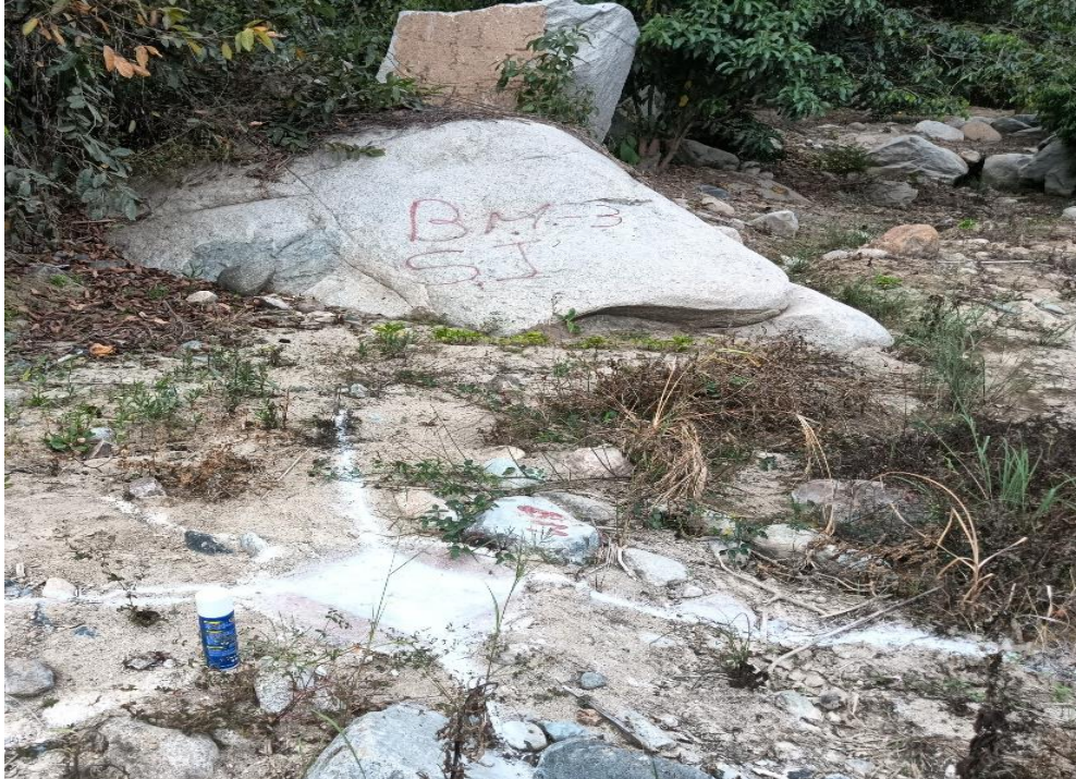
Fotografía 4. Colocación de los puntos de control BM para la realización del replanteo.
