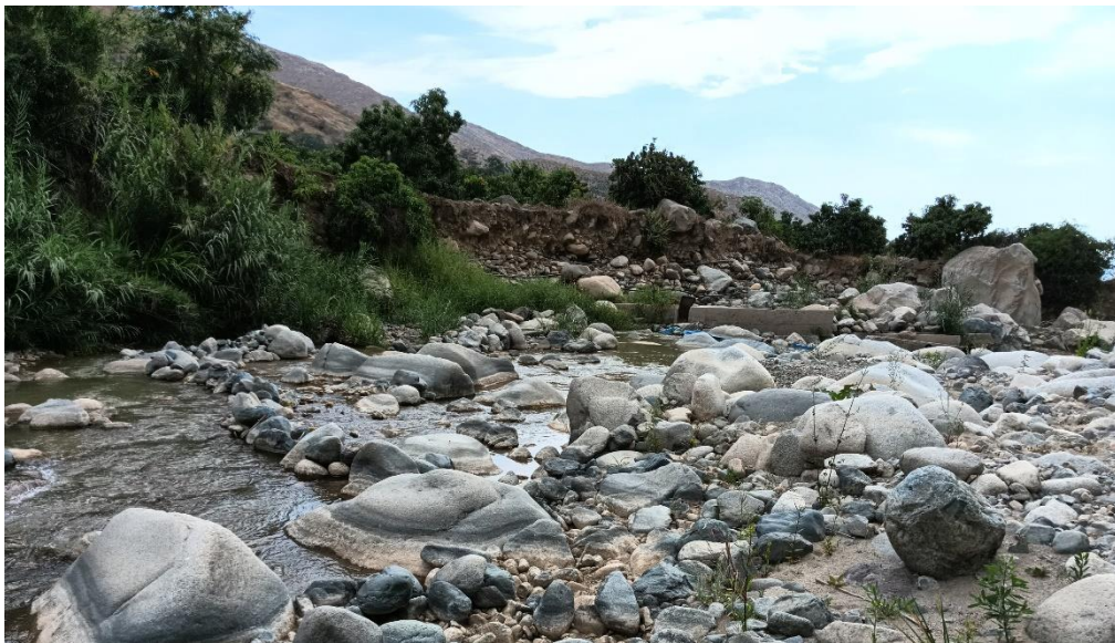
Fotografía 7. Vista aguas arriba del cauce del rio Grande, donde se observa la colmatación del cauce del rio.
