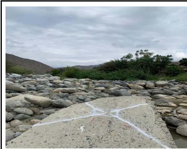
FOTO 01: Colocado de Puntos de Fotocontrol.
