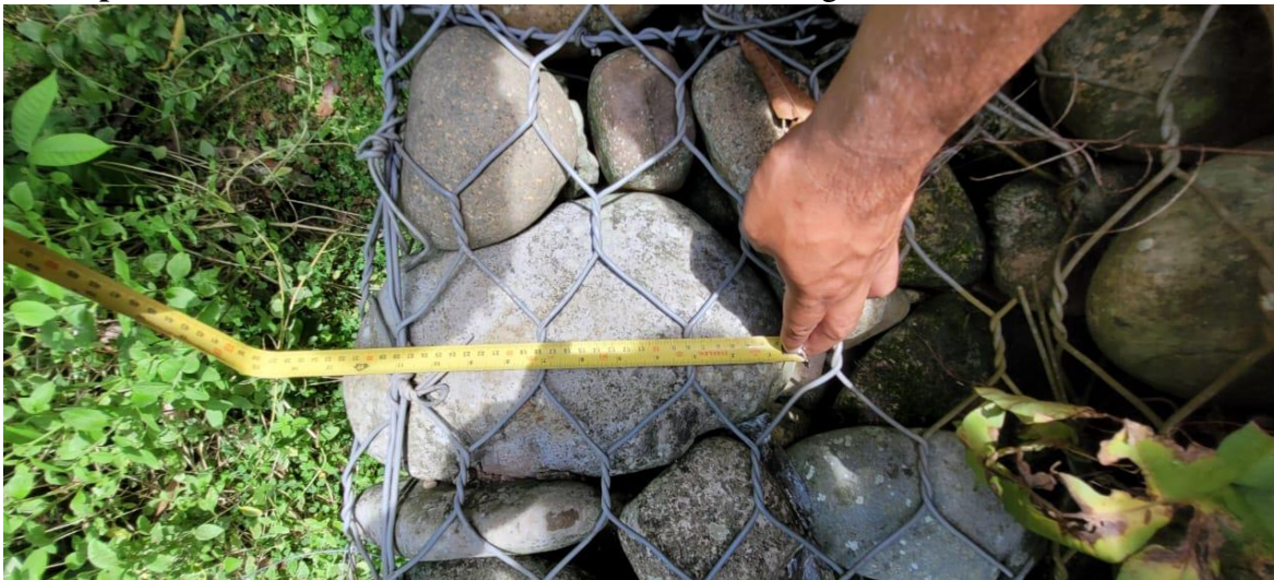
Figura 19: Evidencia de campo - Medición de material de relleno
