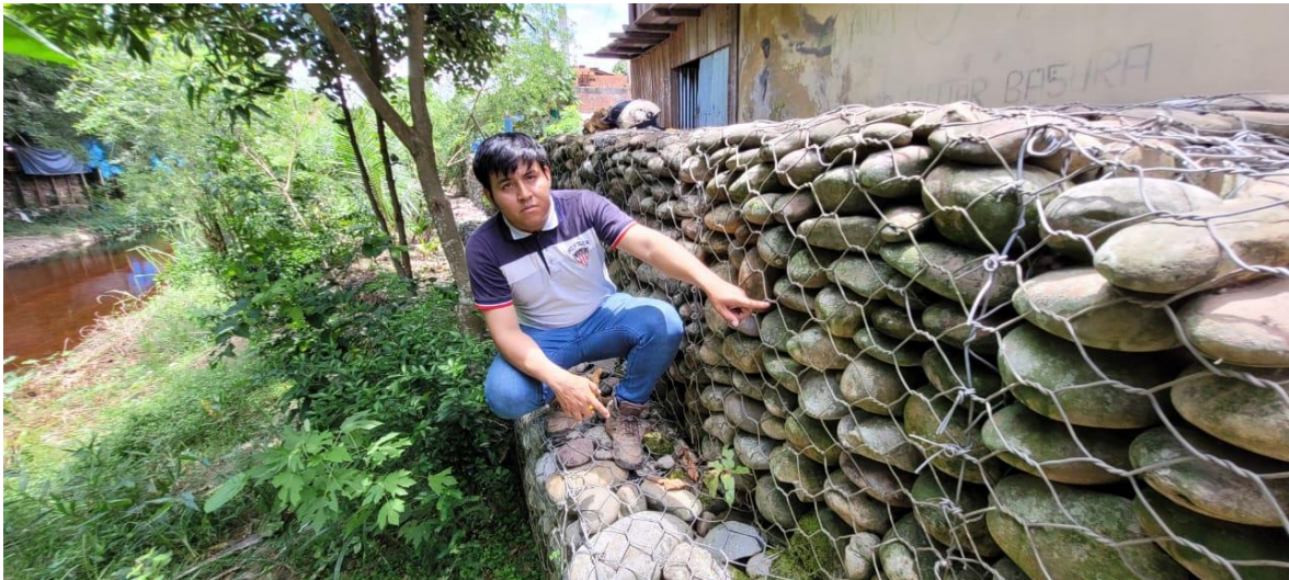
Figura 18: Evidencia de campo - Malla de muro de gaviones
