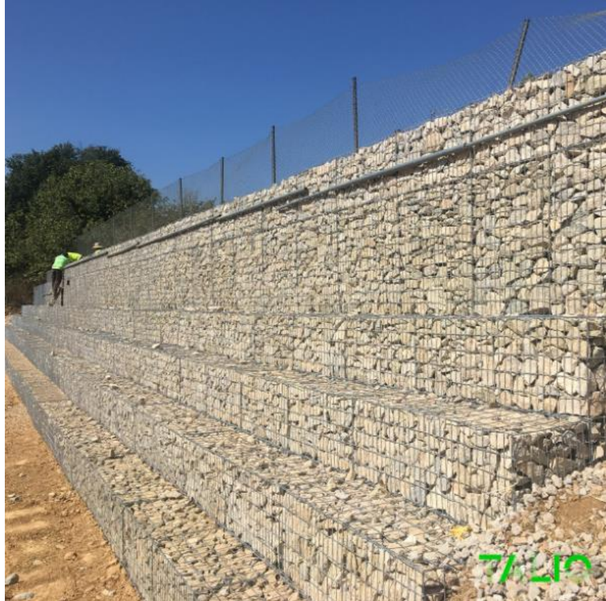
Figura 3 Muro de gaviones: Fuente: Extraído de la página de talio (19)
