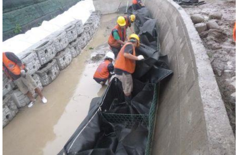
Figura 10: Colocación de Geotextil en gaviones Fuente: Extraído de la página de ACE (36)
