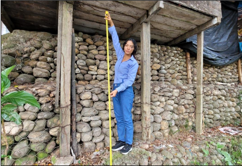
Figura 24: Tomando medida de la altura total del muro de gaviones de la defensa ribereña del Río Negro.
