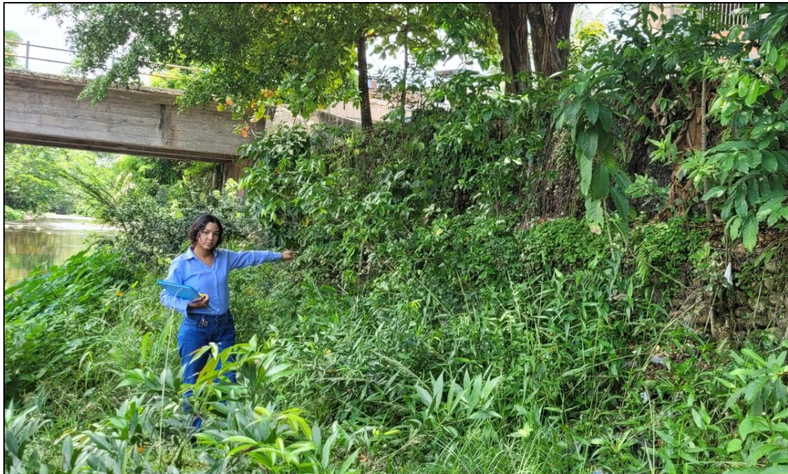
Figura 19: Vista panorámica de la primera zona crítica del muro de gaviones de la defensa ribereña en el Río Negro.
