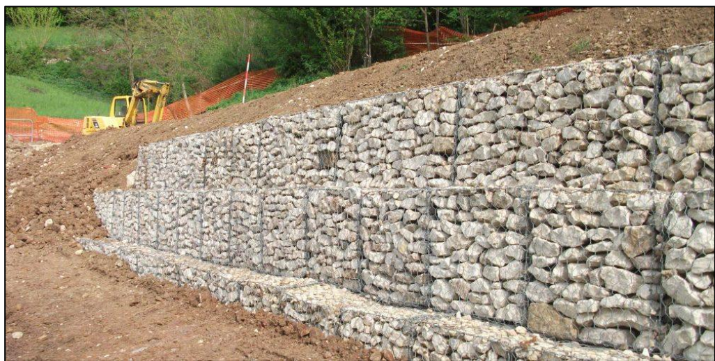
Figura 4: Muro de Gavión
