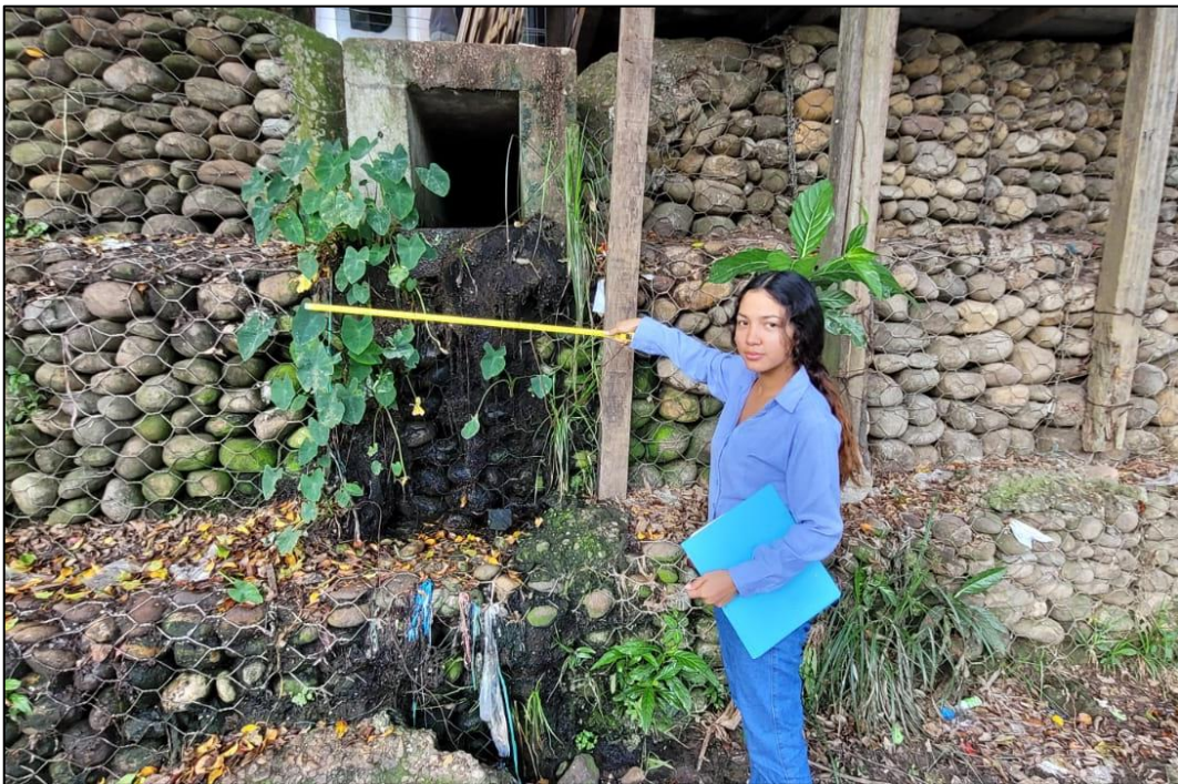
Figura 23: Identificación de la segunda zona crítica del muro de gaviones de la defensa ribereña del Río Negro.
