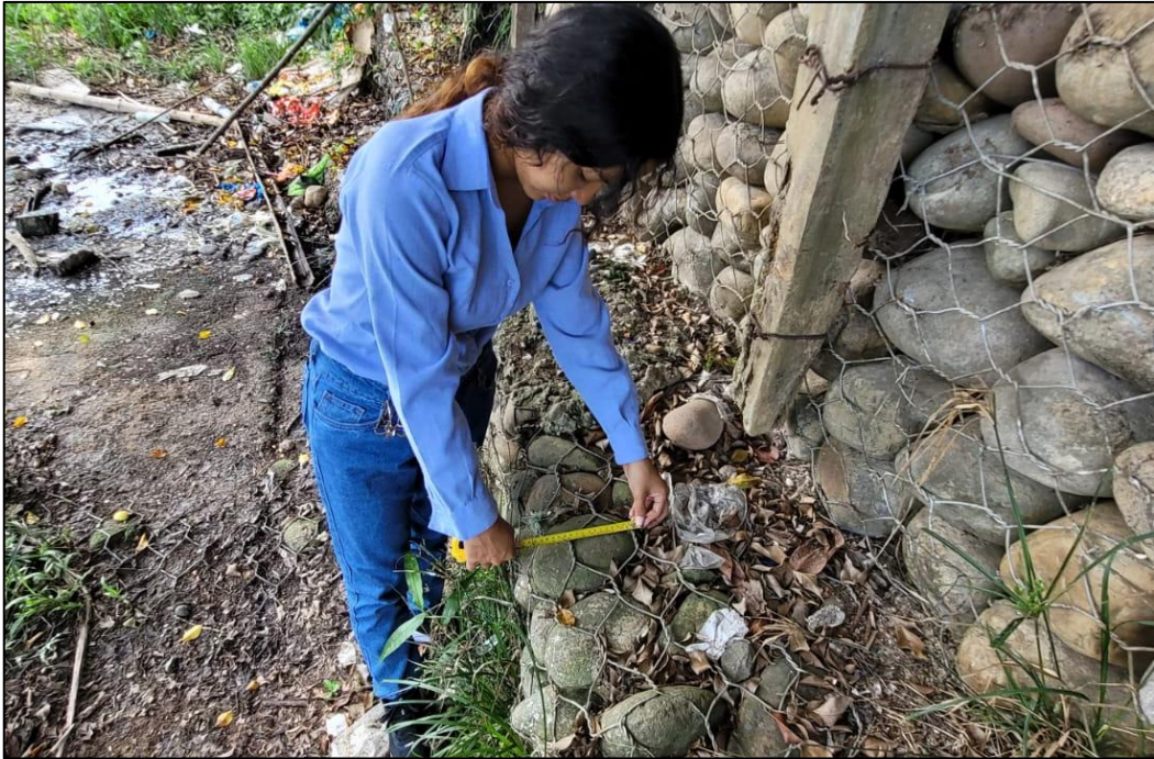
Figura 22: Verificando las medidas del material de relleno del muro de gaviones del Río Negro.
