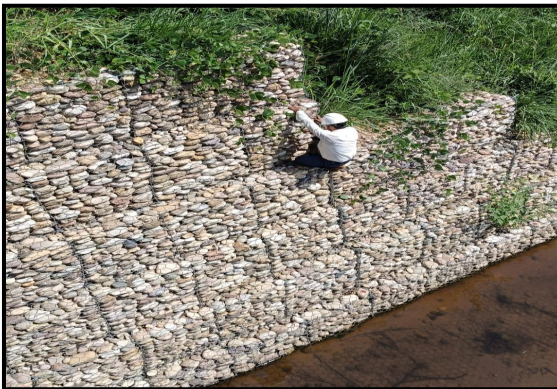
Fotografía 6. Se realizó la inspección de las cajas del muro de gavión
