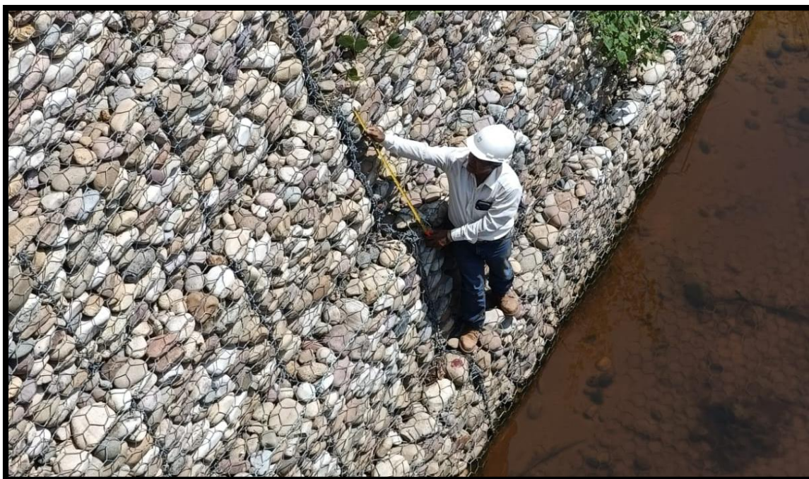
Fotografía 9. Medición de la altura de la caja de gaviones
