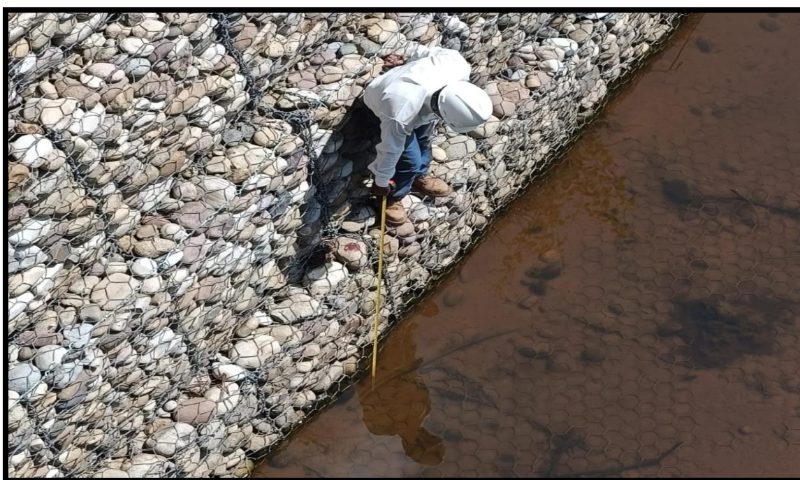
Fotografía 8. Se mide la base del colchón RENO del muro de gavión
