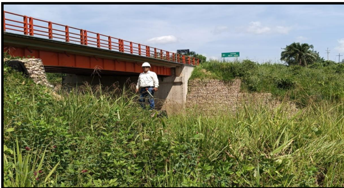
Fotografía 3. Vista del margen derecho del muro de gaviones
