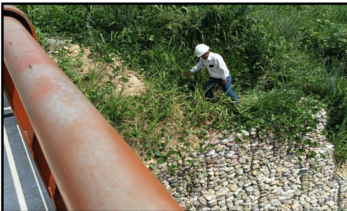
Fotografía 4. Se realizó la inspección del muro de gaviones del rio Wipungo, Margen derecho
