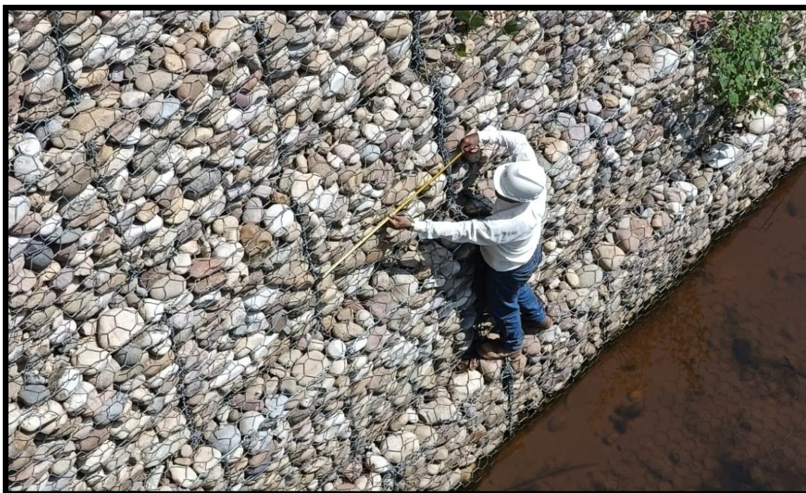
Fotografía 10. Medición del ancho de la caja de los gaviones
