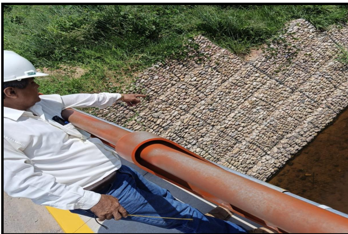
Fotografía 2. Se observa el muro de gaviones en evaluación
