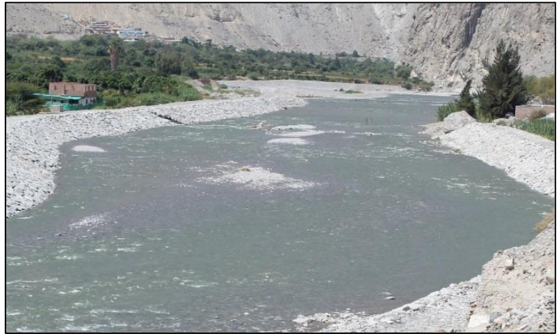
Figura 9. Enrocado en el río Cañete
