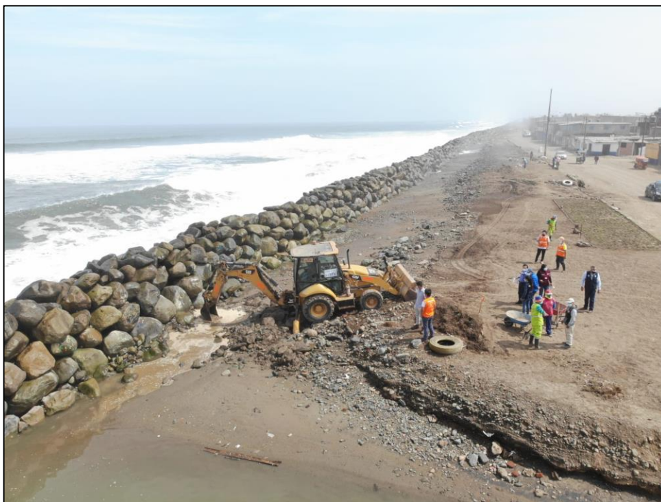
Figura 3. Mejora del enrocado
