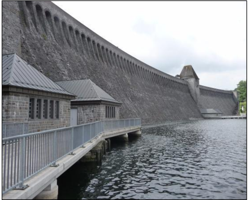
Figura 4. Enrocado con membrana en la presa Mohnesse Dam, Alemania
