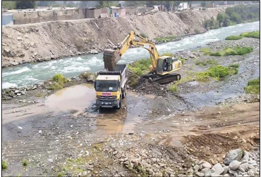
Figura 7. Descolmatación en el río Rímac
