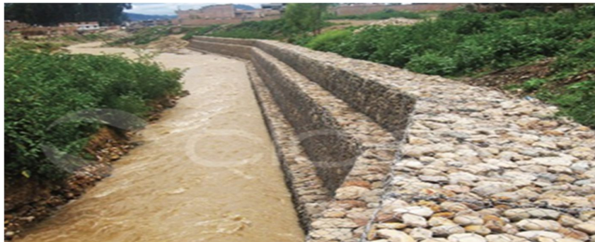
figura 1: Muro de Gaviones Fuente: Estriado del libro de Guerra C.
