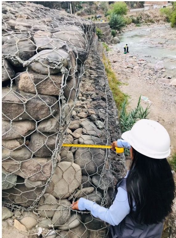
figura 8: Se observa la deformación de los 3 niveles, teniendo diferentes medidas de ancho en cada nivel de 43cm, 30cm y 28 cm
