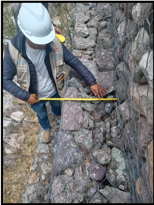
Figura 15: evaluación en la progresiva 1+100 - 1+200
