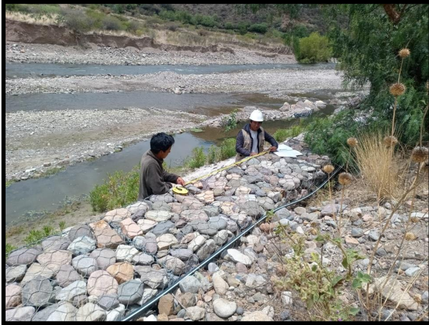
Figura 26: Evaluación de las medidas de las celdas del muro de gavión
