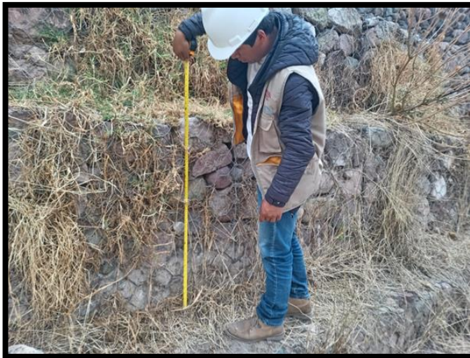
Figura 13: evaluación en la progresiva 0+900 - 1+000
