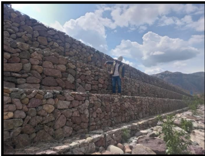
Figura 10: evaluación en la progresiva 0+600 - 0+700
