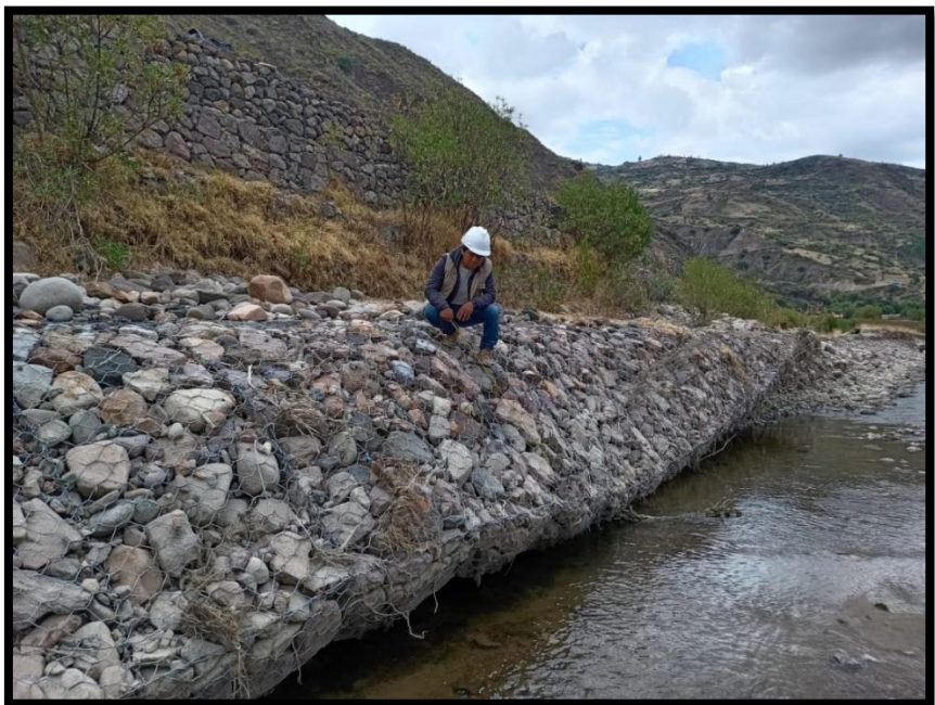
Figura 33: Identificación de los puntos críticos de los muros de gaviones
