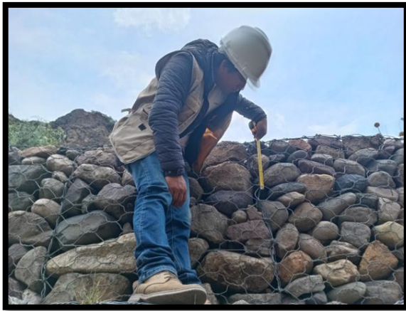
Figura 17: evaluación en la progresiva 1+300 - 1+400
