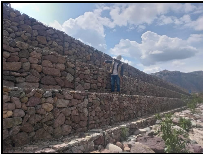
Figura 39: Evaluación del muro de gavión del rio Cachi
