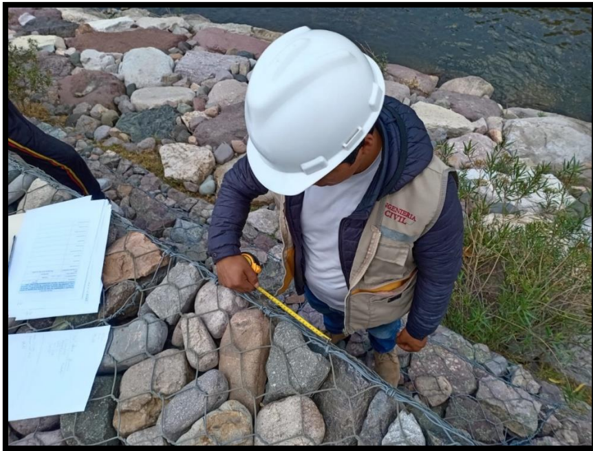
Figura 40: Evaluación del cocido del muro de gavión
