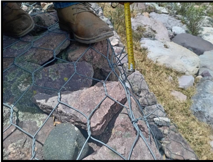
Figura 28: Evaluación del cosido de los muros de gaviones
