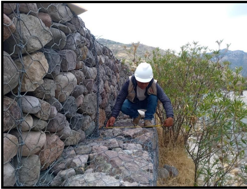
Figura 30: Evaluación de tercer nivel del muro de gaviones.
