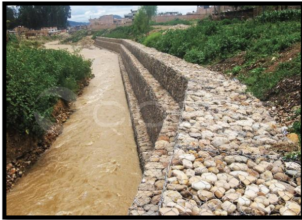
Figura 6: gaviones tipo muros de contención en defensa ribereña
