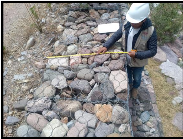
Figura 11: evaluación en la progresiva 0+700 - 0+800
