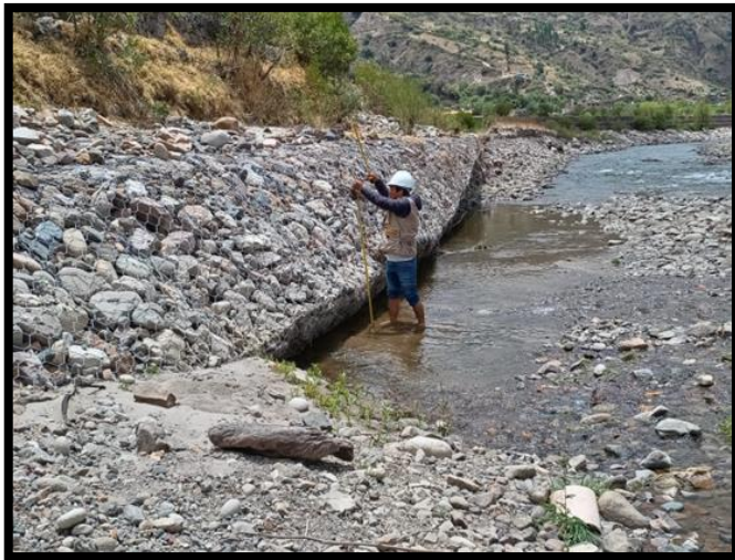
Figura 14: evaluación en la progresiva 1+000 - 1+100
