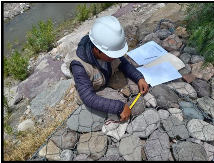
Figura 18: evaluación en la progresiva 1+400 - 1+500
