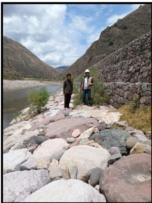
Figura 25: vista panorámica del muro de gavión
