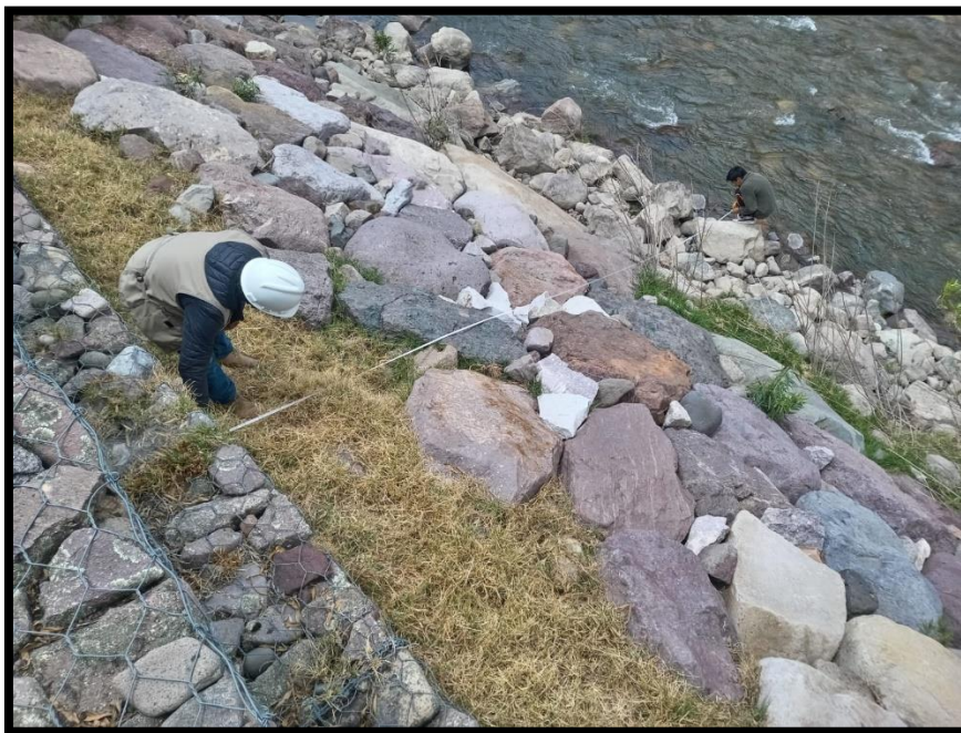
Figura 37: medida de la distancia de la protección por el enrocado al muro de gaviones
