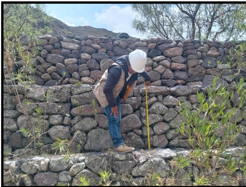
Figura 29: Evaluación de las alturas de los muros de gaviones
