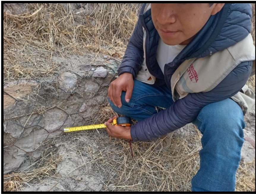
Figura 36: identificación de puntos críticos
