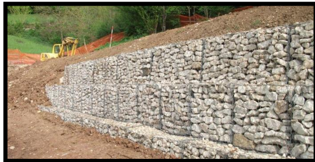
Figura 7 : gaviones tipo muro de contencion
