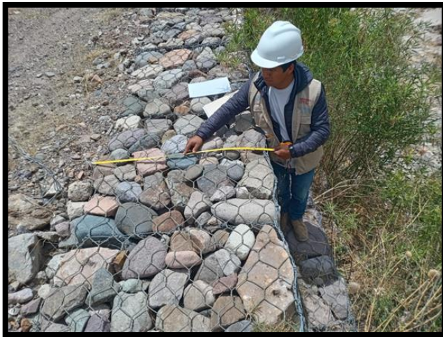
Figura 12: evaluación en la progresiva 0+800 - 0+900
