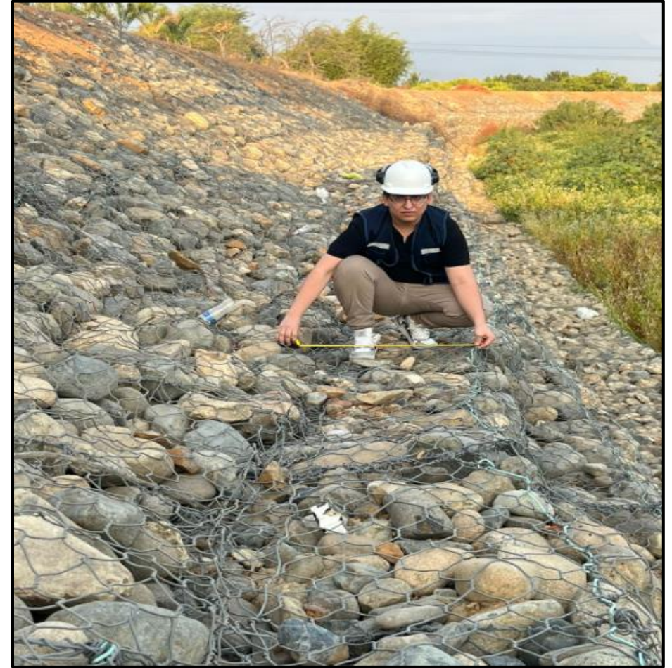
Figura 4: Realizando algunas observaciones del muro de gavión
