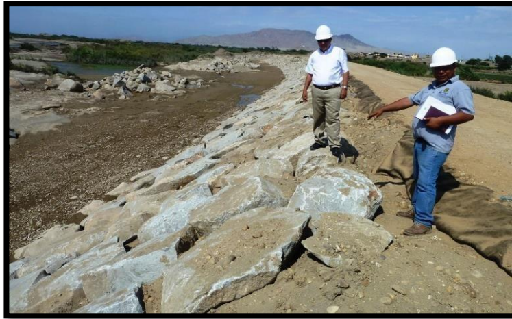
Figura 12: Mejora de defensa ribereña Fuente: Evaluación de patologías (36)
