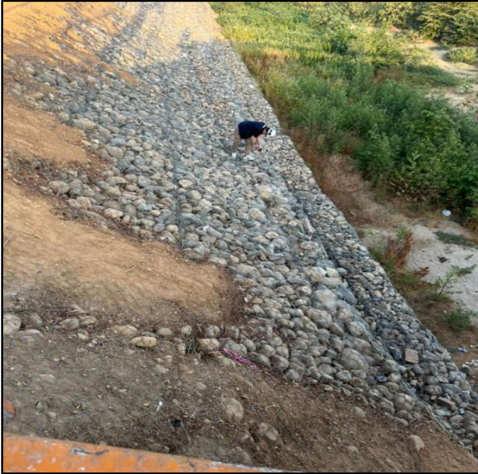
Figura 3: Foto frontal del muro de gavión del río Ñacara
