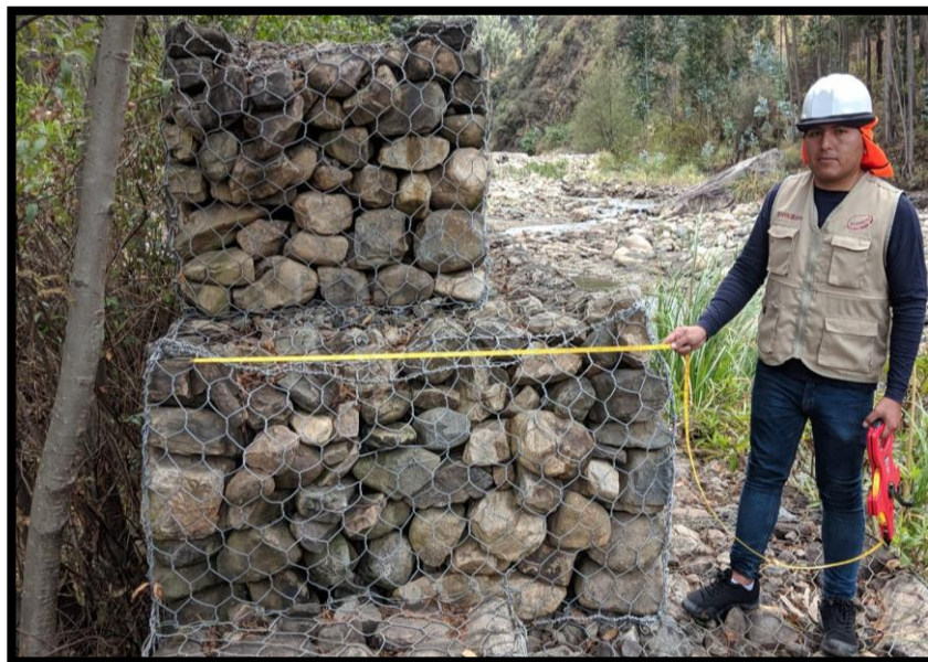
Figura 17: Muro de Gavión en buen estado tramo 0+150
