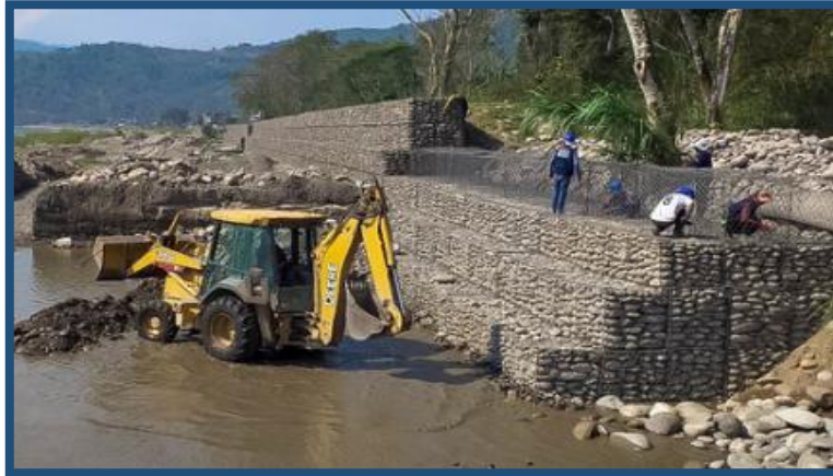
Figura 03 : Muro de Gaviones
