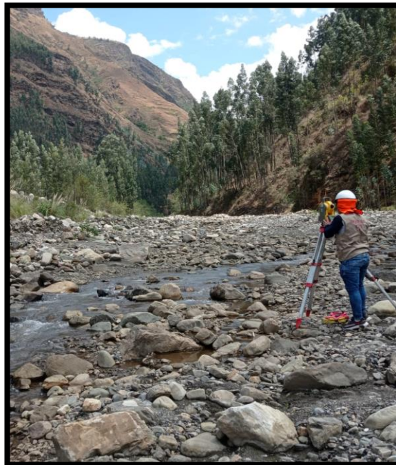
Figura 13: Levantamiento topográfico muro de gavión
