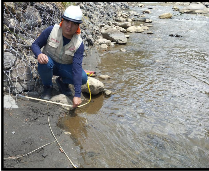
Figura 12: Acumulación de sedimentos de 35 cm
