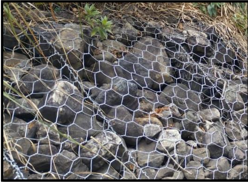
Figura 15: Estado bueno de la malla del muro de gaviones
