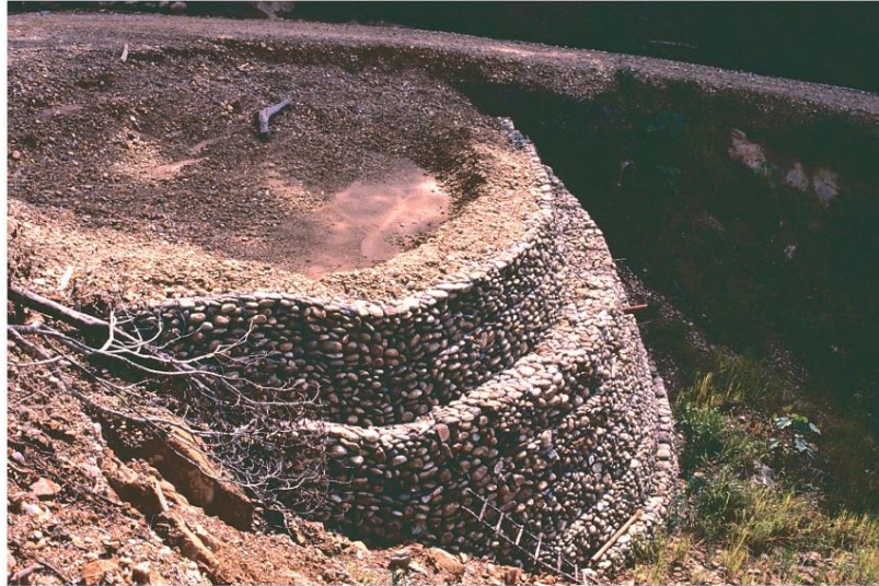
FOTOGRAFÍA 7.1 La flexibilidad de los gaviones permite deformaciones considerables.
