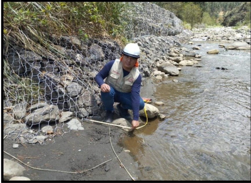
Figura 07: Colchón amortiguador que protege la base de la estructura
