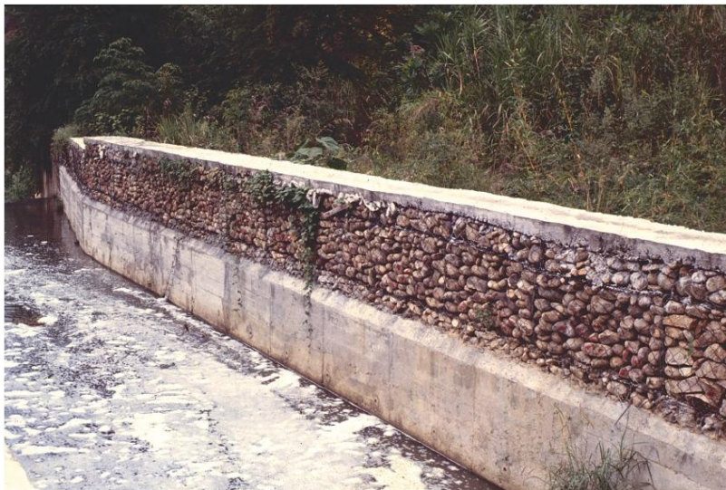
FOTOGRAFÍA 7.4 Para proteger el gavión contra la abrasión se puede revestir en concreto.
