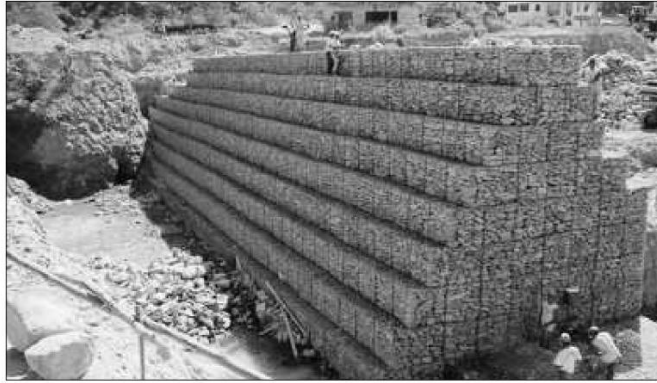
Figura 2.3.3 - Venezuela - Sección robusta donde se observa la monoliticidad del conjunto
