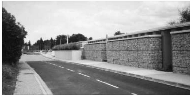
Figura 2.3.9 - França - Estructuras con función estética y arquitectónica
