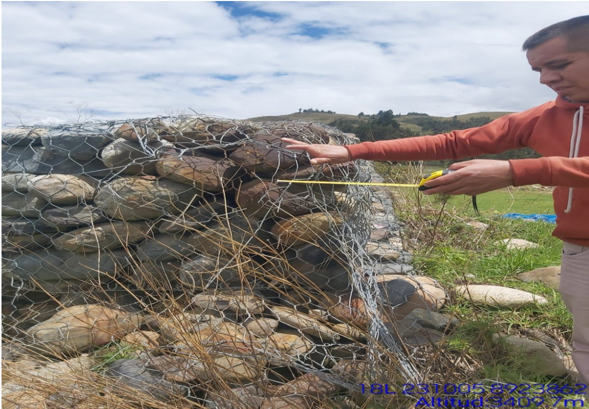
Figura 7: Rotura de malla Fuente: Elaboración propia
