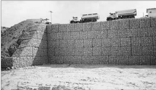
Figura 2.3.4 - Brasil - Contención para acceso a chancadora
