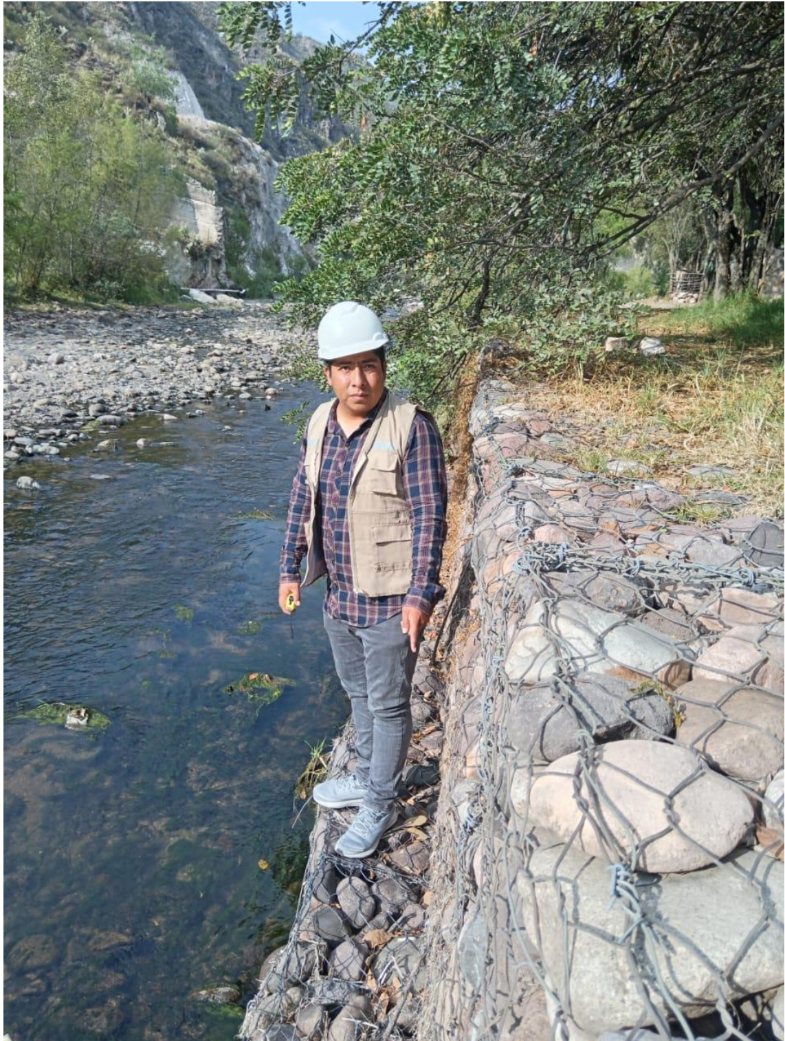
Figura 3: Evaluación del segundo nivel de los gaviones
