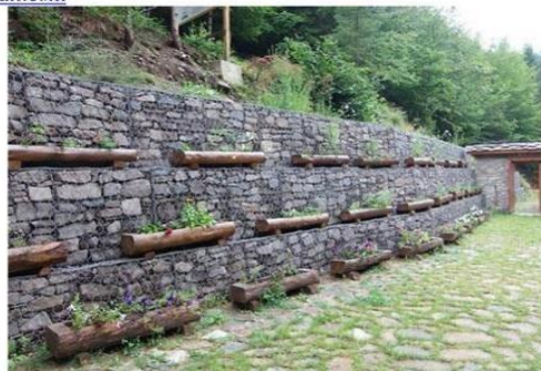
Figura 1. Estructura con gaviones. Fuente: http://www.solucionesespeciales.net/MedioAmbiente/Gaviones/Gaviones.aspx
