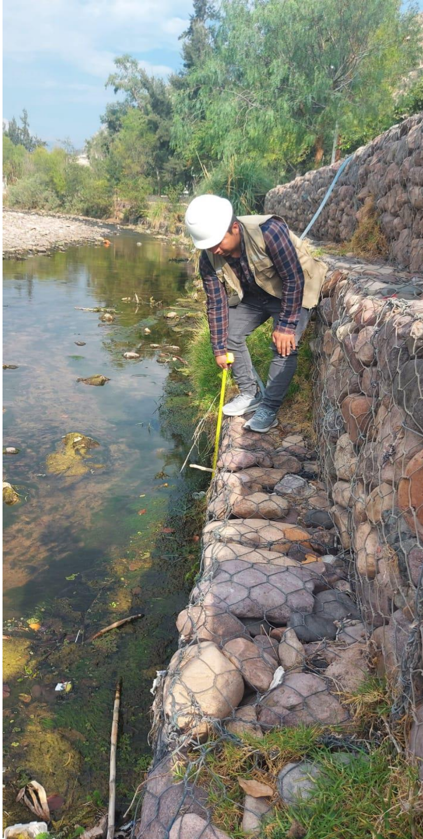
Figura 8: Medida de la altura del gavi3n
