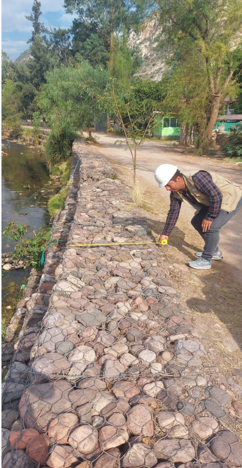
Figura 9: Ancho del muro de gaviones
