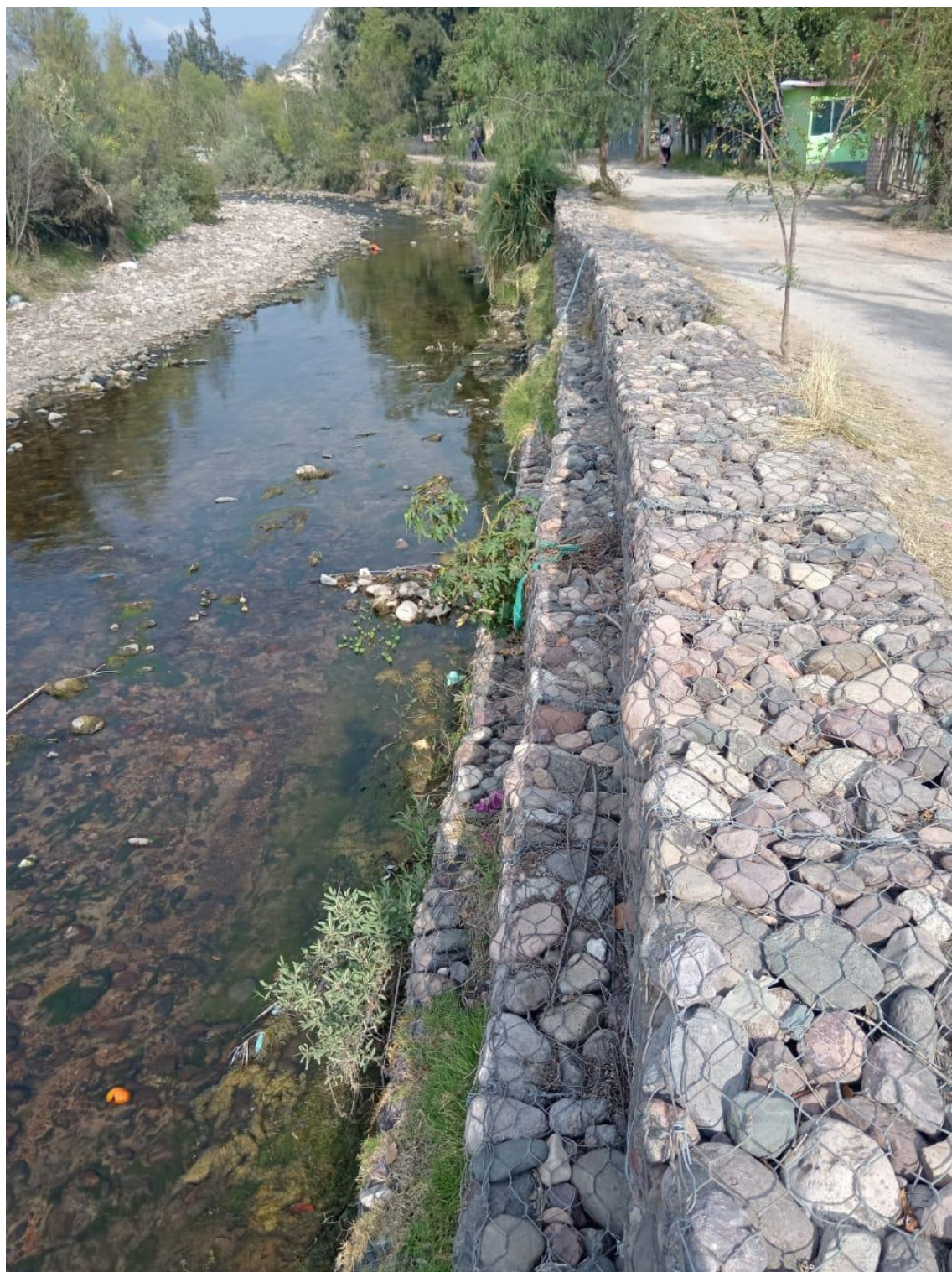
Figura 1: Muro de gaviones en evaluación
