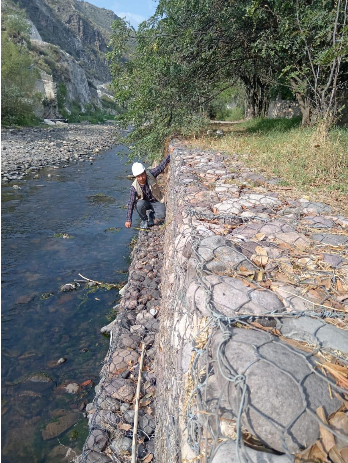
Figura 2: Medida del ancho del primer nivel del muro de gaviones
