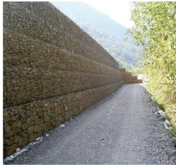
Figura 23. Muro de contención en carretera. Fuente: (A Bianchini, 2017)
