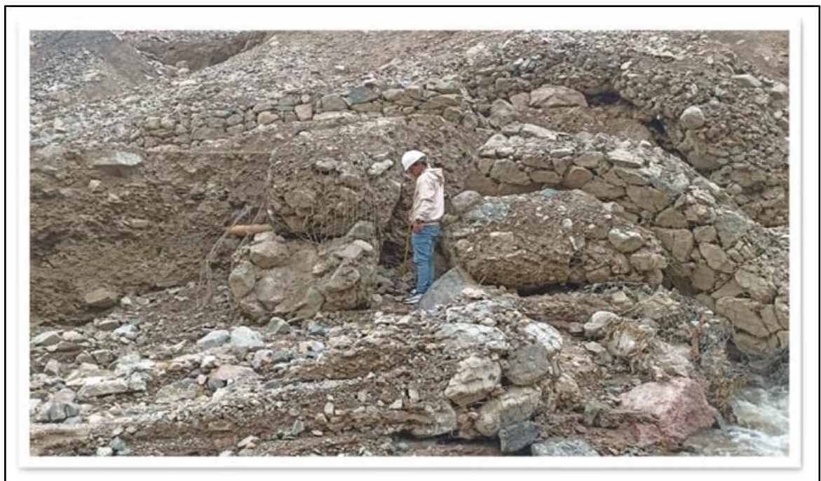
Figura 12: Estado actual del muro de gavión
