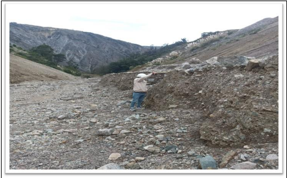
Figura 19: Altura de la socavación 1.80 mt
