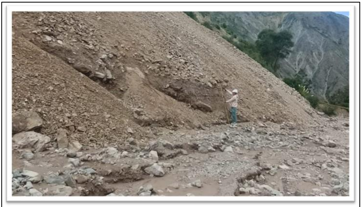
Figura 14: Muro de gavión enterrado por deslizamiento
