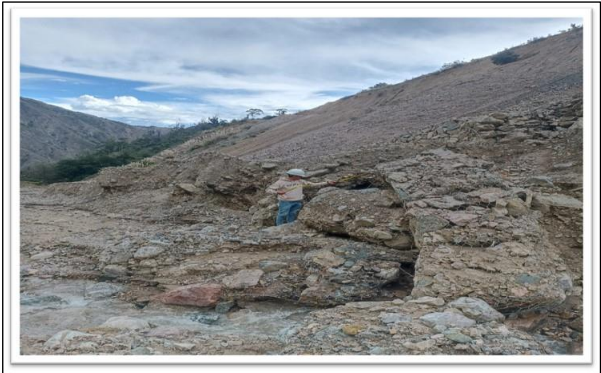
Figura 21: Rotura de la malla cada metro y 50 cm
