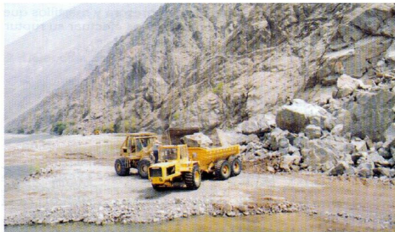
Foto N°6-Carguío de roca con equipo
