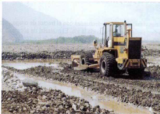
Foto N°3- Preparación de vía de acceso
