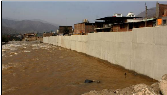
Figura 5. Muros de concreto armado en defensa ribereña
