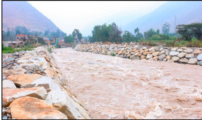
Figura 6. Enrocado para defensa ribereña
