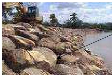
Figura 6.5 Fotografía de un enrocado con roca colocada
