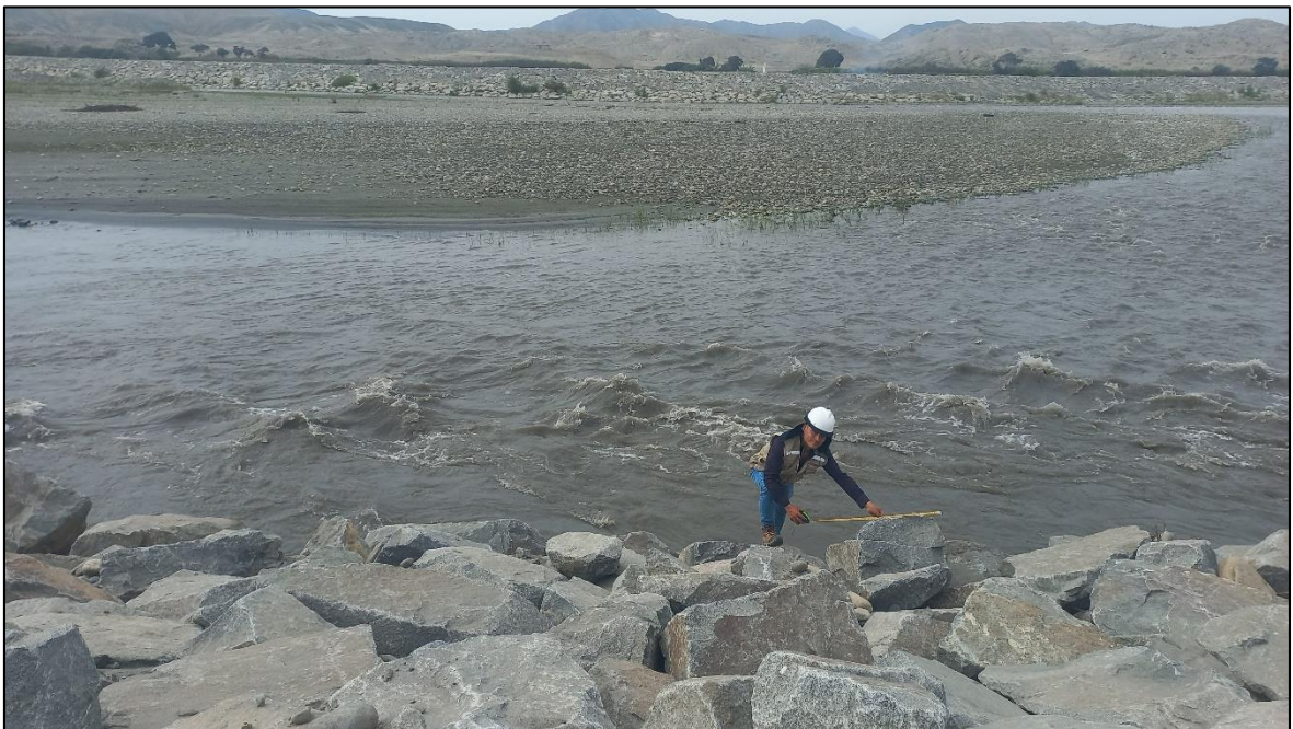
Figura 9. Medición del enrocado (50'' a 70'').
