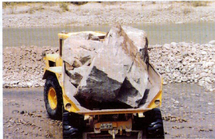
Foto N°7- Volquete especial trasportando roca
