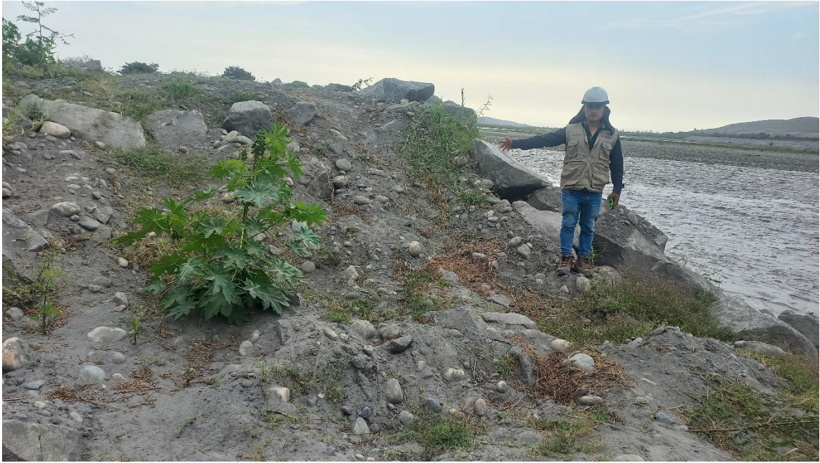
Figura 14. Observamos el final del enrocado en la progresiva el km 14 +250
