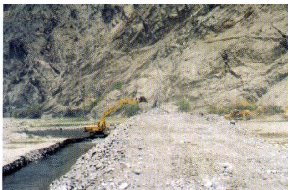
Foto N°4. Tractor iniciando armado de terraplén
