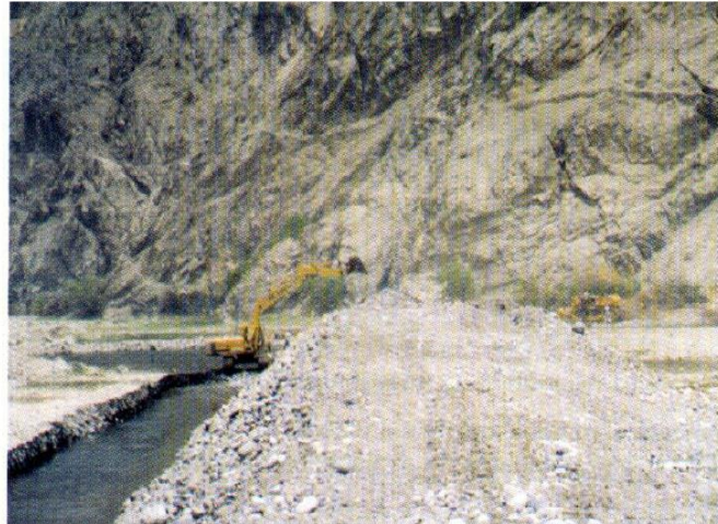
Foto N°5. Excavadora culminando la apertura de la uña de estabilidad
