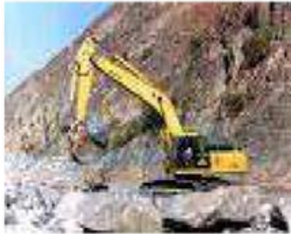
Figura 6.7. Volcado del enrocado con maquinaria
