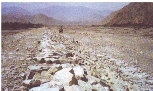
Figura 6.3. Fotografía de un enrocado con roca colocada al volteo
