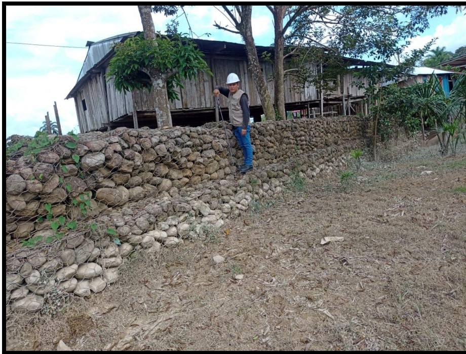
Figura 10: realizando evaluación de muros de gaviones
