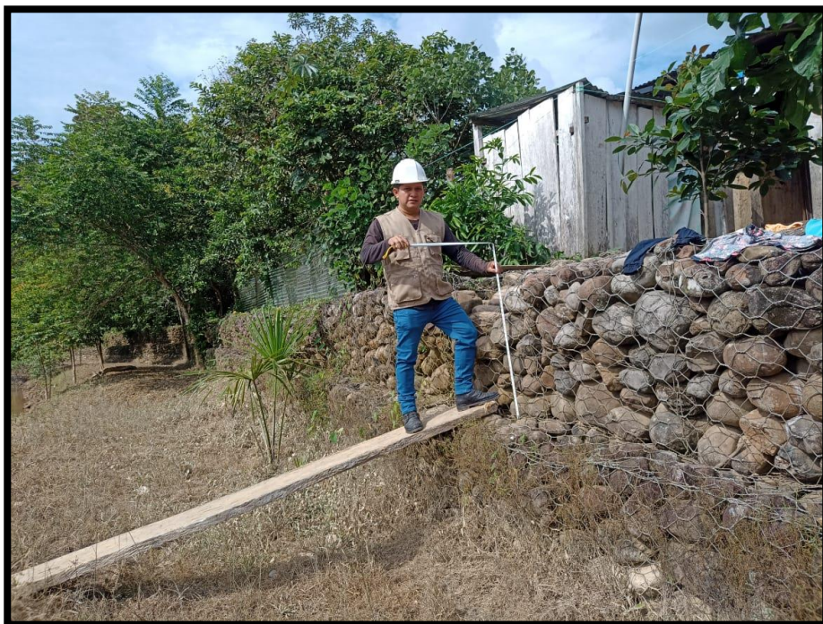
Figura 17: realizando evaluación de muros de gaviones
