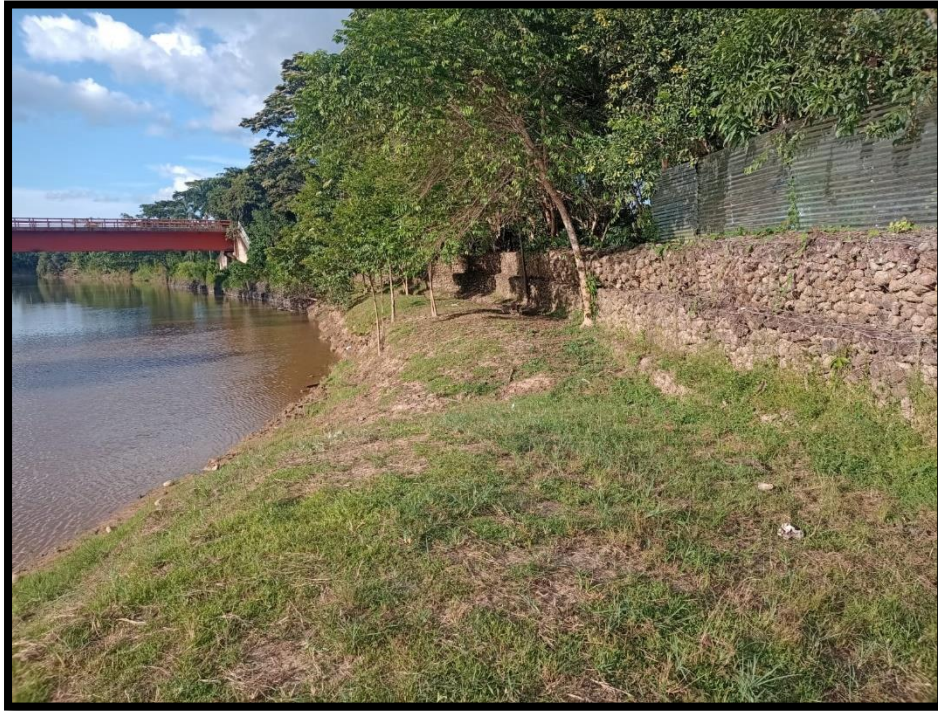
Figura 4: Vista muro de gaviones
