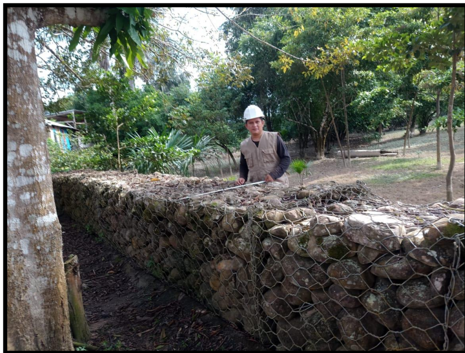
Figura 11: realizando evaluación de muros de gaviones
