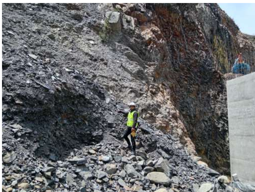
Imagen 13: Inspección en el Río Llactabamba
