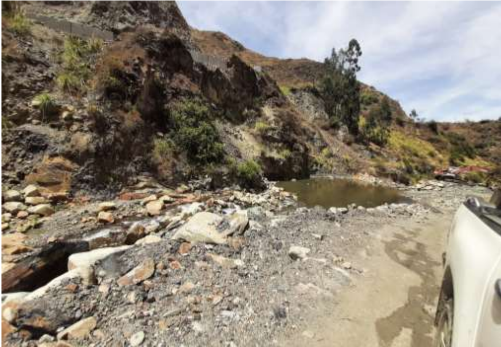
Imagen 8: Zona Afectada por Erosión
