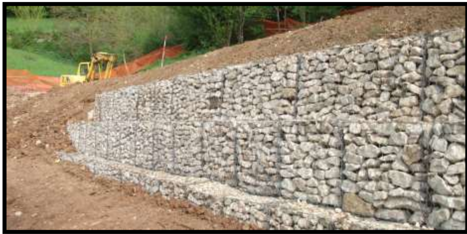
Imagen 1: Estructuración de Gaviones
