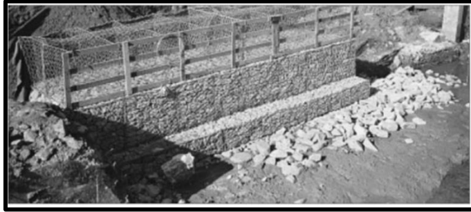
Figura 1: Gavión tipo caja
