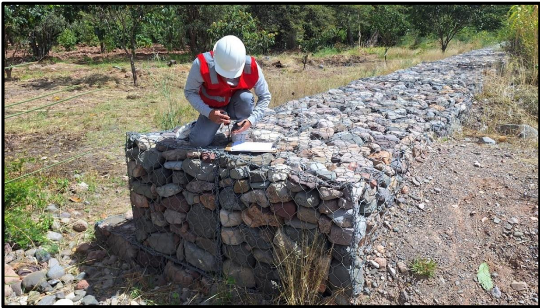
Figura 15: Se muestra el inicio del muro de gavión
