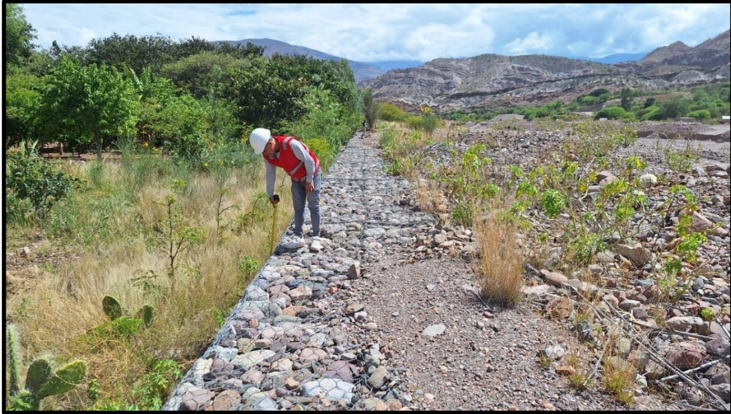
Figura 16: Se ve la altura de gavi3n del tercer nivel
