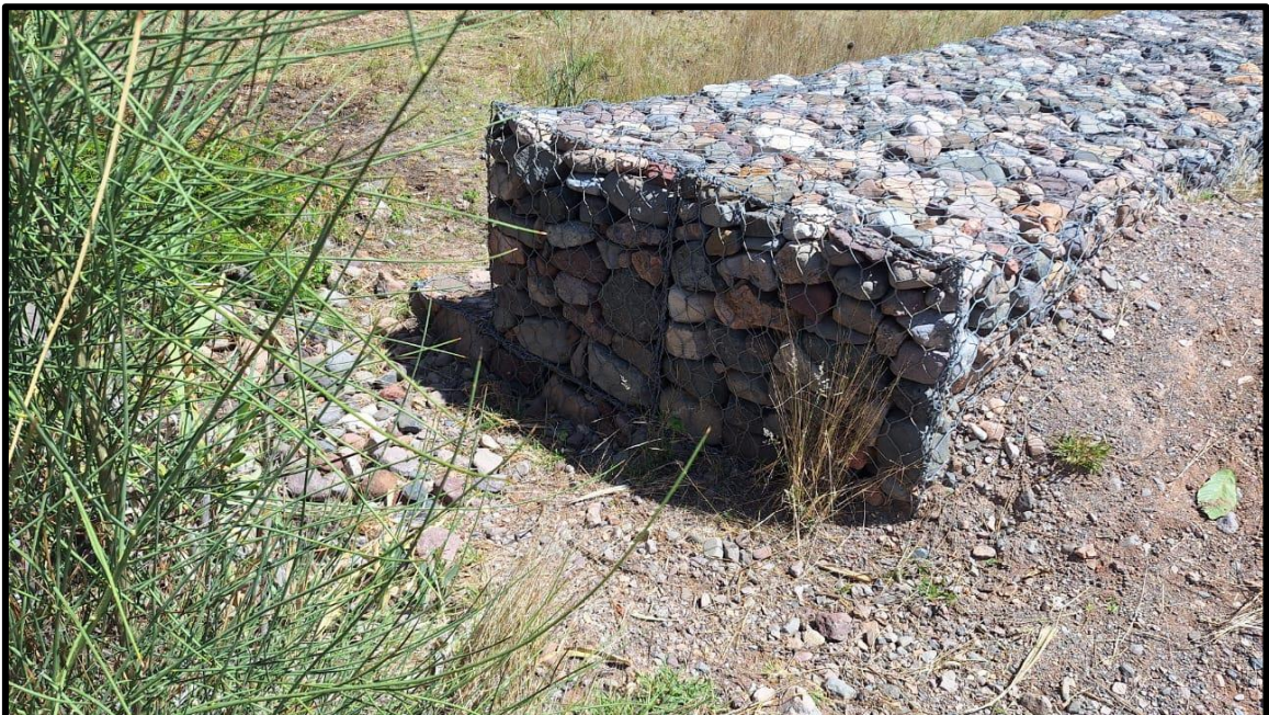
Figura 9: Donde inicia el muro de gavión
