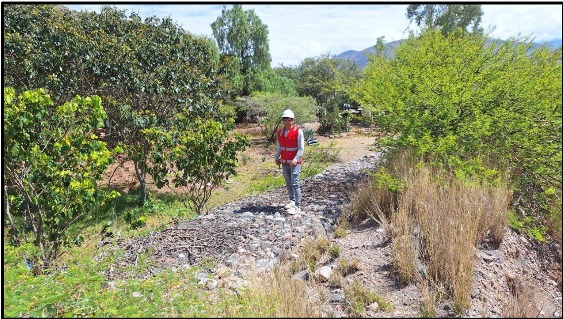
Figura 11: Tramo con presencia de vegetación
