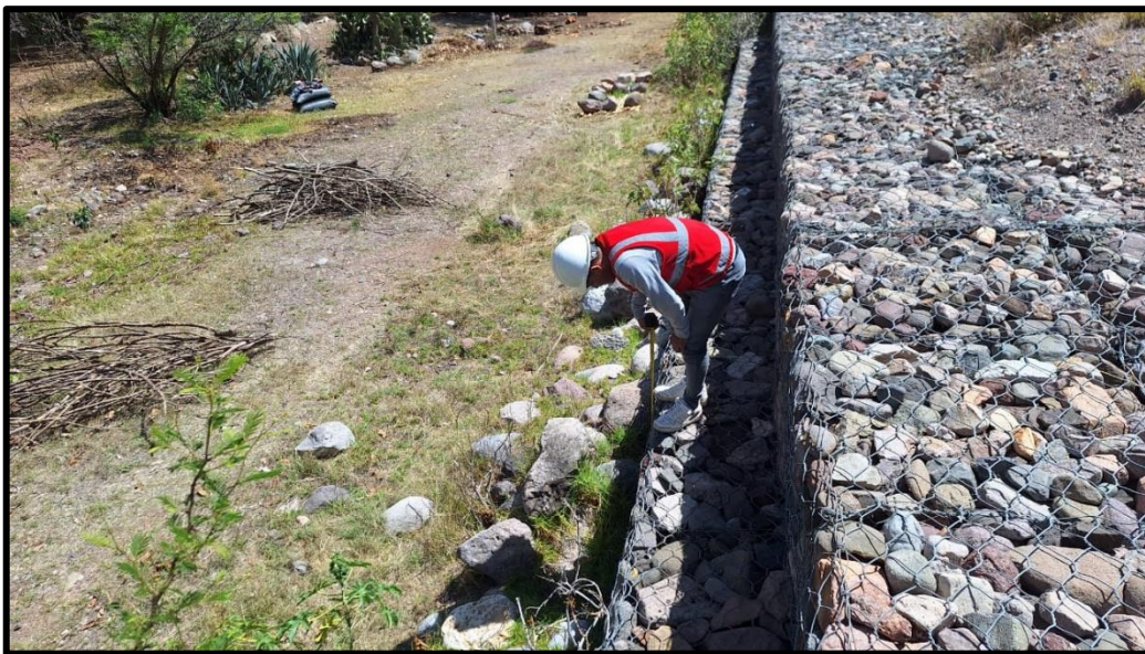
Figura 19: Se mide la altura de muro del segundo nivel
