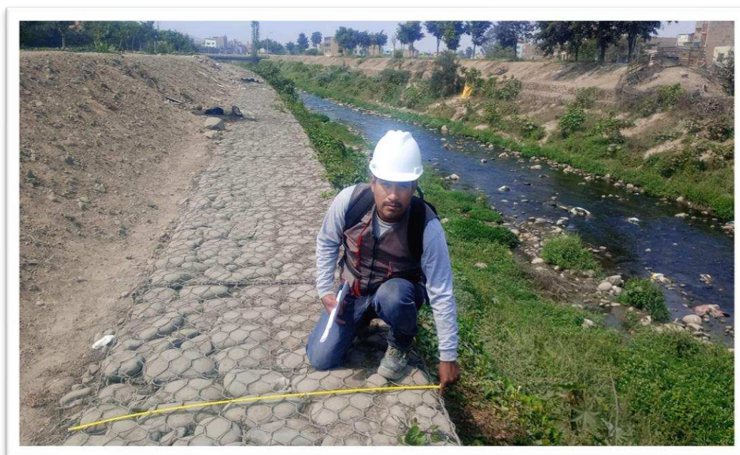
Figura 14: Medición de la longitud horizontal progresiva 0+200-0+300, margen derecho del Río Chillón.
