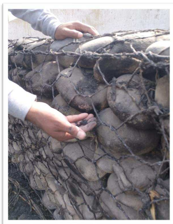
Figura 20: Calcinado de malla hexagonal de forro plastificado, progresiva 0+340 a 0+370 del Río Chillón.
