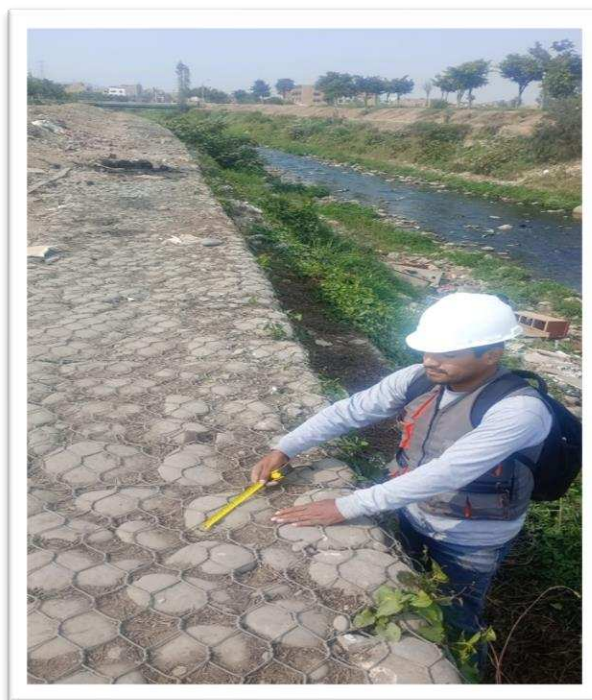
Figura 15: Medición del tamaño del canto rodado en el muro de gaviones del Río Chillón.
