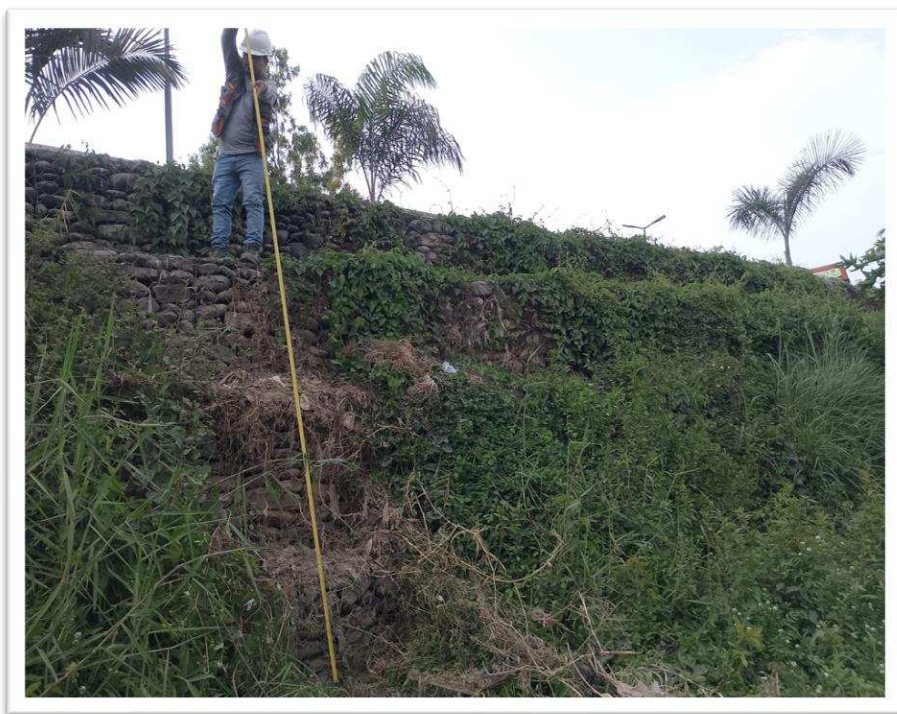
Figura 13: Medición de la longitud vertical progresiva 0+400-0+500, margen derecho del Río Chillón.
