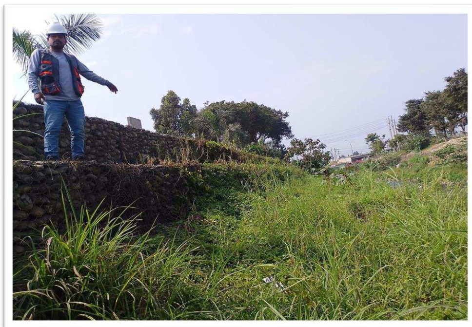
Figura 17: Exceso de vegetacion desde la progresiva 0+000 a 0+120, margen derecho del Río Chillón.
