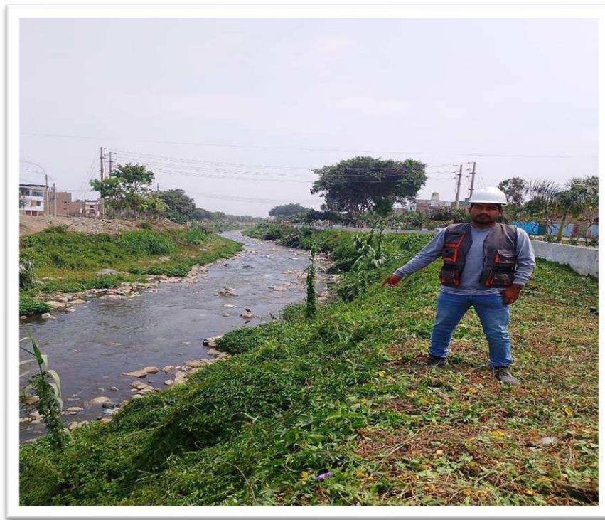
Figura 9: Evaluación del inicio del Muro de Gaviones, progresiva 0+000 del Río Chillón
