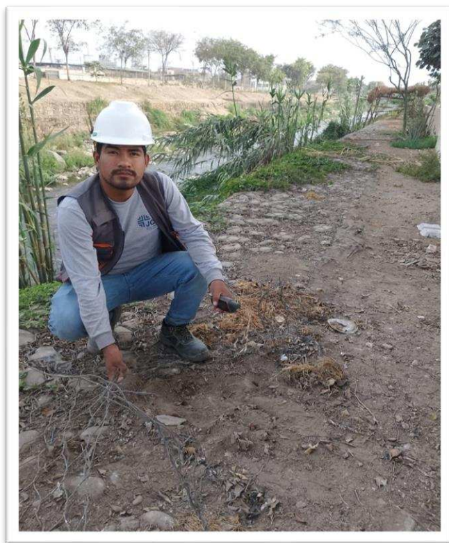
Figura 21: Desarmado del enmallado, progresiva 0+150 a 0+170 del Río Chillón.
