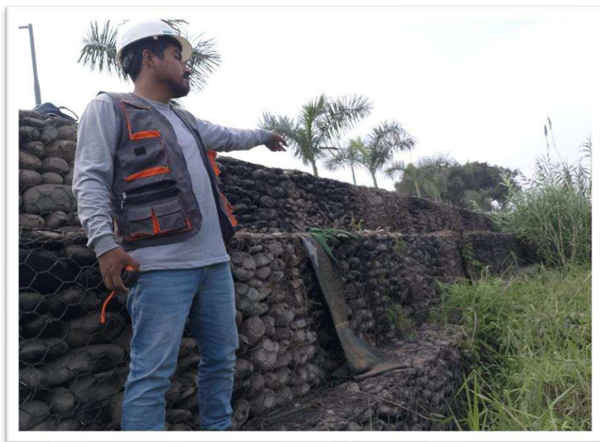
Figura 19: Quemado de superficie vegetal que cubre al muro de gavion, progresiva 0+400 a 0+450 del Río Chillón.
