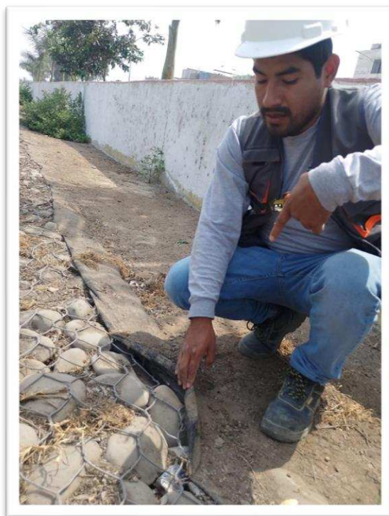
Figura 26: Geotextil desde la progresiva 0+000 a 0+500 del Río Chillón.
