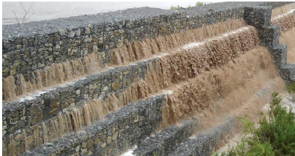
Figura 1: Muro de gaviones
