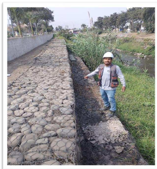
Figura 10: Parte culminar de la evaluación del Muro de Gaviones, progresiva 0+500 del Río Chillón
