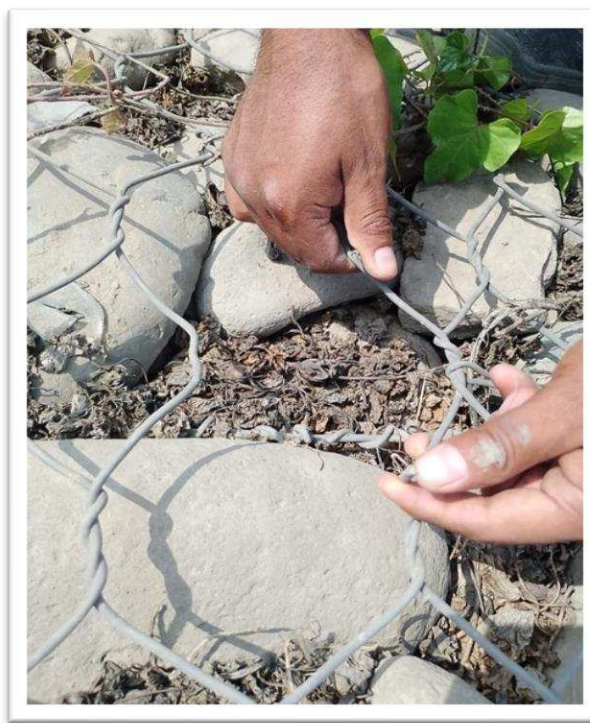
Figura 25: Deshilado de la malla hexagonal, en la progresiva+450 a 0+470 del Río Chillón.
