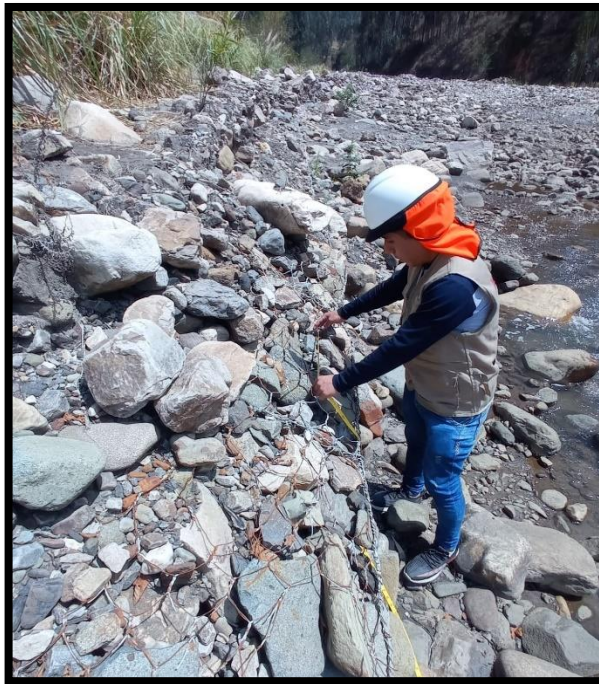
Figura 13: Muro de gavi3n colapsado
