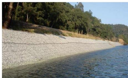
Figura 2. Gaviones para contención fluvial. Fuente: (A Bianchini, 2017).
