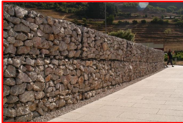
Figura 04: Muro de Gaviones
