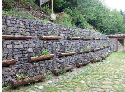
Figura 1. Estructura con gaviones. Fuente: http://www.solucionesespeciales.net/MedioAmbiente/Gaviones/Gaviones.aspx
