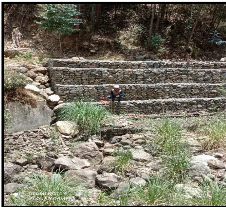
Figura 12: Muro en buen estado, medición de la altura total presencia de vegetación
