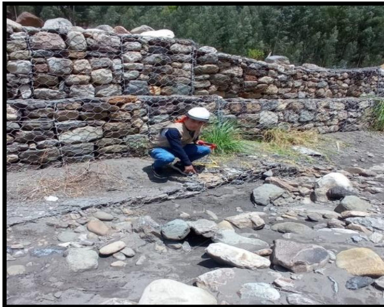
Figura 08: Sedimentación, y colchón amortiguador.
